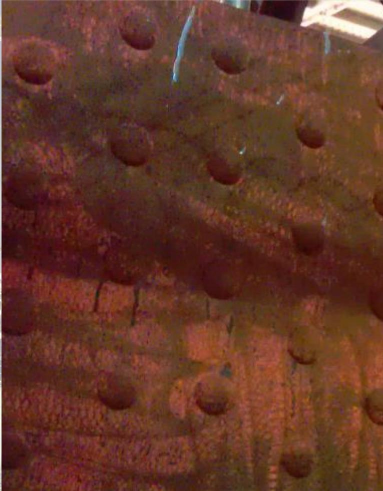
Les zones corrodées feront l'objet d'un décapage à l'eau sous Ultra Haute Pression (supérieure à 2500 Bars) jusqu'à obtention du degré de soin DHP4, le reste des surfaces fera l'objet d'un avivage des anciens fonds qui seront donc laissés en place.
