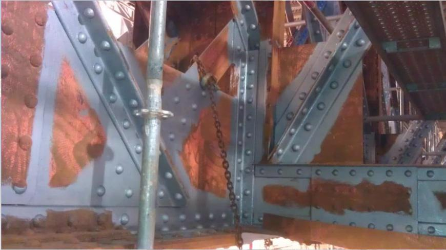
Afin de parfaire la protection des rivets, et arrêtes vives, des pré touches sont réalisées à la brosse sur ces zones réputées sensibles et difficilement traitables au pistolet Airless.
