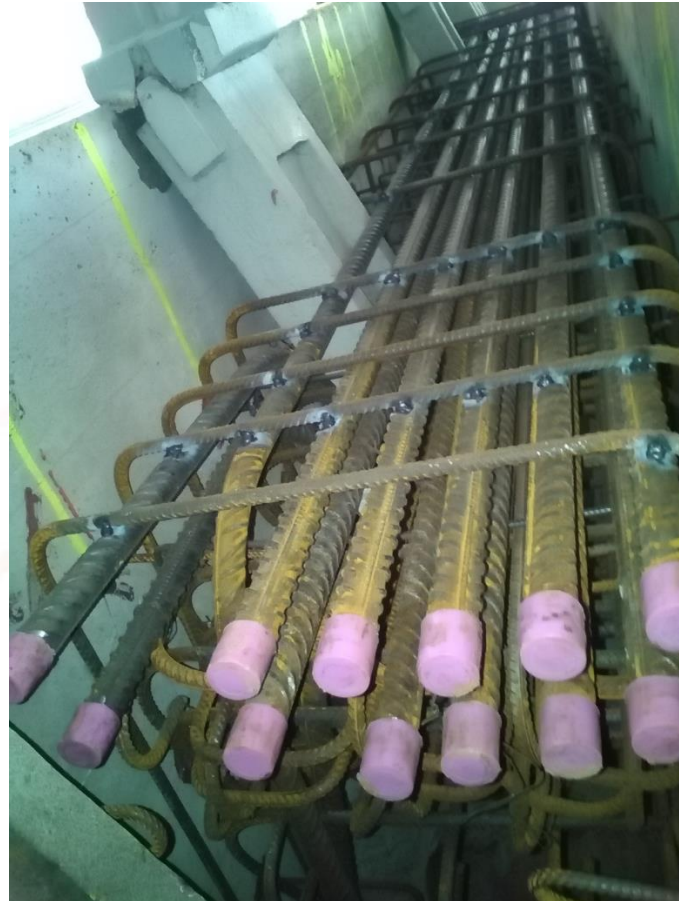
Ferrailage des chevêtres en tête de pile
