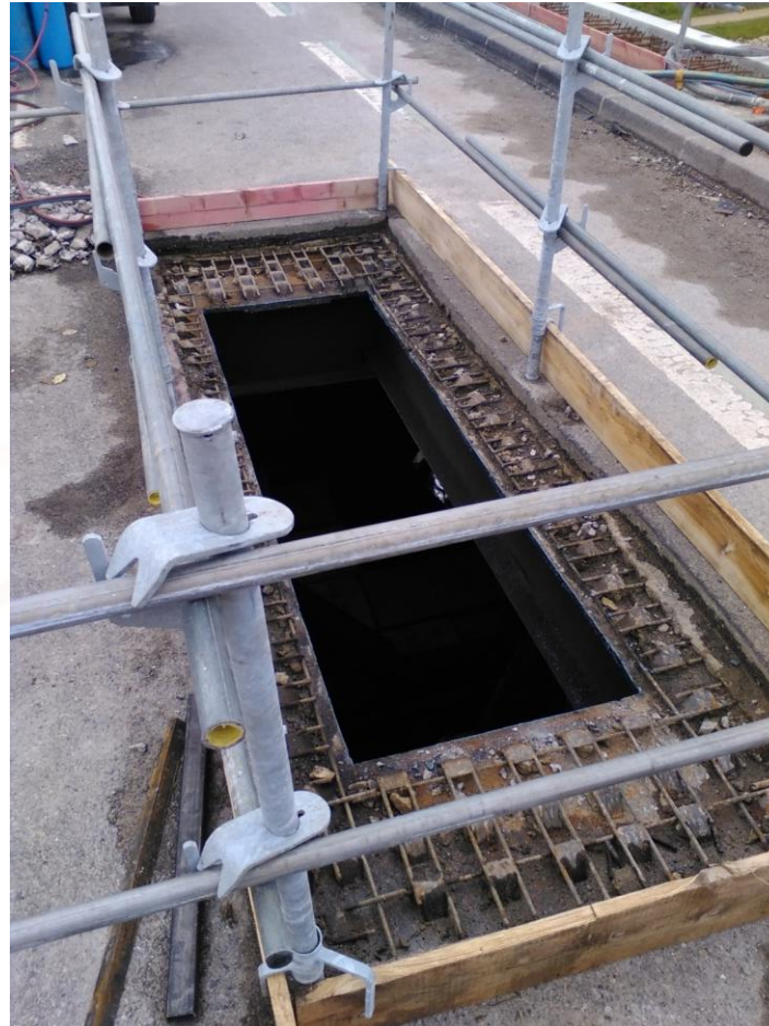
Ouverture pour approvisionnement des renforts
