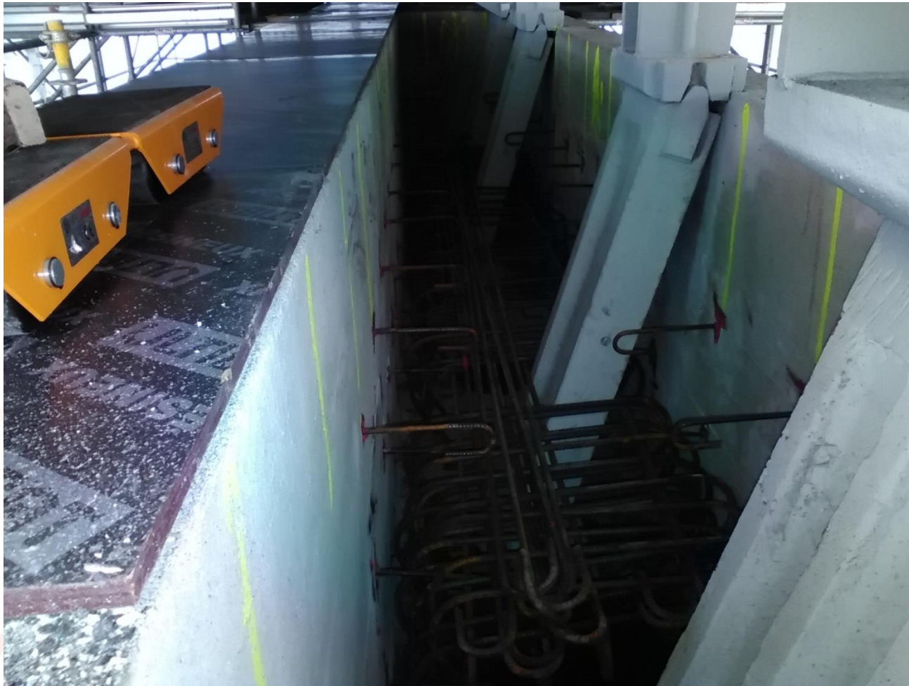
Ferrailage des chevêtres en tête de pile
