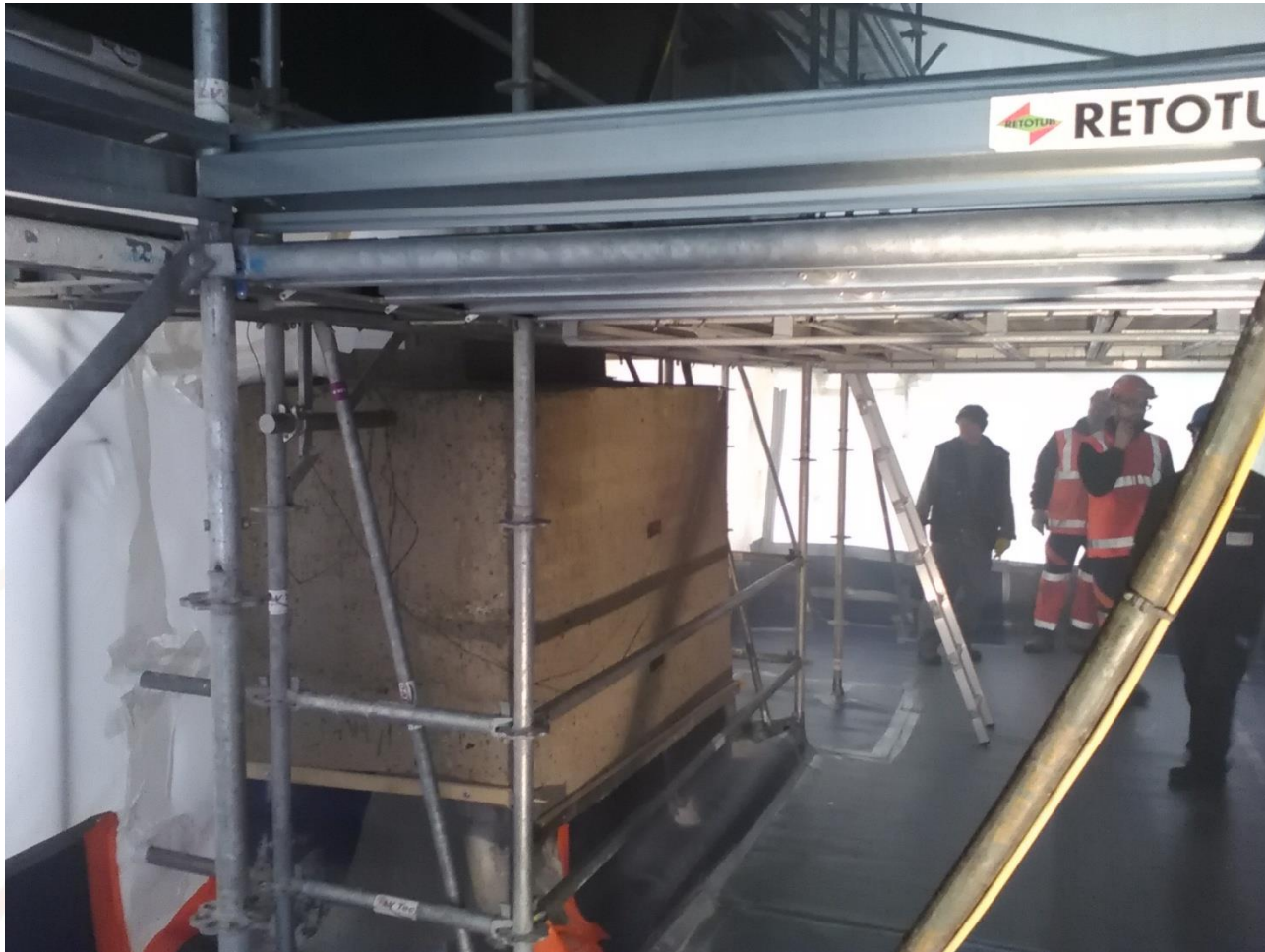
Désamiantage entre caissons
