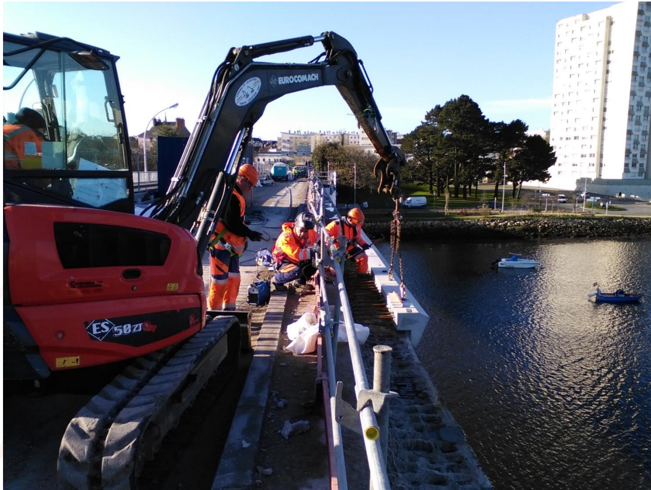
Mise en place des corniches
