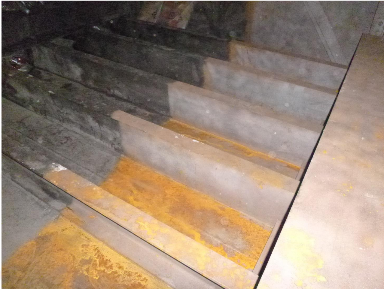
Désamiantage intérieur caisson
