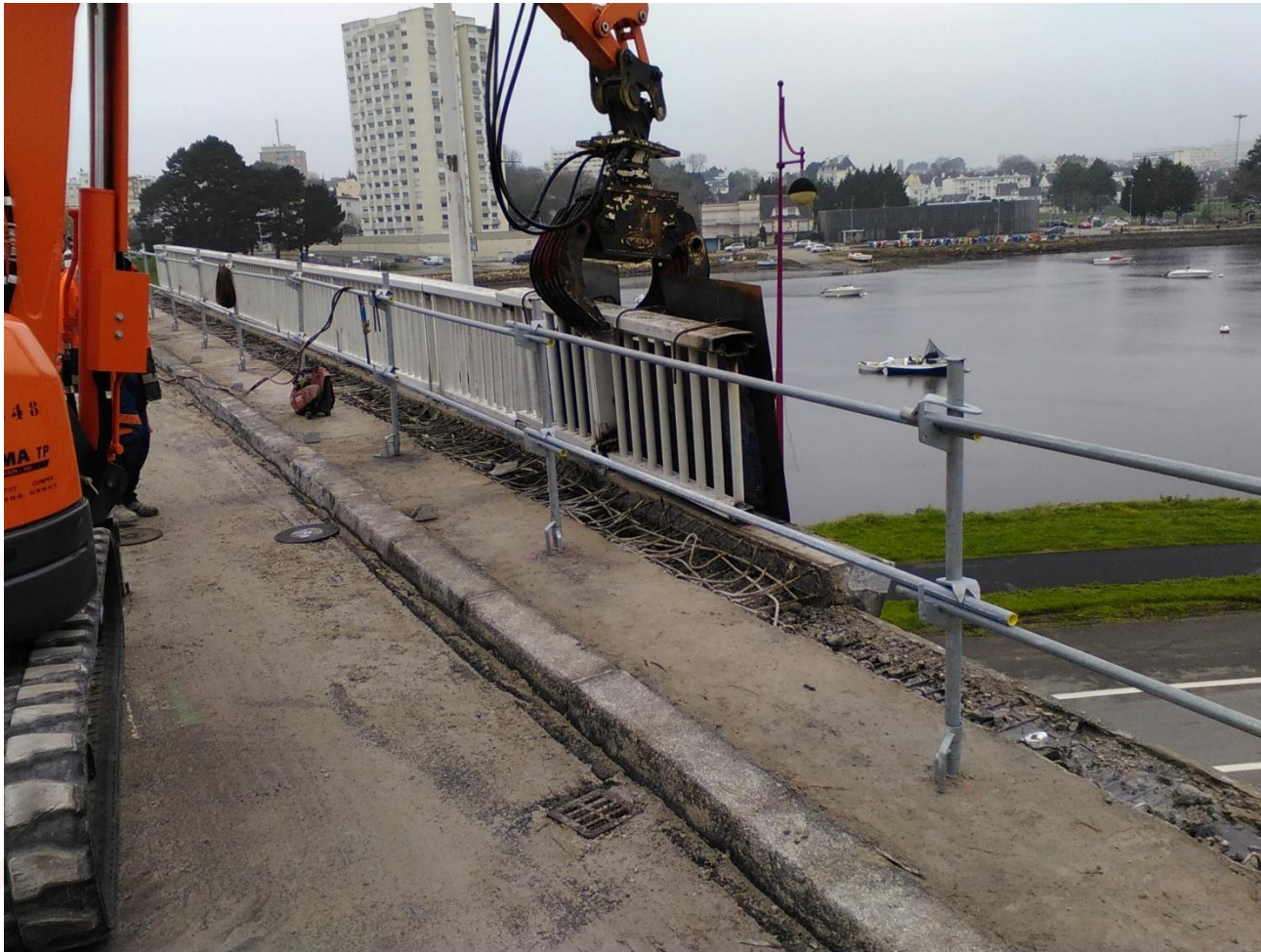
Dépose des superstructures
