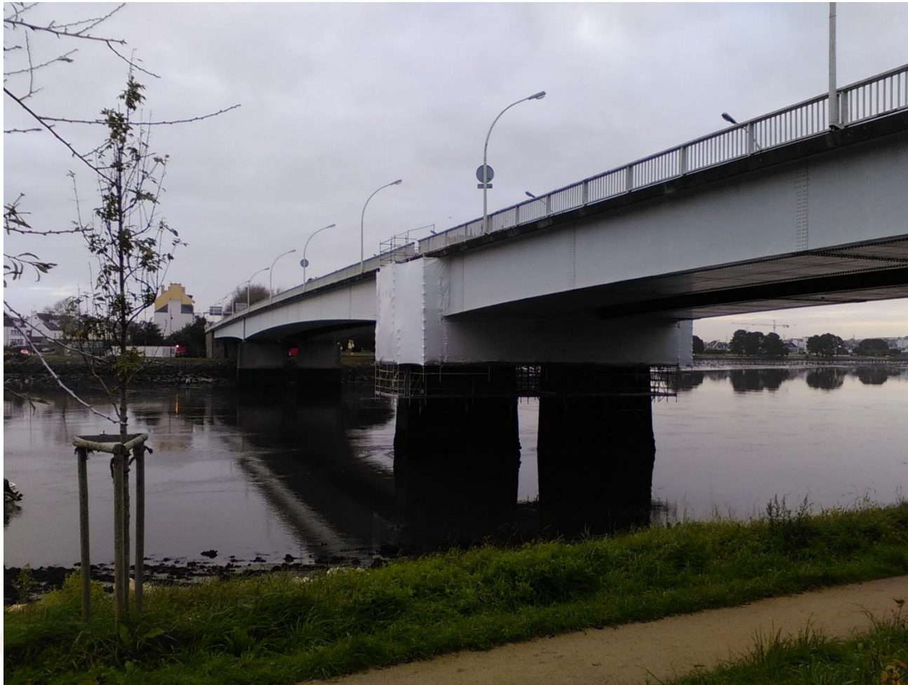
Echafaudage confiné P2
