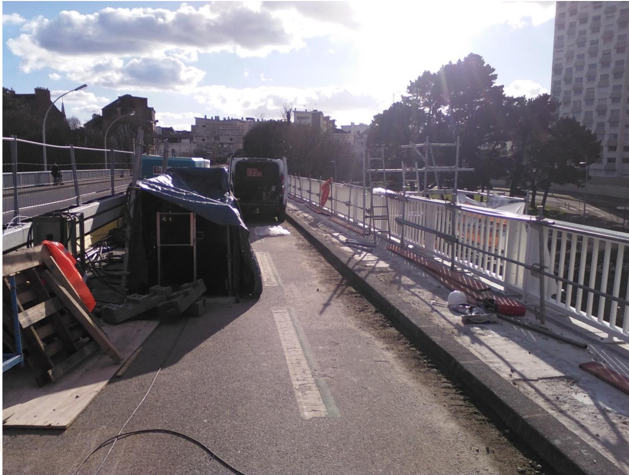
Mise en place des garde-corps
