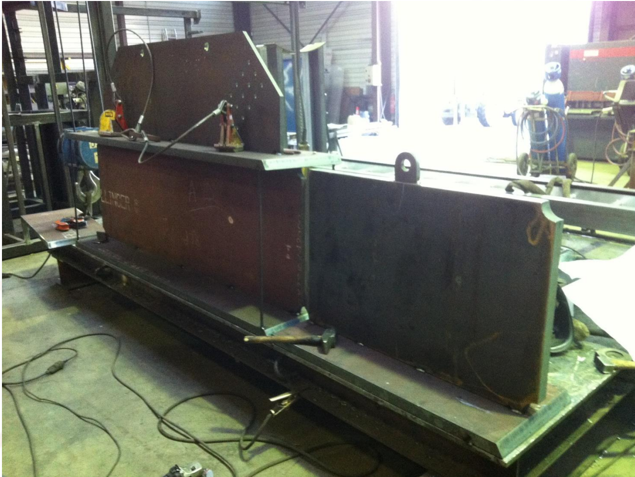
Fabrication du renfort
