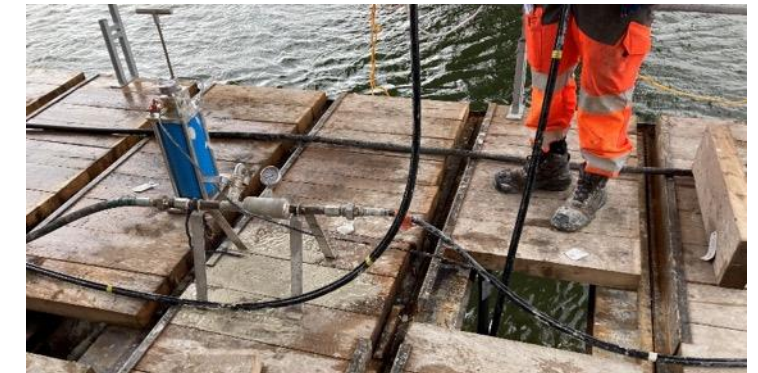
Injection de traitement en cours Descente de l'obturateur à la cote du traitement, puis gonflage de l'obturateur double grâce à une pompe Pavayet
