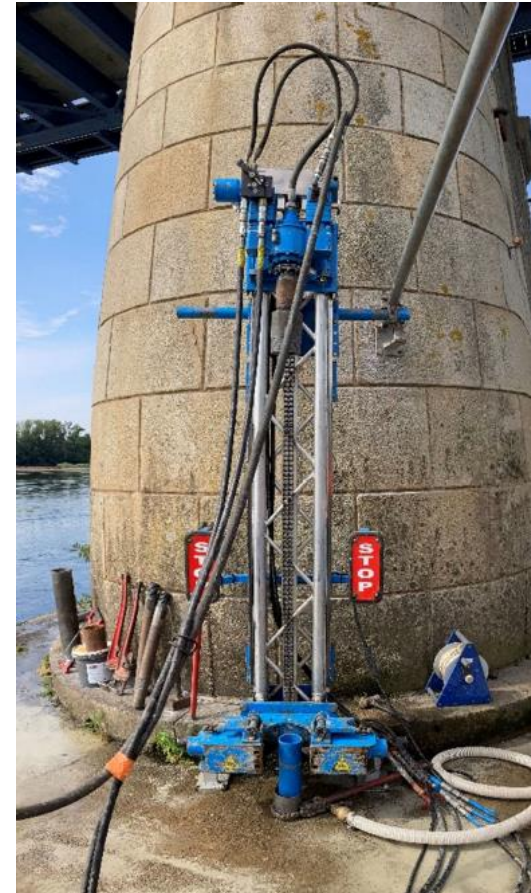
Mises en place du mât de forage – Pile P3
