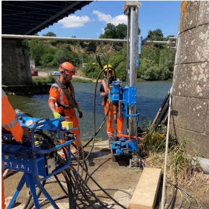
Mises en place du mât de forage – Pile P3
