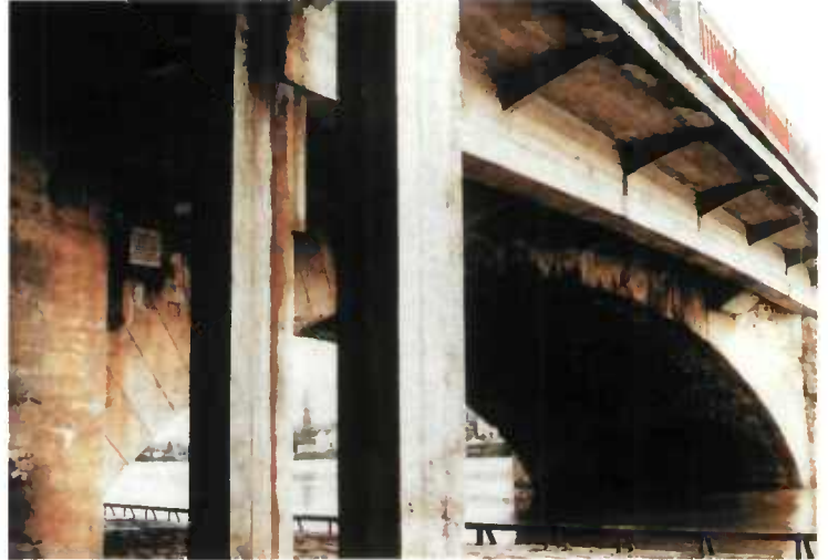
Figure 108 - Élargissement n'ayant pas fait l'objet d'une étude architecturale
