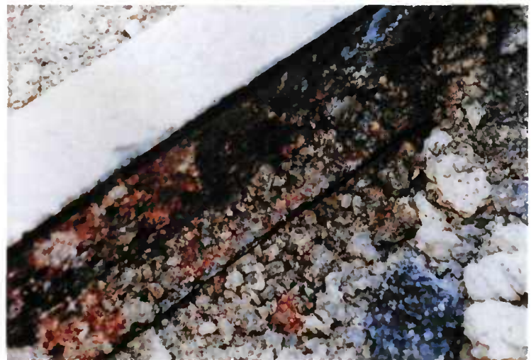
Figure 102 - exemple de poutre transversale non protégée par une étanchéité
