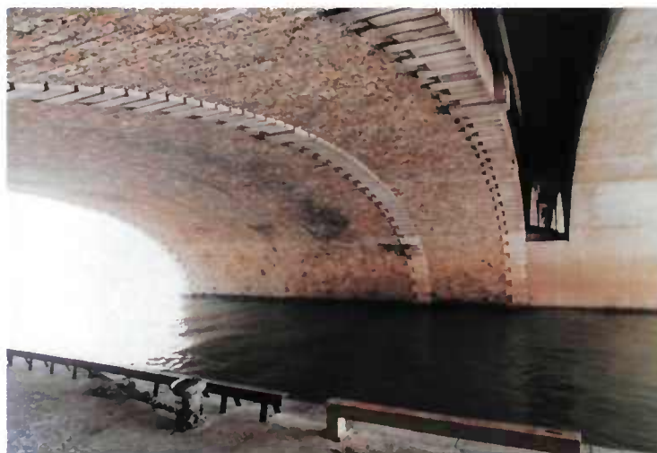
Figure 119 - pont de Bercy
