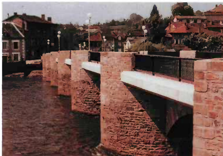
Figure 55 - pont d'Aixe-sur-Vienne ouvrage après travaux
