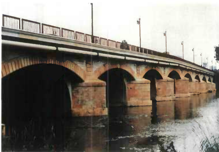
Figure 113 a - pont de Thionville à Metz
