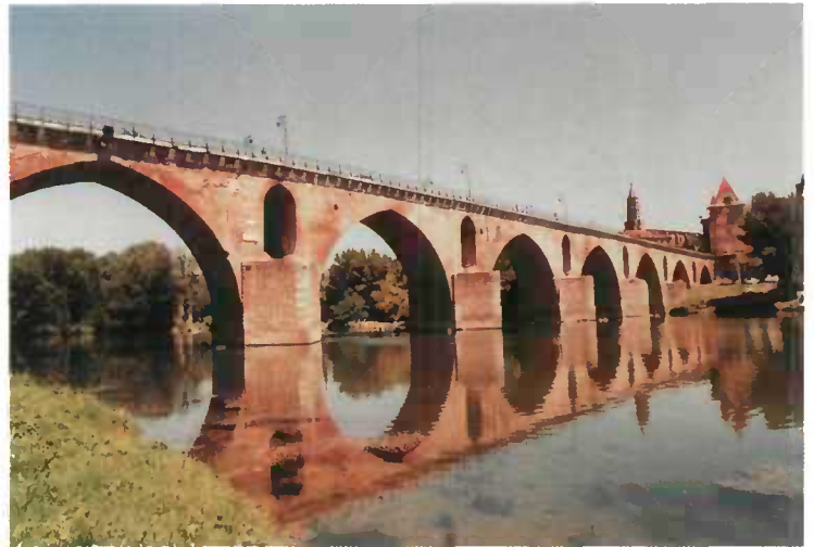
Figure 6 - pont vieux de Montauban
