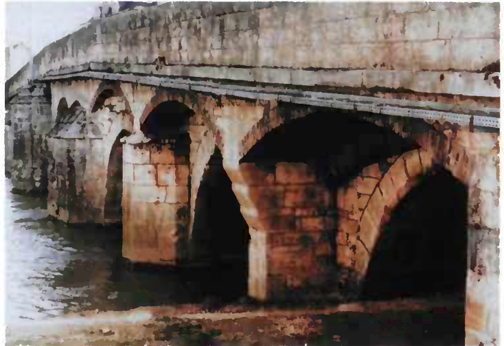
Figure 47 - pont Notre-Dame à Tonnerre : élargissement en pierres
