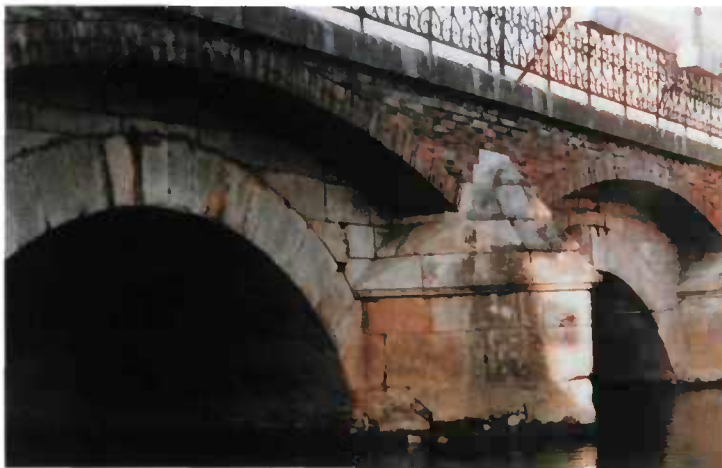
Figure 48 - autre pont de Tonnerre : élargissement en briques
