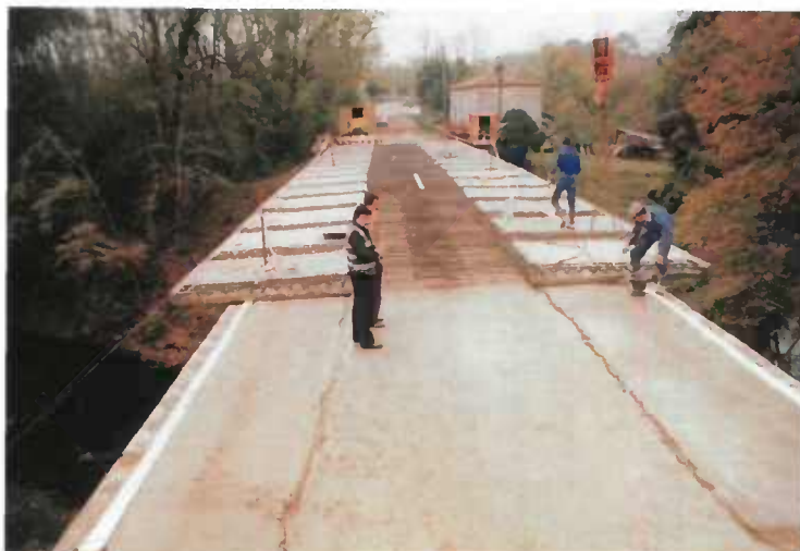
Figure 79 - mise en place des éléments préfabriqués
