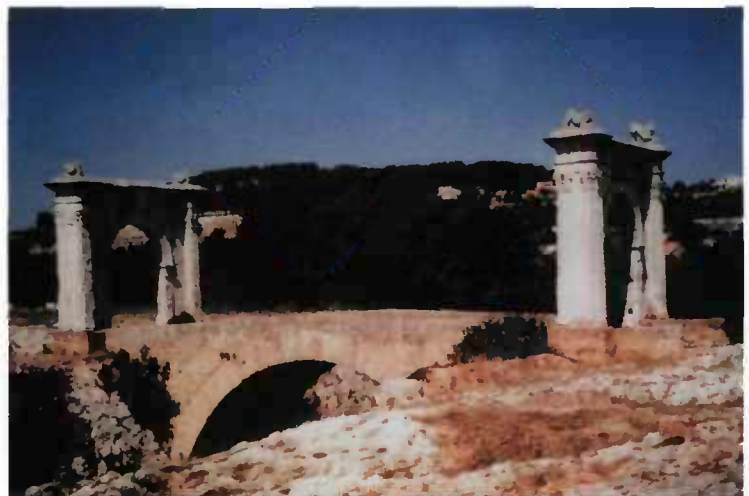
Figure 1 - pont Flavier sur la Touloubre
