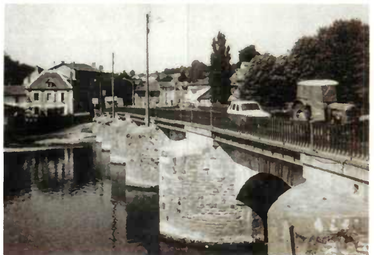
Figure 54 - pont d'Aixe-sur-Vienne ouvrage avant travaux
