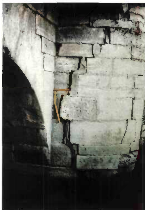
Figure 106 - désordre d'un avant bec insuffisamment fondé et supportant un élargissement
