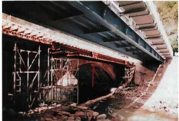
Figure 83 - pont de Fraré en Ariège élargissement des culées par encorbellements avec contrepoids Mise en place d'un pont provisoire pendant les travaux
