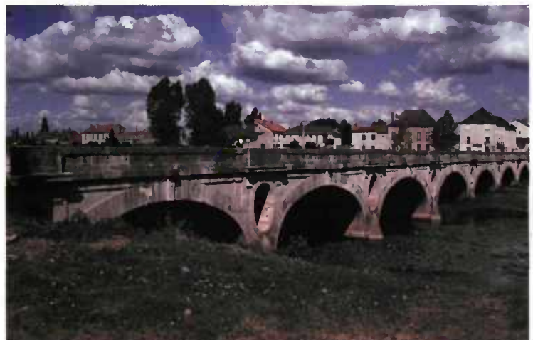
Figure 11 - pont des Échavannes
