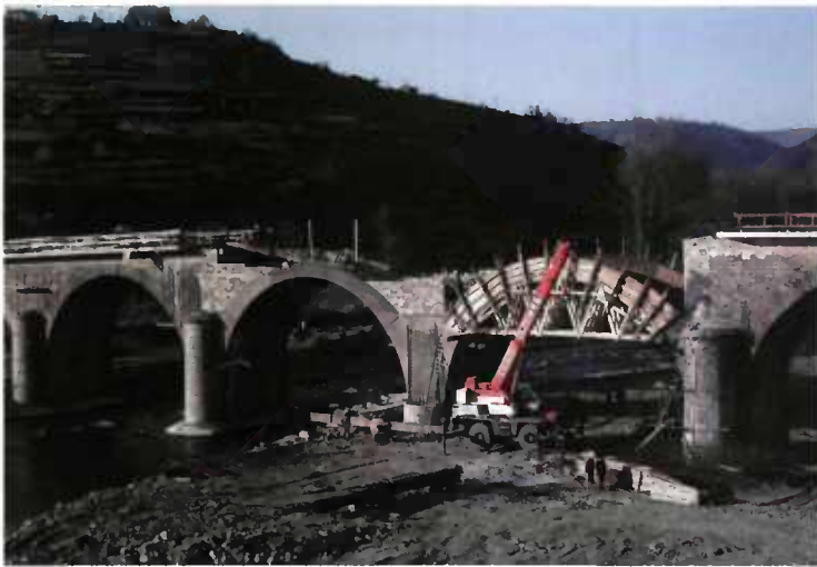
Figure 26 - pont de Navech
