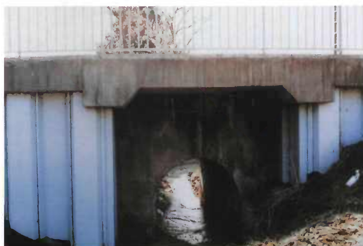
Figure 116 - élargissement par portique sur piliers en palplanches
