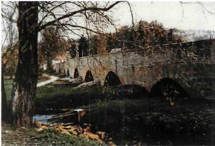
Figure 7 - pont de Prévile à Moulins-lès-Metz
