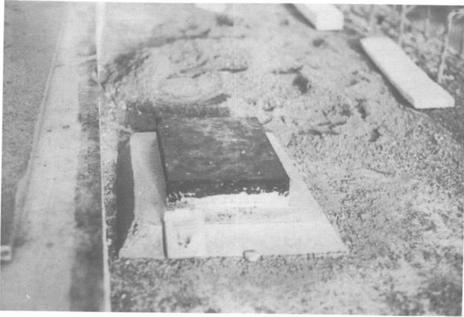
Photo n° 9 : Méthode de la boîte à sable : appareil d'appui sur son bossage et début de la mise en place du sable .
