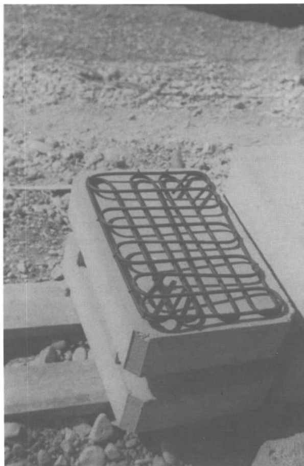
Photo 18: Bossage préfabriqué avec son frettage
