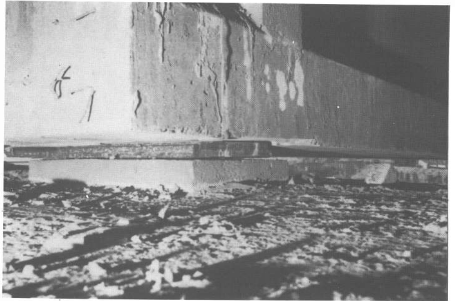
Photo n° 4 : Défauts des tolérances d'exécution ; l'appareil d'appui ne porte que sur une faible partie de sa surface .
