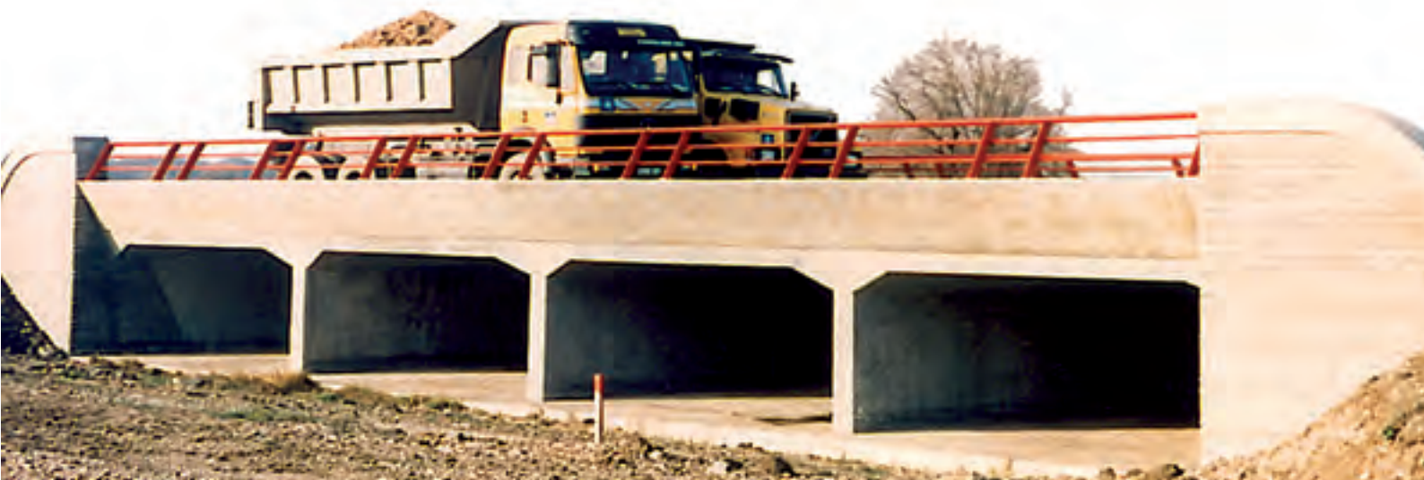
Figure 10 : chargement centré d'un portique à travées multiples.
