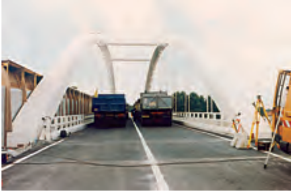
Figure 13 : mesure de flèches pendant les épreuves d'un bow-string.
