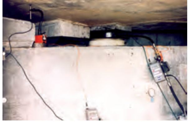
Figure 14 : appareillage pour pesée des réactions d'appui.
