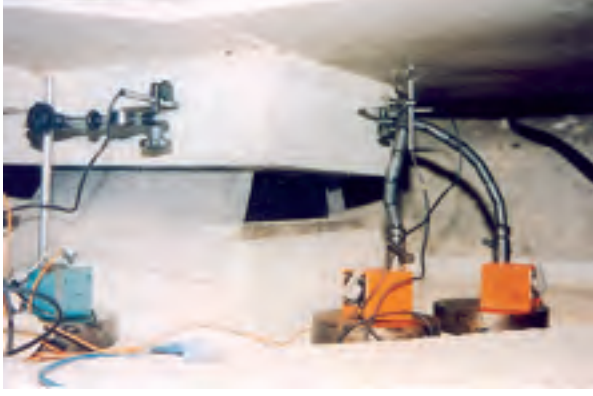
Figure 4 : capteurs pour mesures des déplacements d'un appareil d'appui.
