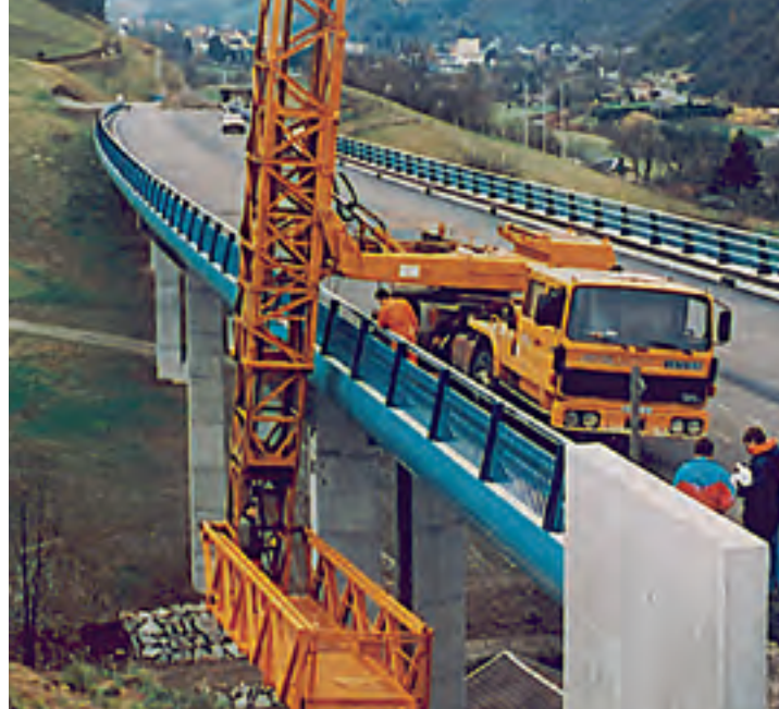
Figure 5 : inspection à l'aide d'une passerelle.
