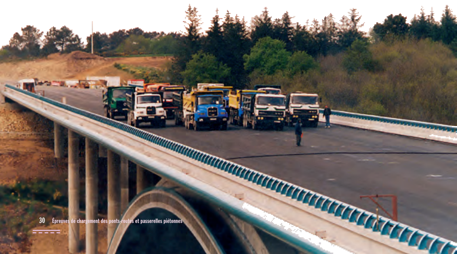
Figure 12 : chargement d'un pont en arc.
