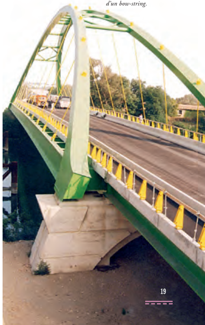
Figure 9 : Essai de chargement d'un bow-string.
