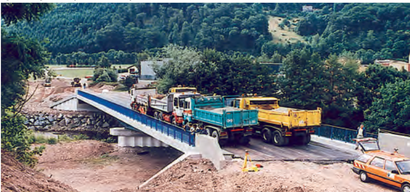
Figure 1 : chargement de la première travée d'un pont-dalle.
