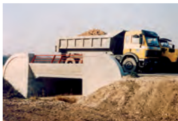
Figure 8 : essai de chargement d'un ouvrage de faible portée.
