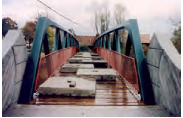
Figure 3 : épreuves par poids mort sur une passerelle.
