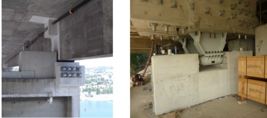
Figure 45: Techniques de renforcement sismique mises en œuvre sur le viaduc de Caronte à Martigues (A55)
