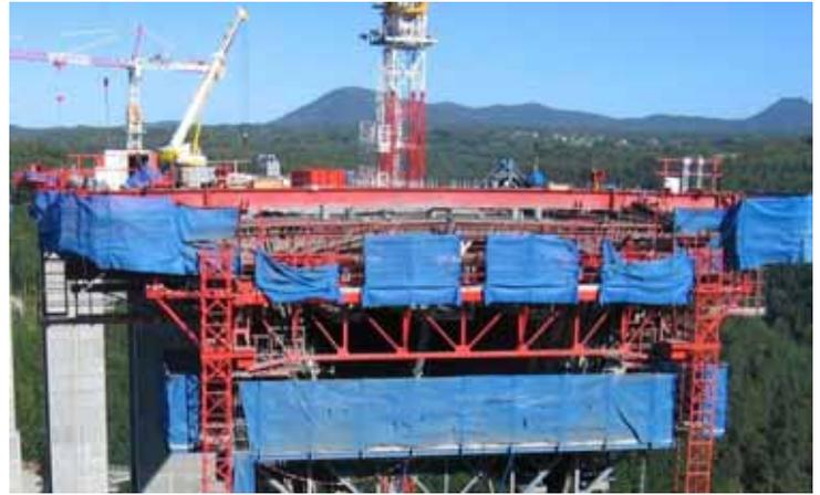
Figure 3-2 - Petite grue, rouleau de toron, compresseur, cabane. Viaduc de la Sioule. Photo Dodin-Campenon Bernard Région (F. Batifoulier & N. Guyot)
