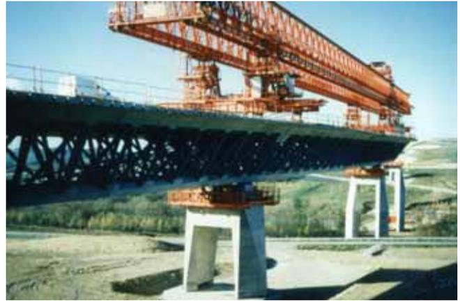
Figure 3-4 - Poutre de lancement. Photo Sétra (P. Vion)
