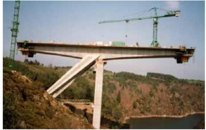
Figure 3-6 - Grue sur rail. Viaduc de la Truyère.
