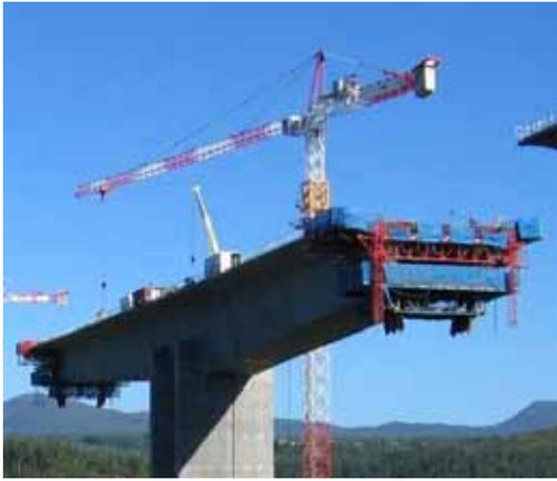
Figure 3-3 - Équipage mobile. Viaduc de la Sioule.
