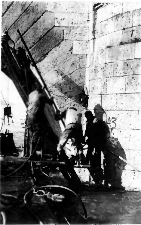
Fig. D.28. — Exécution d'un forage pour l'injection depuis un ponton.
