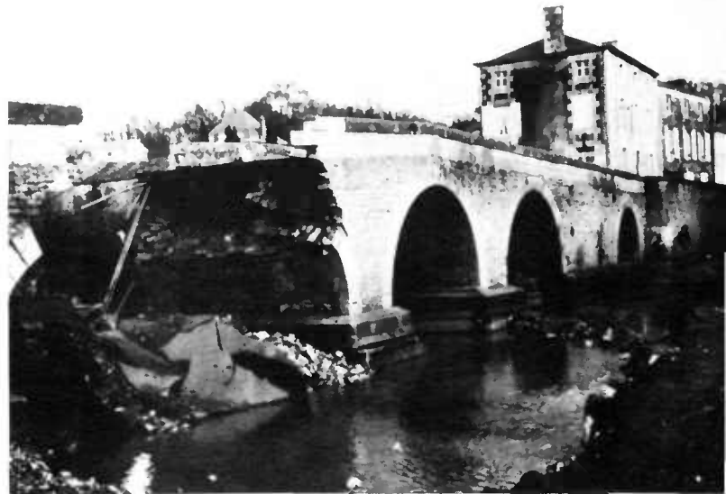
Fig. 51. — b) Seize ans après les travaux. L'affouillement de l'appui a entraîné un tassement de la pile vers l'amont suivi de l'effondrement de la voûte.
