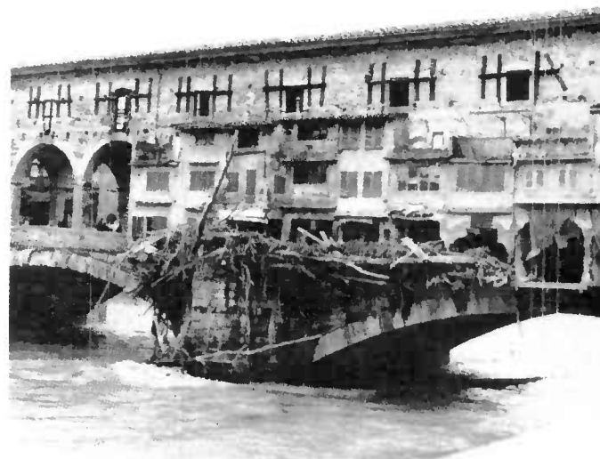
Fig. E.19. — Ponte Vecchio - Vue de l'ouvrage après la crue (1966).
