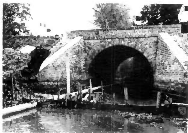
Fig. B.8. — Exemple de mise à sec avec écoulement sous l'ouvrage.
