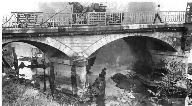
Fig. 37. — Début de l'effondrement.
