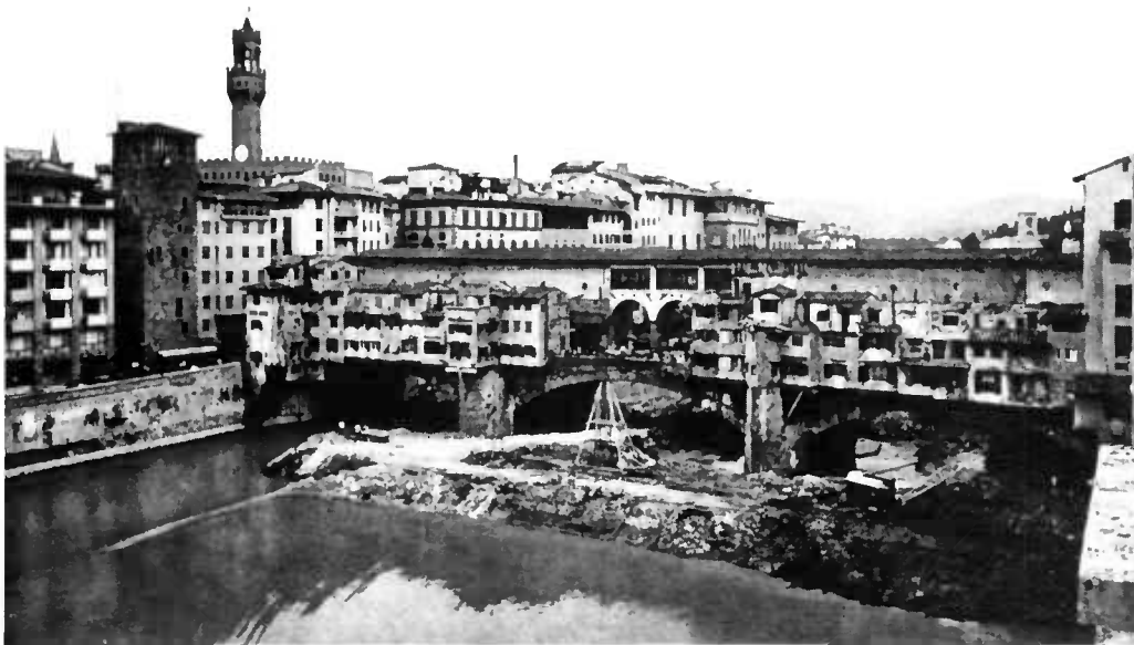
Fig. E.15. — Ponte Vecchio (Florence) - Vue générale de l'ouvrage pendant le chantier.
