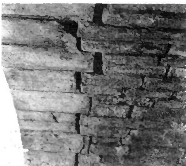
Fig. 43. — Décollement du bandeau. Largeur de la lézarde 60 mm
