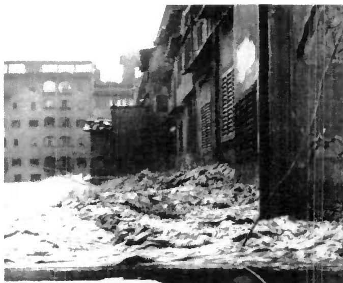
Fig. E.18. — Ponte Vecchio - Vue prise parallèlement à l'ouvrage pendant la crue (1966).
