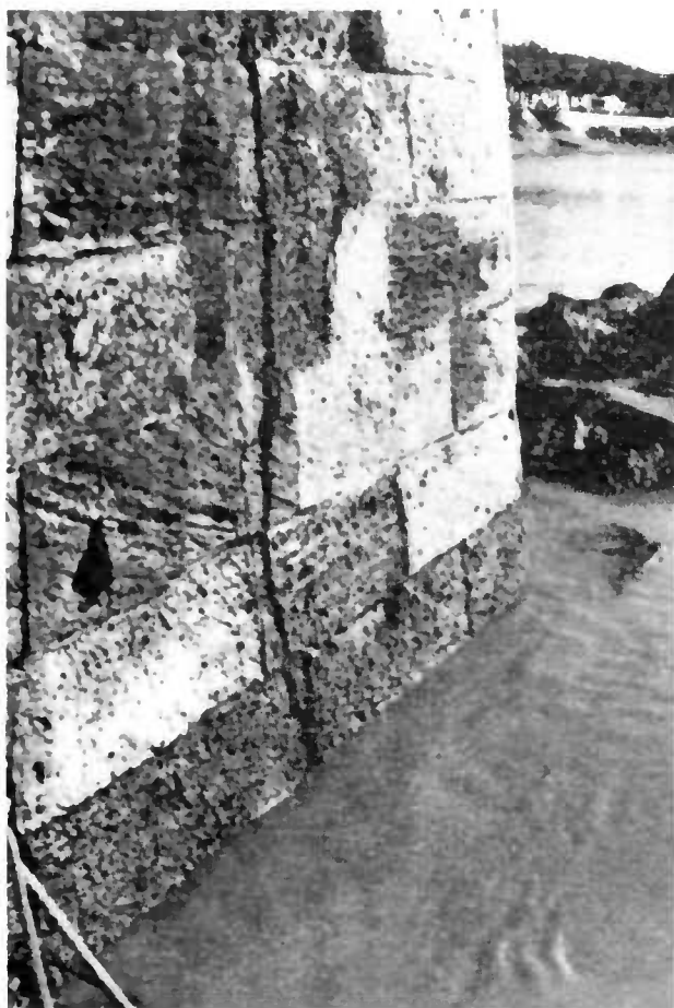
Fig. 48. — Fracturation verticale du corps de pile. Noter l'affleurement de l'angle d'un redan traduisant un mouvement de basculement.
