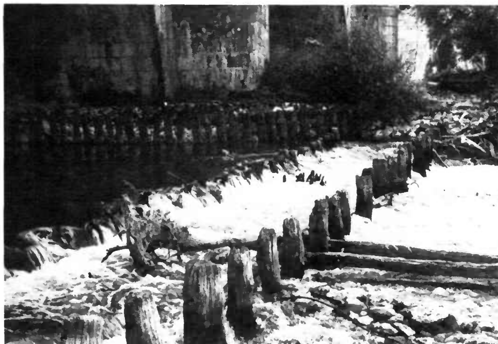
Fig. 17. — Creusement du profil en long. Apparition d'un seuil à l'aval de l'ouvrage et mise au contact de l'air des rideaux de protection en bois.
