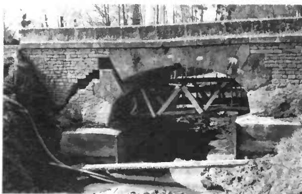
Fig. 36. — Affouillement des fondations provoqué par la présence d'un barrage amont.
