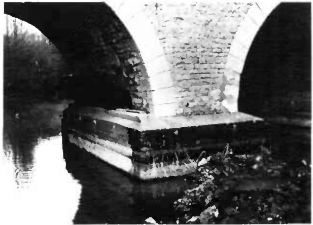
Fig. 51. — a) « Protection » de la pile par un voile de béton arrêté au niveau du fond du lit.
