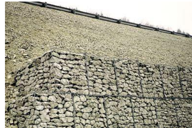
Type 4 : mur en gabions
