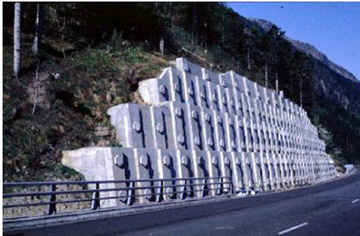
Type 13 : voiles ou poutres ancrés
