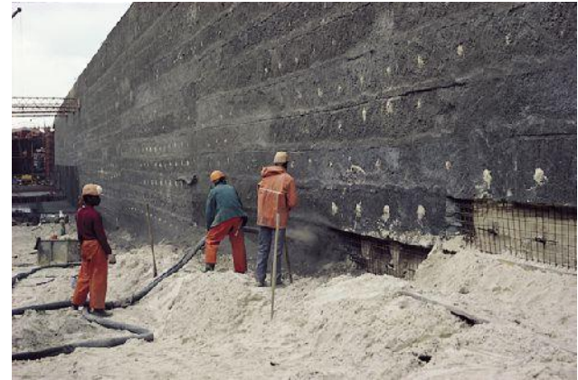
Type 12 : parois clouées en travaux
