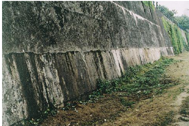
Type 3 : mur poids en béton
