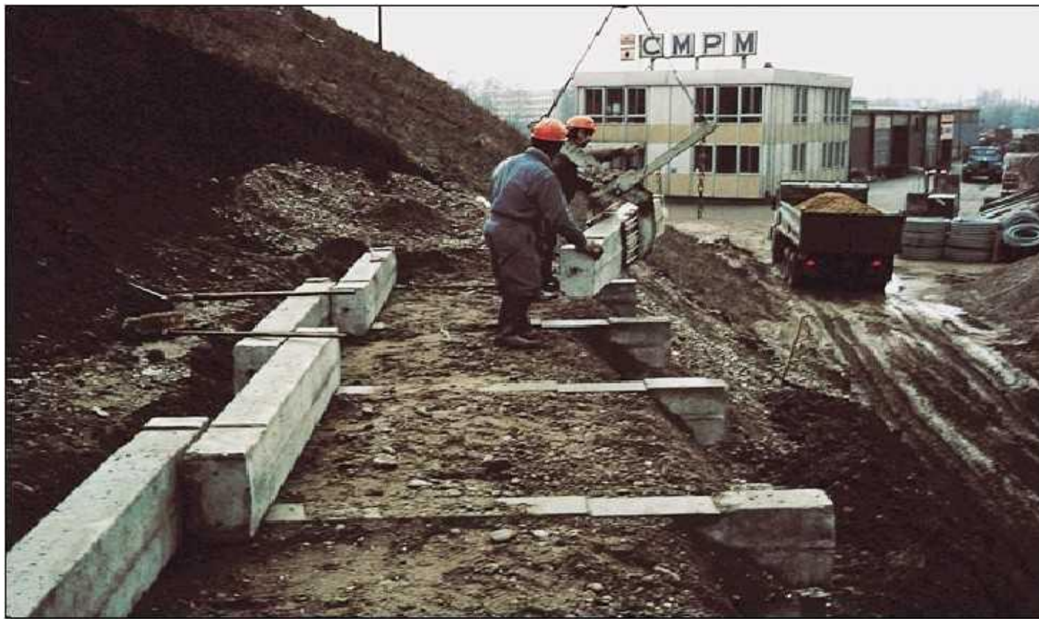
Construction d'un mur Peller
