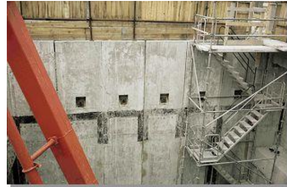
Type 8 : parois moulées ou préfabriquées
