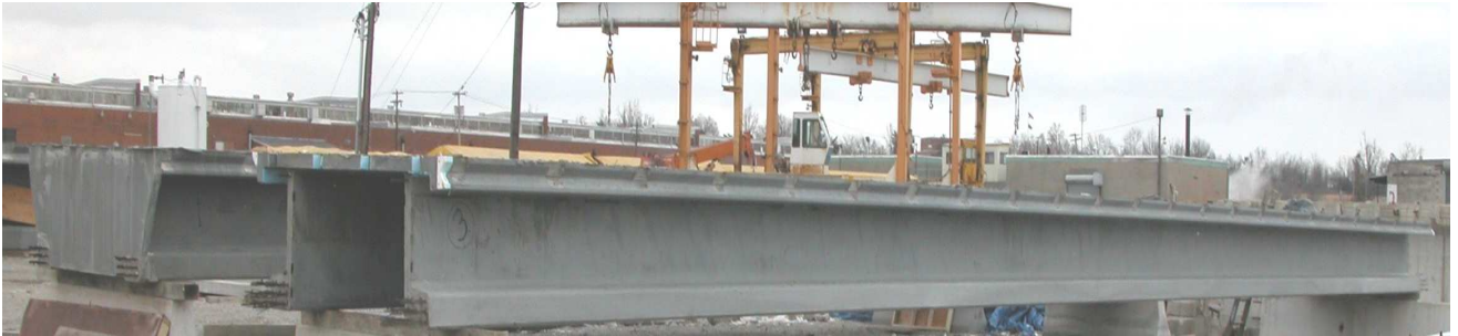
Aperçu général / General overview
