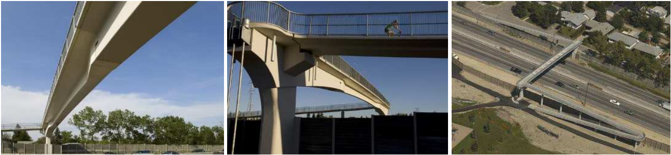
Aperçu général / General overview
