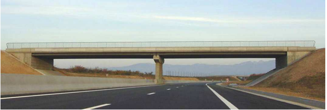
Vue d'ensemble d'un des ponts / General view of one of the bridges
