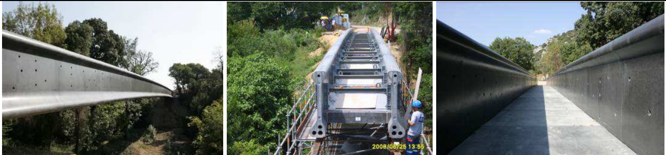
Aperçu général / General overview
