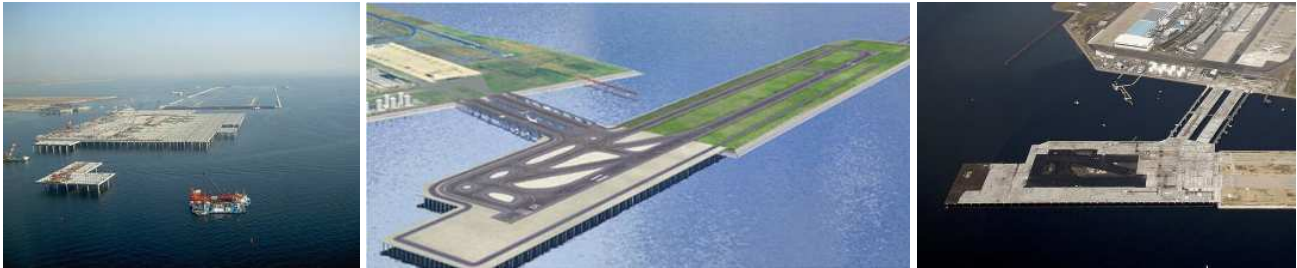
Aperçu général / General overview
