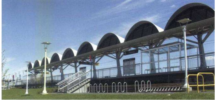
Aperçu général / General overview
