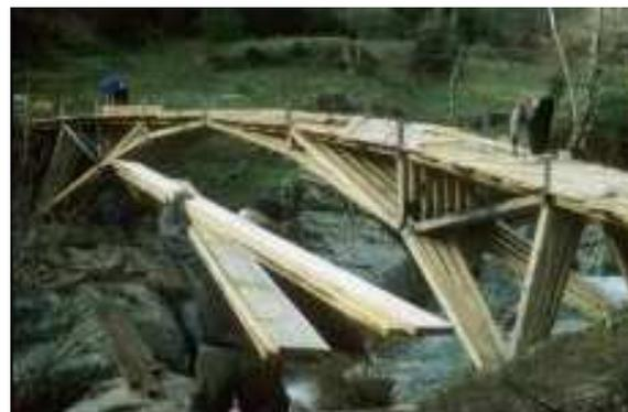
*Photo de gauche : Montage de la structure primaire à l'aide d'échafaudages tubulaires
