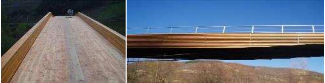
Photo de gauche : platelage longitudinal de planches bouvetées en châtaignier
