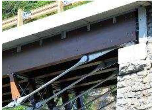
*A gauche : Vue des tirants en acier de la sous tension des poutres en BLC*
