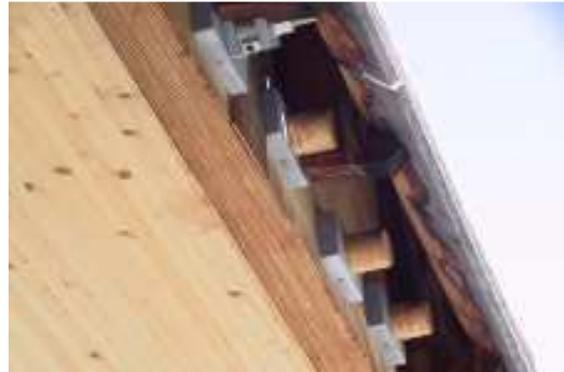
*Photo de gauche : sous-face du pont de Strada (Suisse), tablier précontraint transversalement*
