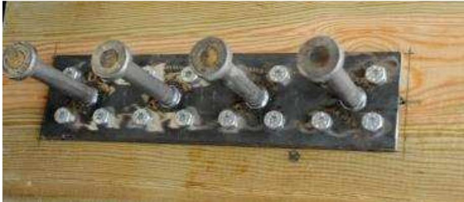
*Figure 7-9 : Variante du cas précédent avec crampons. connecteur fixé au bois lamellé collé par tire fonds SFS de diamètre 10 mm (Blonski 2009). Dans un ouvrage, la plaque en acier aura une longueur de quelques mètres*
