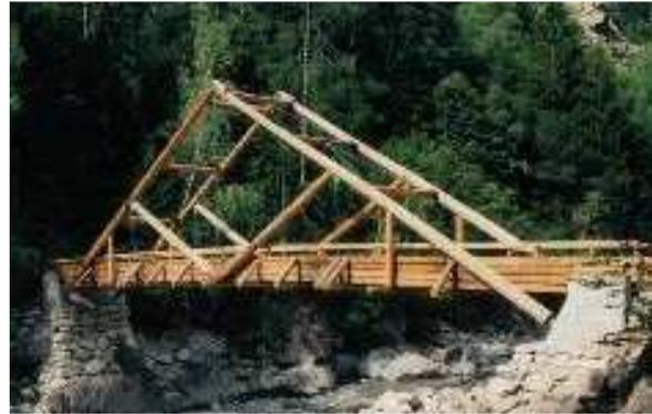
Ponts ayant l'allure de ponts en fermes mais fonctionnant comme des ponts en arc (à gauche : pont de Brodhüseli, Suisse ; à droite : passerelle du Borgeaud, Suisse)
