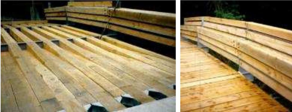
A gauche : assemblages métalliques des poutres, en travée et en extrémité
