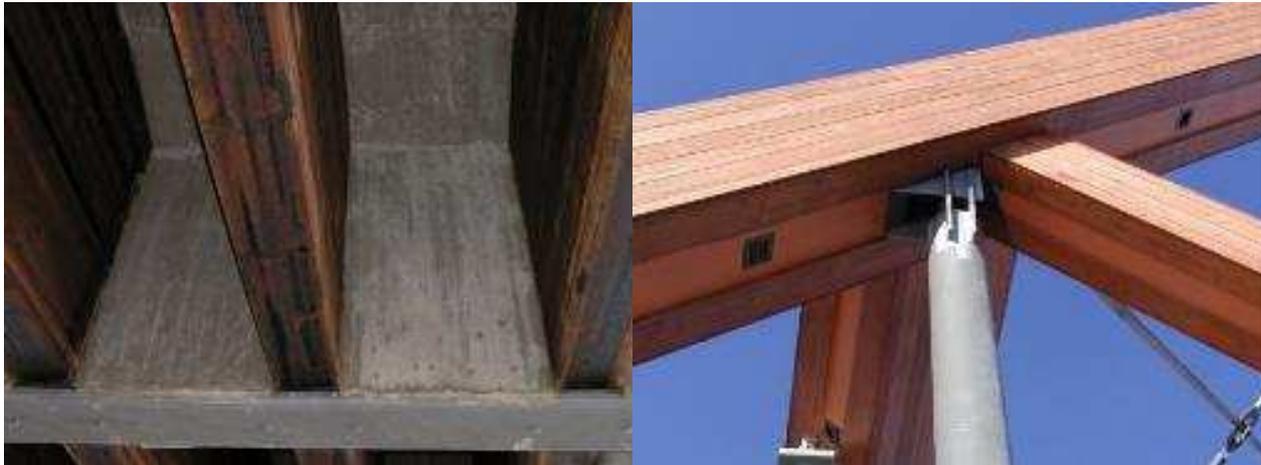
*Photo de gauche : au niveau des appuis, l'entretoisement des poutres est réalisé par le béton*
