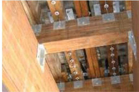
Photo de gauche : poutres primaires (longitudinales) et pièces de pont (transversales)
