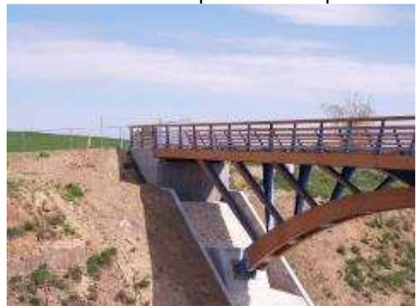
*Vue du tablier et des garde-corps. L'impression que les garde-corps sont verticaux au premier plan de la photo de droite vient du point de vue particulier et de la double inclinaison des montants, à la fois rayonnants et inclinés vers l'intérieur du tablier*
