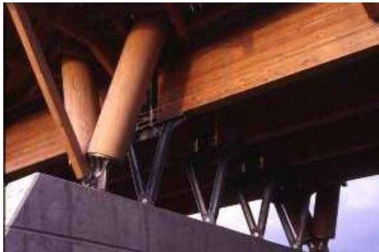
*A gauche : détail de l'assemblage « Résix » selon la technologie développée par Simonin*
