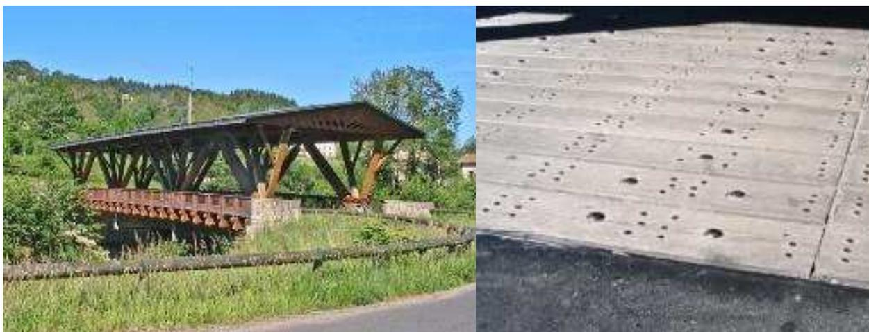
*Photo de gauche : la couverture autorise le choix d'un platelage d'un bois car elle protège la structure contre les intempéries.*
