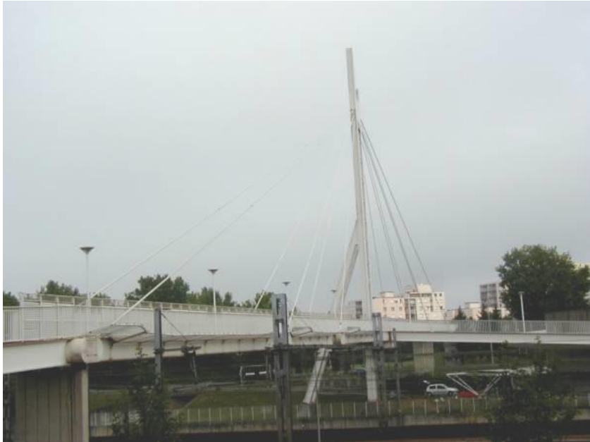
Photo A.4.7 - Passerelle du Pas du Lac / Pas du Lac footbridge
