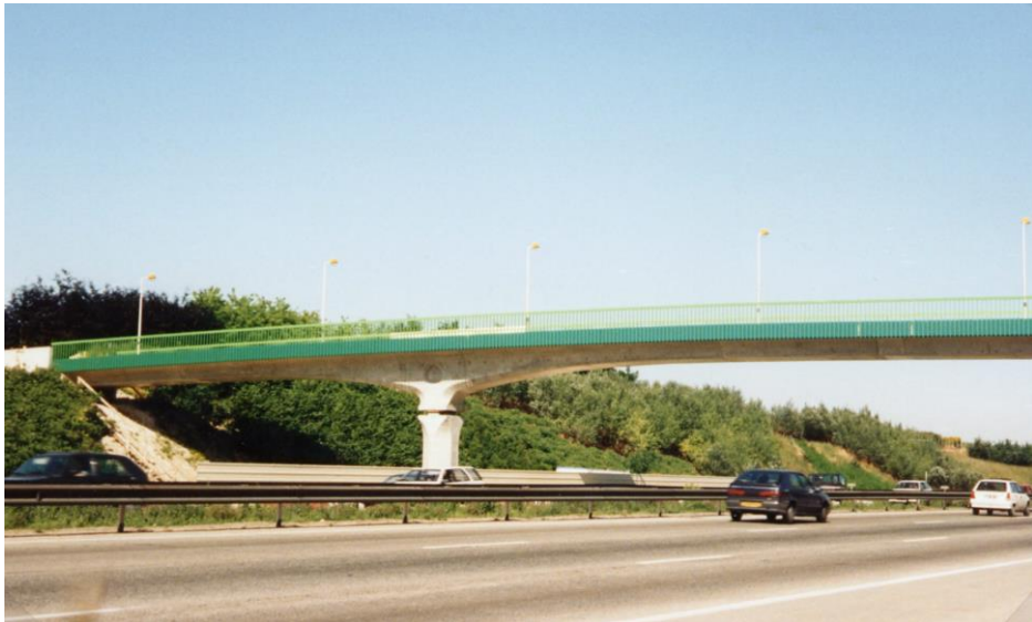
Photo A.4.3 - Passerelle de Noisy-le-Grand / Noisy le Grand footbridge
