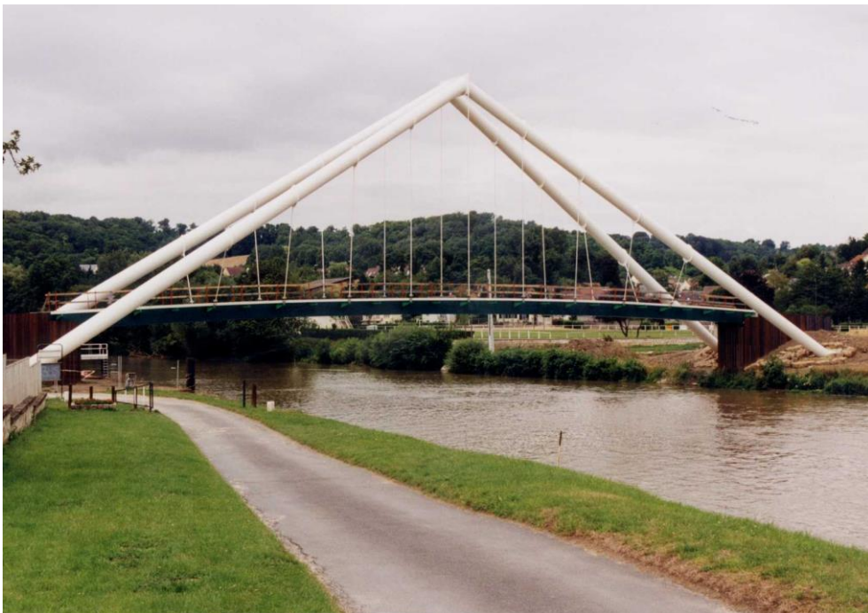
Photo A.4.5 - Passerelle de Soissons / Soissons footbridge
