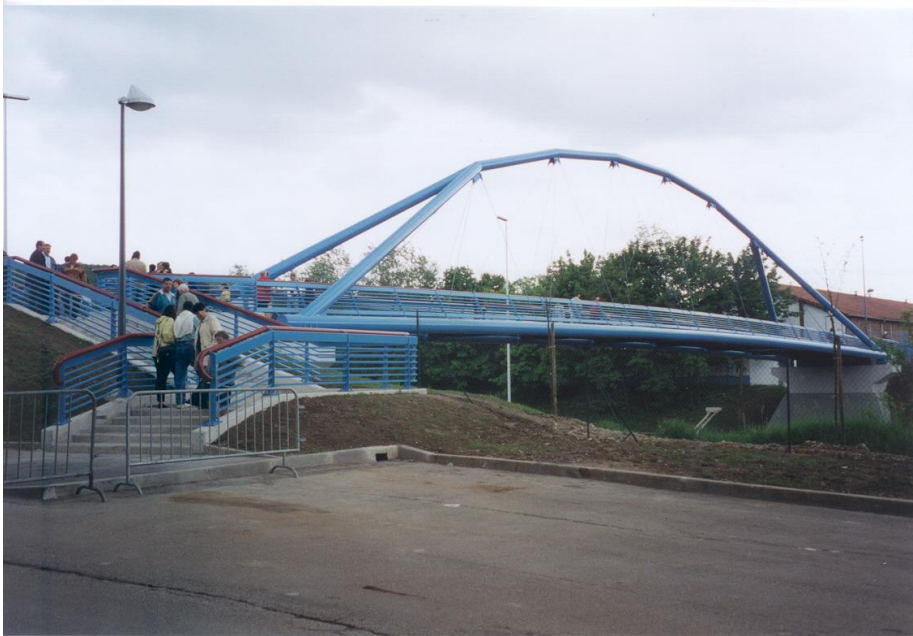
Photo A.4.4 - Passerelle de Montigny-lès-Cormeilles / Montigny lès Cormeilles footbridge
