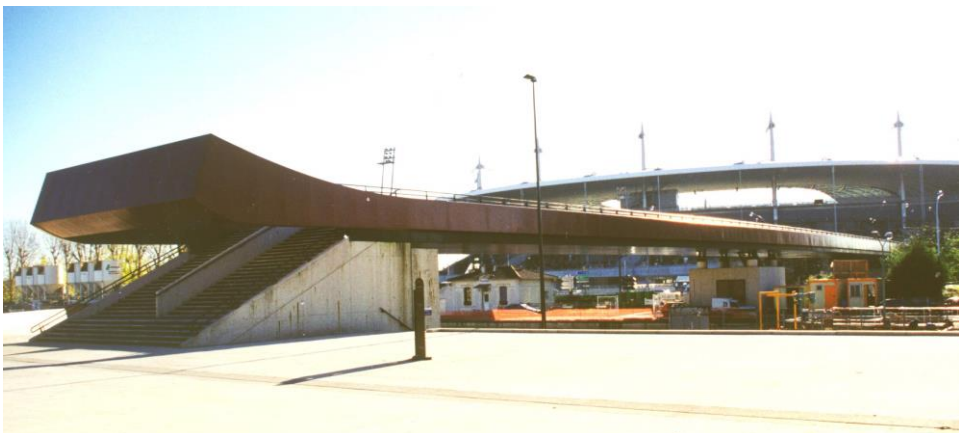
Photo A.4.2 - Passerelle du Stade de France / Stade de France footbridge
