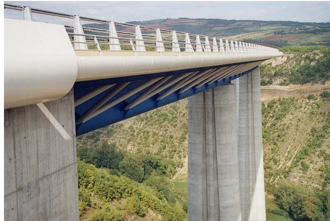
Photo 4.1 : Viaduc de Verrières (Photo Construiracier - JM. Vigo)
