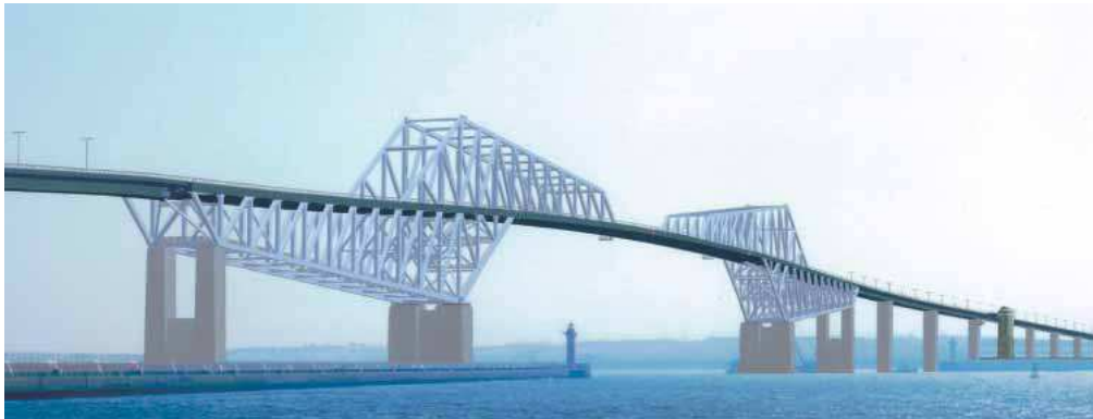
Photo 7.2 : Tokyo Bay Bridge conçu avec des aciers BHS (travée centrale de 440m) (Photo Construiracier - JM. Vigo)
