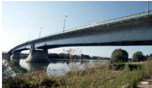
Photo 4.2 : Pont de Jassans Riottier - Travée de 130m, nuance d'acier S460 sur appui et S355 en travée (Photo Construiracier - JM. Vigo)
