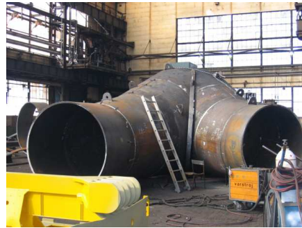
Photo 7.3-15 b : bifurcation de la centrale hydroélectrique de Káhranjúkar en Islande (© Voith Hydro - C. Manuelli)
