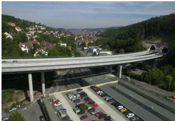
Photo 7.3-4 : Pont sur la Nesenbachtal en Allemagne - S 690 (Photo Construiracier - JM. Vigo)
