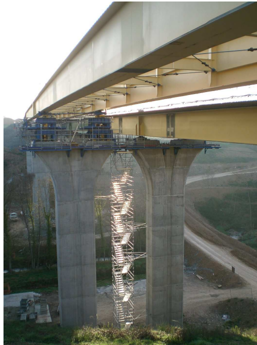
Photo 7.3-8 : 2011 : Viaduc de Bernard (A89 est) : 1030t dont 230t S460M(L). ep. max. 55mm (Photo Baudin-Chateauneuf - S. Pauvert)
