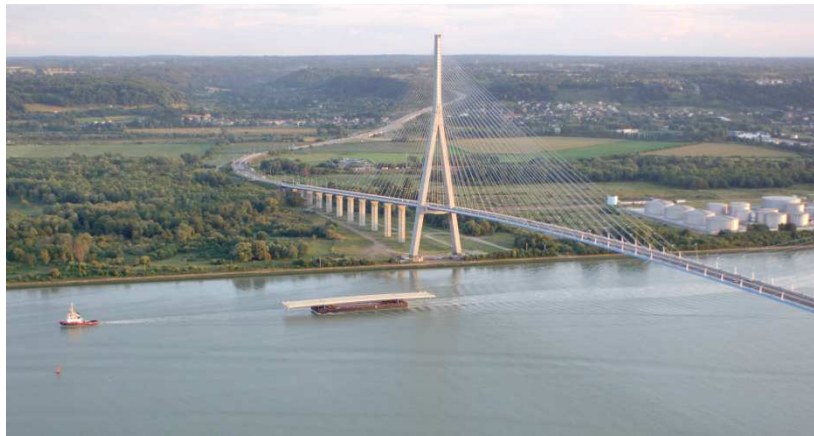
Photo 7.3-2 : Pont de Normandie - S 420 (Photo Sétra - G. Forquet)
