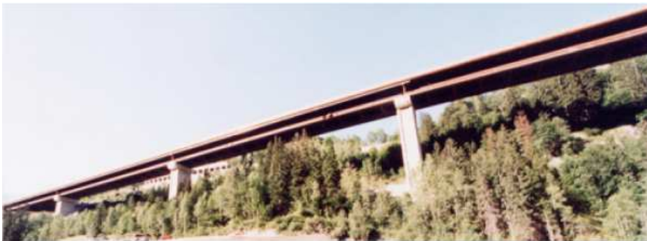
Photo 4.7 : Viaduc de Verrand (Photo Construiracier - JM. Vigo)
