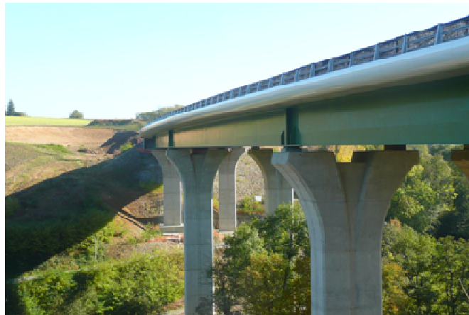
Photo 7.3-9 : 2011 : Viaduc de Buvet (A89 est) : 1290t dont 330t S460M(L). ep. max. 80mm (Photo Baudin-Chateauneuf - S. Pauvert)
