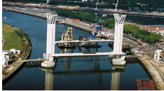
Photos 7.3-12 : Pont levant Gustave Flaubert à Rouen, installation des tabliers - Aciers S460 M (Photo Eiffage CM)
