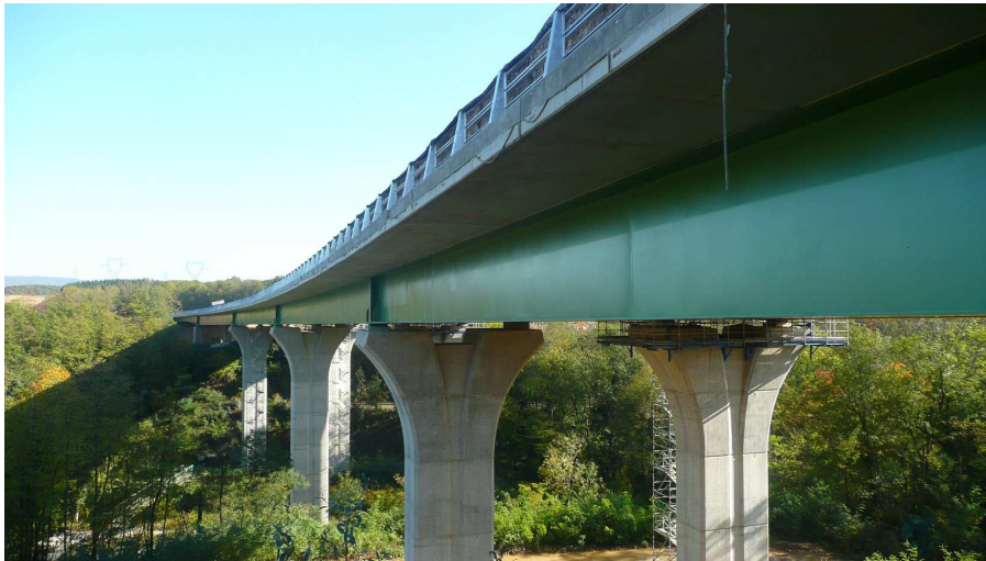
Photo 7.3-10 : (2011) Viaduc de Brévenne (A89 est) : 1445t dont 520t S460M(L). ep. max. 85mm (Photo Baudin-Chateauneuf - S. Pauvert)
