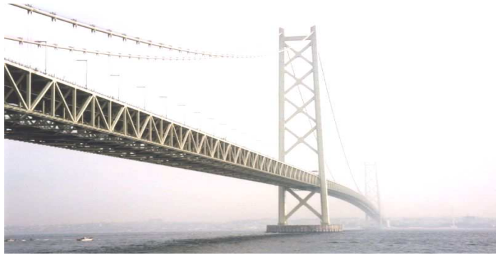
Photo 7.3-3 : Akashi Kaikyo au Japon (record du monde de portée 1991 m) - S 780 (Photo Construiracier - JM. Vigo)
