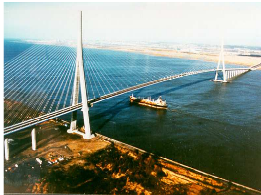
Photo 4.5 : Pont de Normandie (Photo Sétra - G. Forquet)
