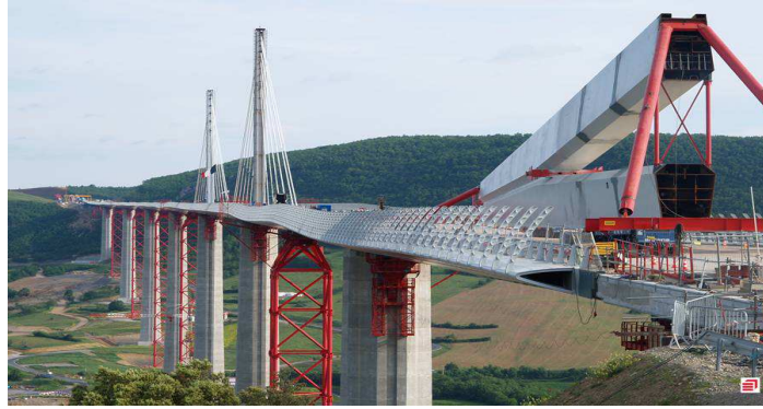
Photo 7.3-1 : Viaduc de Millau Tablier et pylônes - S460 (Photo Construiracier - JM. Vigo)
