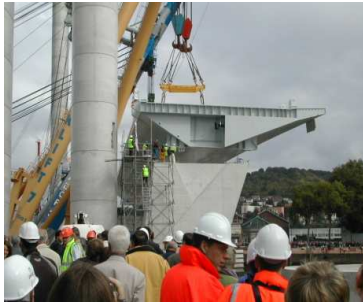
Photos 7.3-12 : Pont levant Gustave Flaubert à Rouen, installation des tabliers - Aciers S460 M (Photo Eiffage CM)
