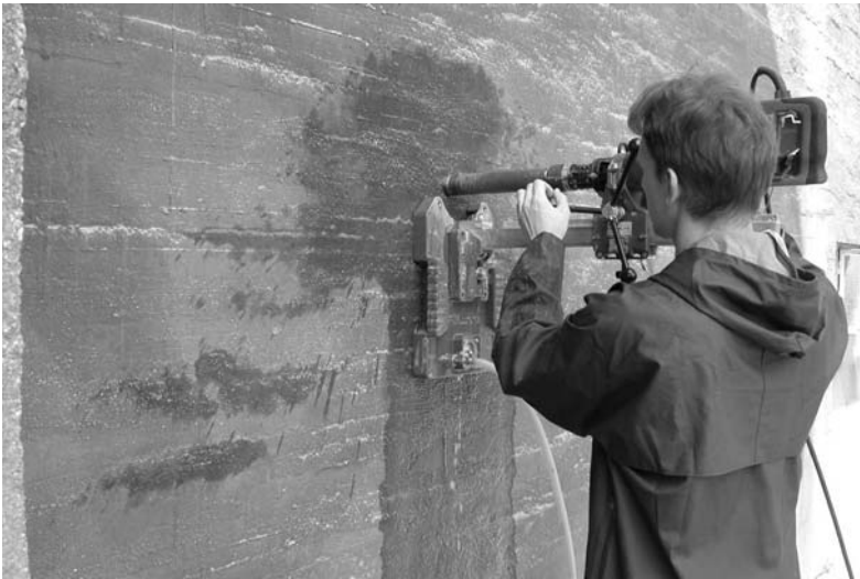
photo 2.5 : Prélèvements par carottage
