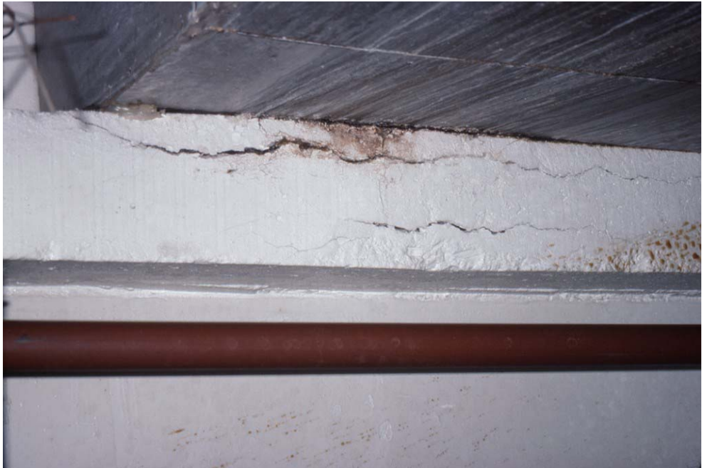
photo 1.2 : Poutre support de réservoir
