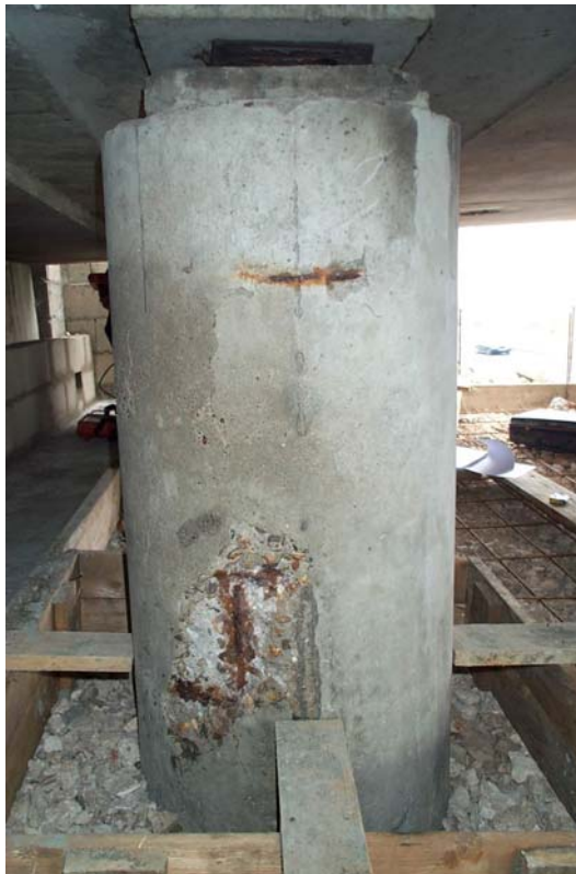
photo 1.5 : Pile de pont
