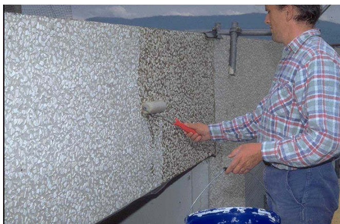
photo 4.4 : Application d'inhibiteur
