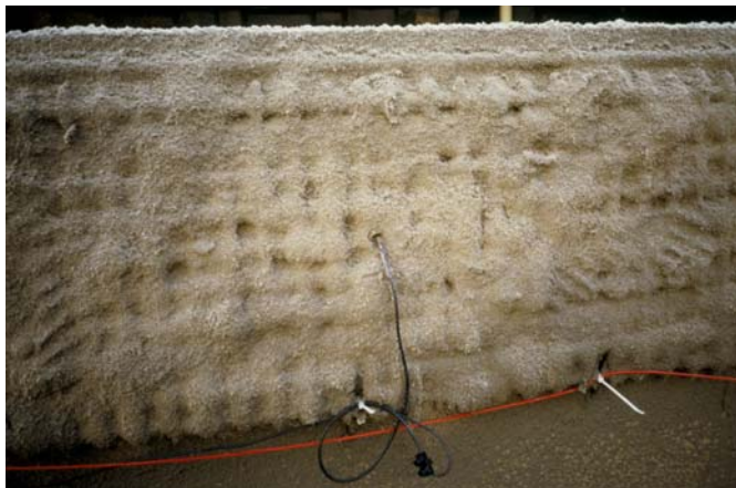
photo 4.9 : Traitement en cours
