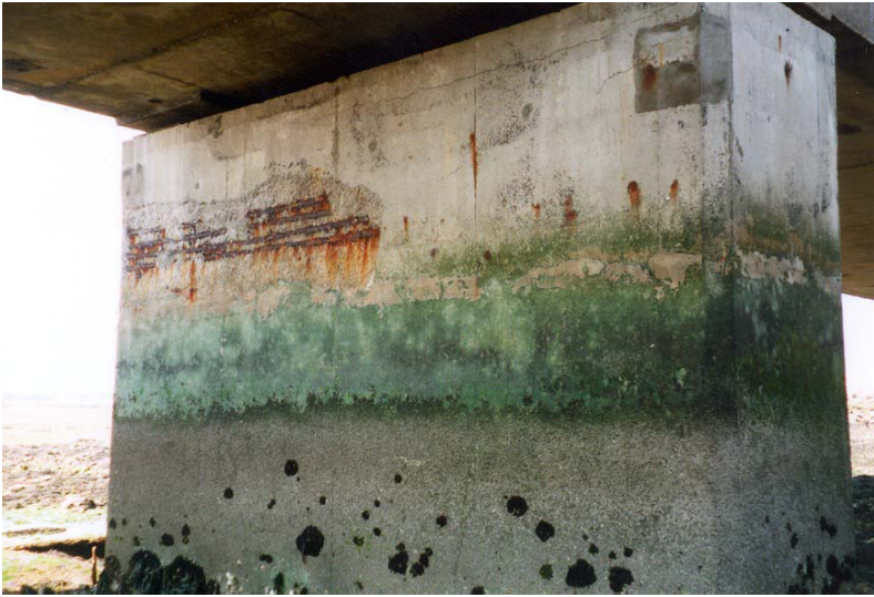
photo 1.7 : Pile en zone de marnage
