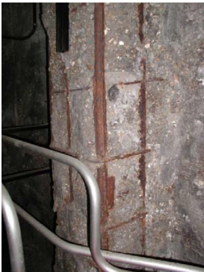
photo 1.3 : Poteau porteur sous garage
