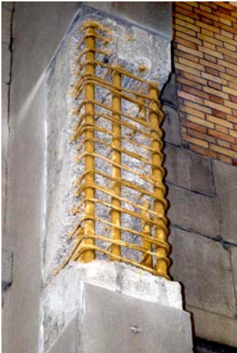
← photo 4.1 : Protection des armatures
