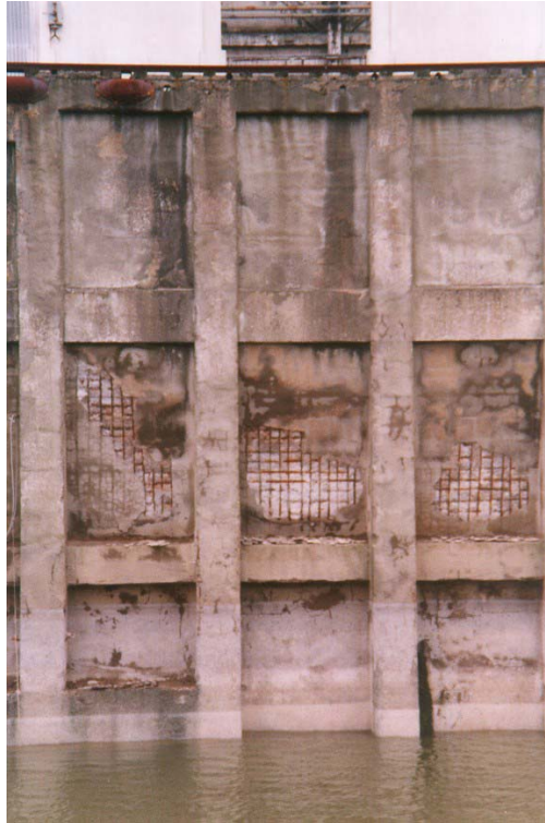
photo 1.9 : Quai en zone de marnage
