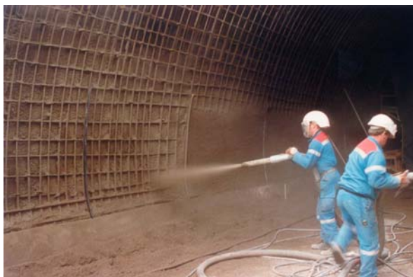
photo 4.7 : Projection de béton
