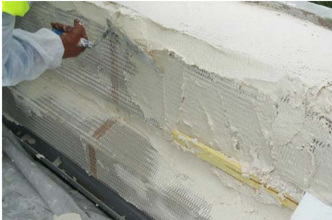
photo 4.8 : Application de la pâte sur le treillis
