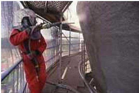
photo 3.2 : Projection en conditions difficiles
