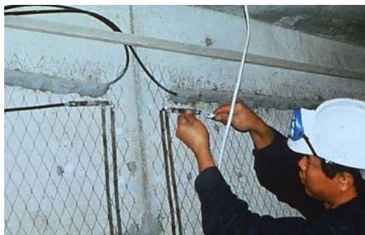
photo 4.10 : Mise en place du treillis anodique
