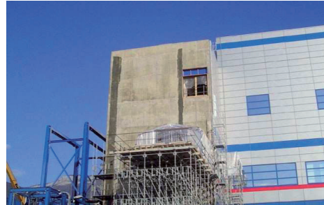
Figure 1 : Photo de l'ouvrage
