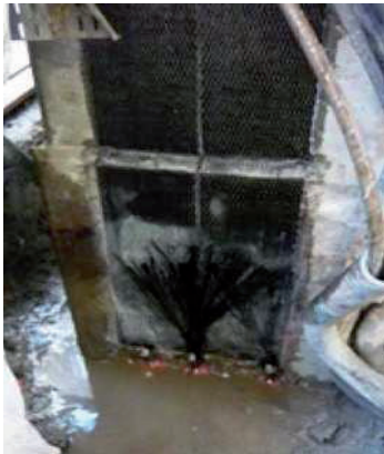
Figure 2 : Photo du renforcement
