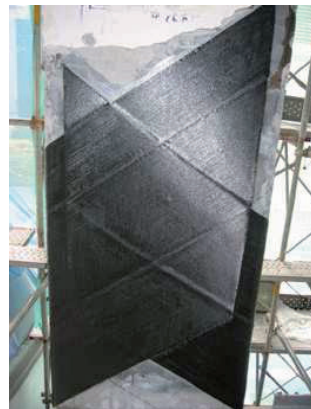
Figure 2 : Photo du renforcement
