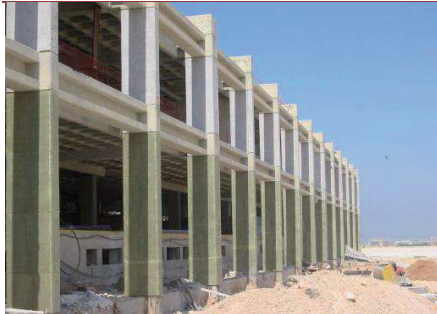
Figure 2 : Photo du renforcement
