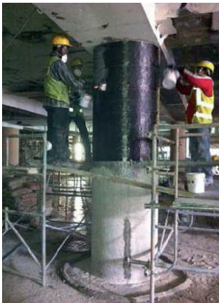
Figure 2 : Photo du renforcement
