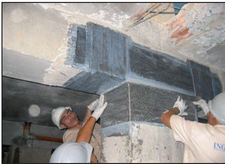
Renforcement d'un nœud poteau/poutre
