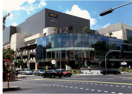
Figure 1 : Photo de l’ouvrage
