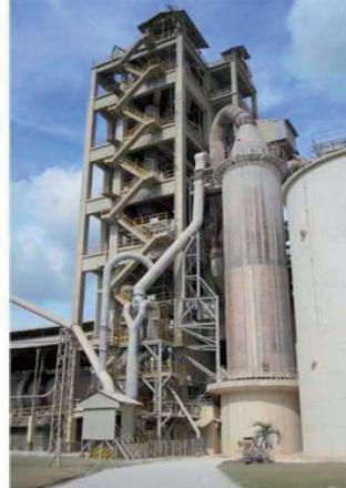
Figure 1 : Photo de l'ouvrage
