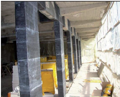
Figure 2 : Photo du renforcement
