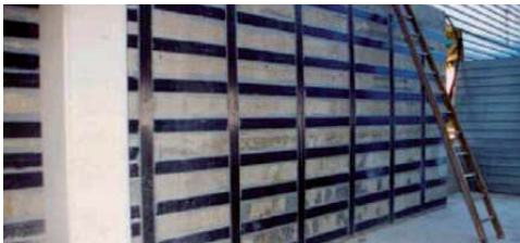
Figure 2 : Photo du renforcement
