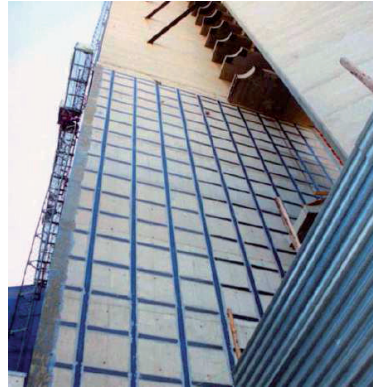
Figure 1 : Photo de l'ouvrage
