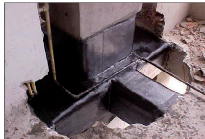
Renforcement d'un nœud poteau/poutre
