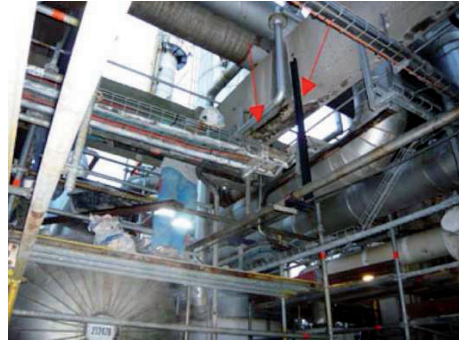
Figure 1 : Photo de l'ouvrage
