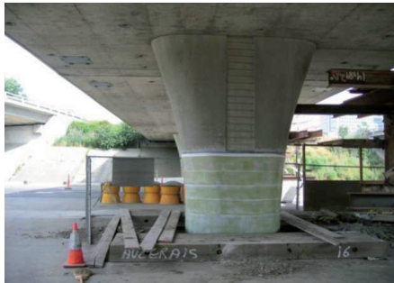
Figure 2 : Photo du renforcement
