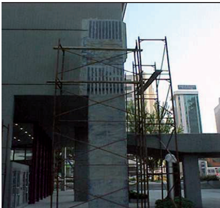
Figure 2 : Photo du renforcement
