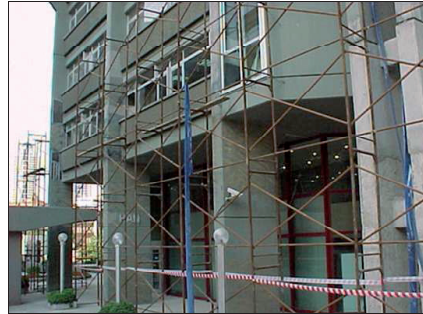
Figure 1 : Photo de l'ouvrage
