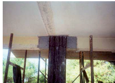
Figure 2 : Photo du renforcement
