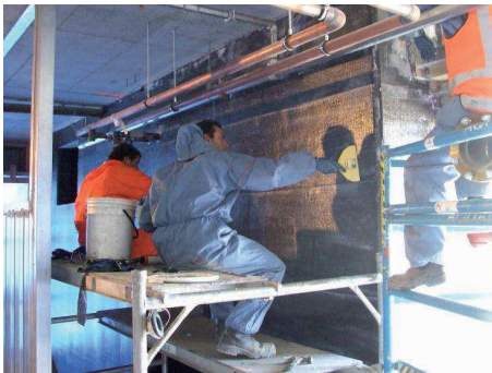
Figure 2 : Photo du renforcement
