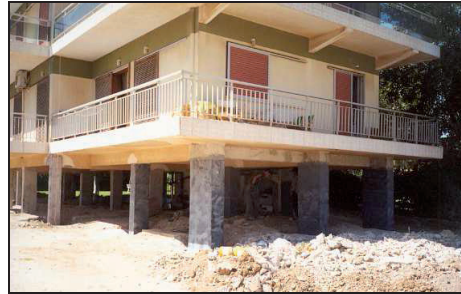
Figure 1 : Photo de l'ouvrage
