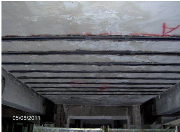
Figure 2 : Photo du renforcement
