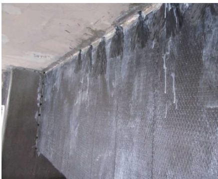
Figure 2 : Photo du renforcement
