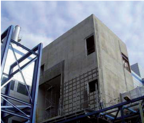
Figure 2 : Photo du renforcement
