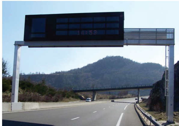
Photos 7 et 8 : Portique équipé de moyens d'accès permettant l'accès au dispositif de signalisation par PMV
