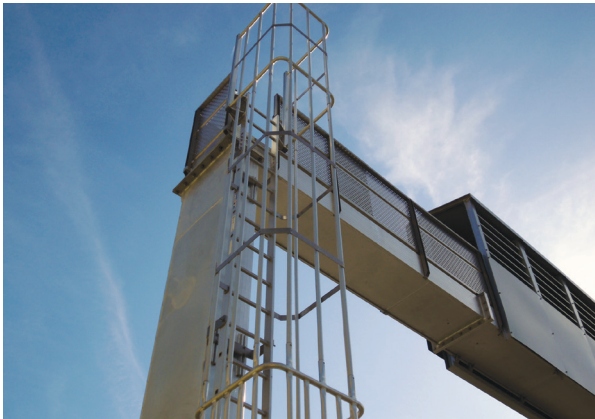
Photos 7 et 8 : Portique équipé de moyens d'accès permettant l'accès au dispositif de signalisation par PMV
