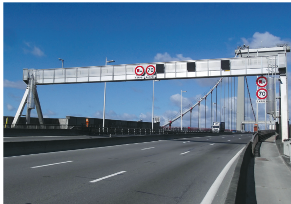
Photo 10 : Portique à montants doubles
