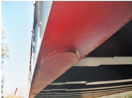
1960 - semelle additionnelle non délardée
