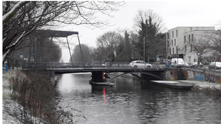
Cas d'un pont mobile contigu à un pont fixe, à recenser séparément
