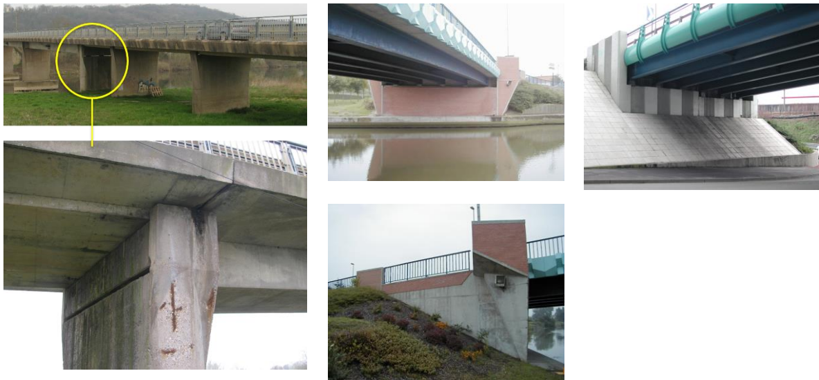
Exemple de pile-culées
