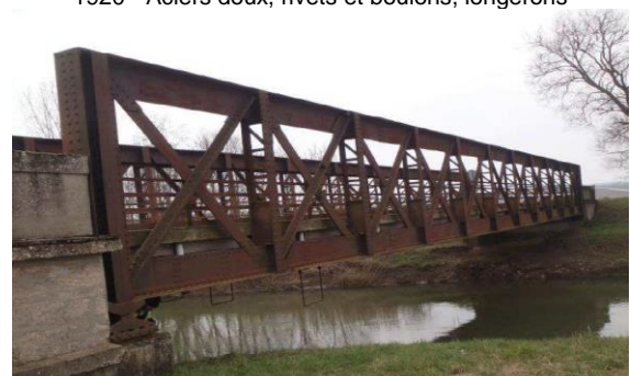
1954 - Aciers doux, rivets, hourdis béton armé
