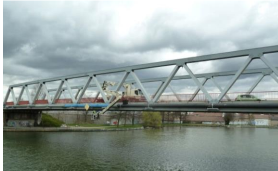
1970 - Aciers moderne, soudure en atelier, boulons précontraints sur site, hourdis béton armé
