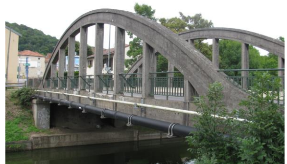
1953 - suspentes et pièces de pont plus épaisses
