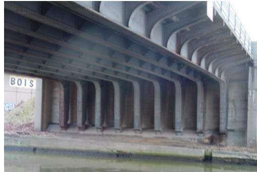
1946 – bacs en acier coffrant le béton
