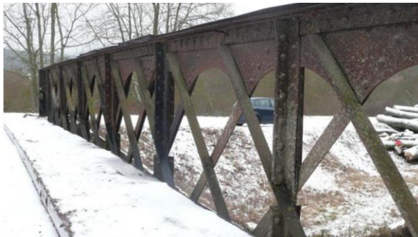
Avant 1900 (Fer puddlé, rivets)
