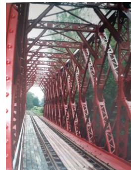
1920 - Aciers doux, rivets et boulons, longerons
