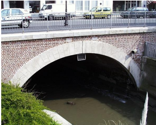
Voûte en maçonnerie à arche unique
