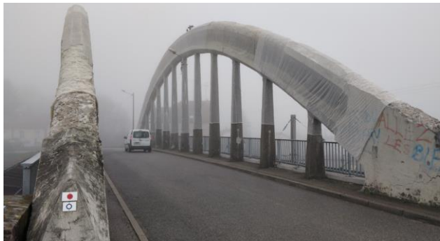
1926 – suspentes et pièces de pont fines
