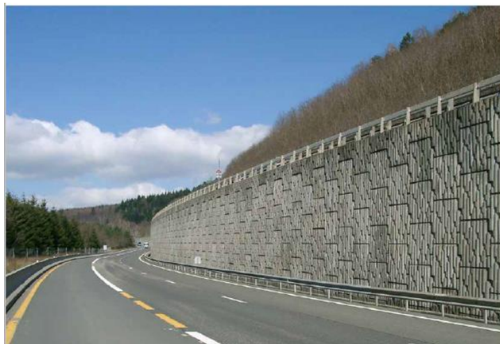
Figure 25 : Exemple de mur en Terre Armée
