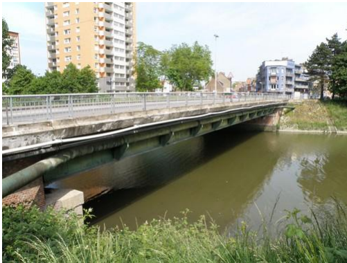
Les appuis de l'ouvrage sont partiellement visibles depuis les berges du canal
