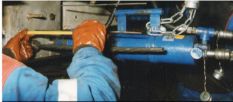
mise en tension d'un monotoron
