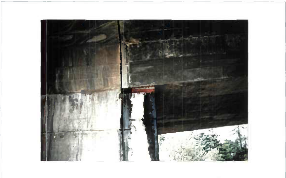
Fig. 4.04 - Position limite des appareils d'appui.
