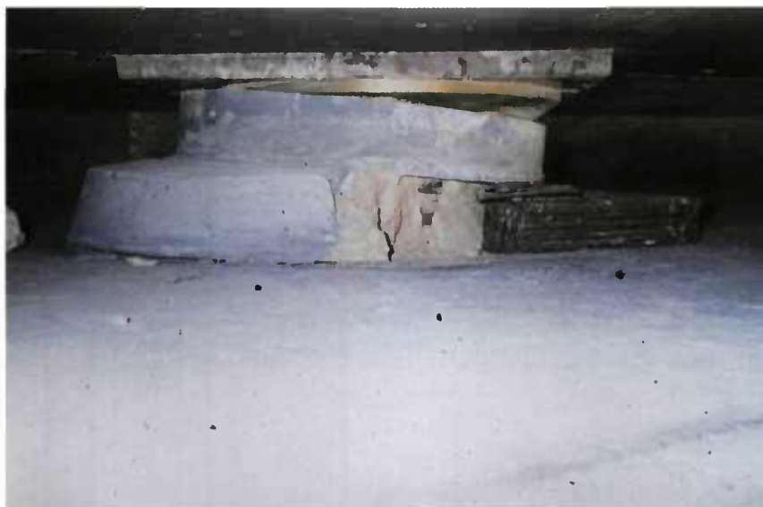
Fig. 3.06 - Bossage éclaté sous un appareil d'appui à pot nécessitant un traitement d'urgence.
