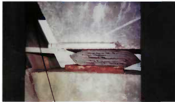
Fig. 3.19 - Déformation en S de l'appareil d'appui.
