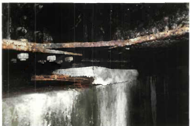
Fig. 3.05 - Oxydation des tôles de calage.
