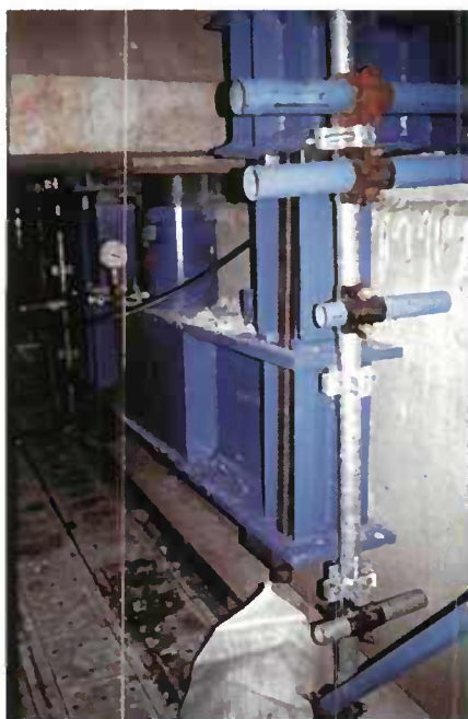
Fig. 5.04 - Vérinage avec chaise sur pile.
