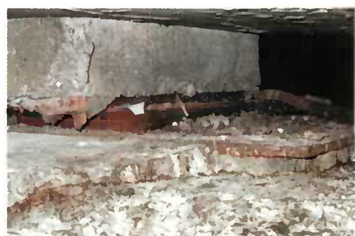
Fig. 3.25a et 3.25b - Décollement de la partie en acier inoxydable.
