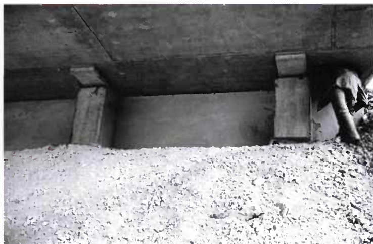
Fig. 3.03 - Accès aménagé pour effectuer la visite des appareils d'appui.
