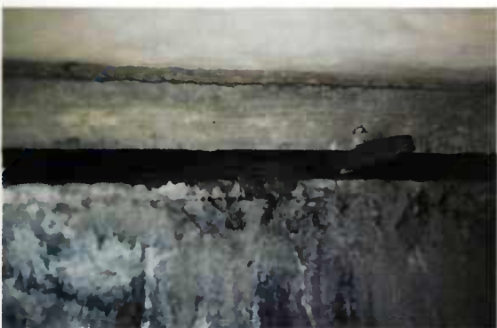
Fig. 3.15 - Écrasement d'un appareil d'appui.
