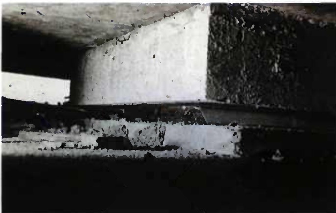
Fig. 3.27 - Défaut de planéité de la plaque en acier inoxydable.
