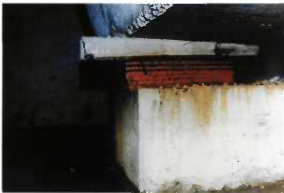
Fig. 3.14 - Chémissement de l'appareil d'appui.
