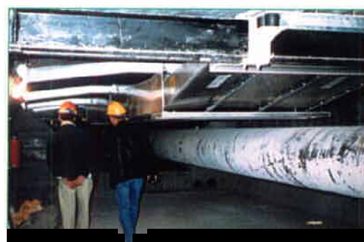
Fig. 28 - Encombrement à l'intérieur d'un voussoir par des réseaux.
