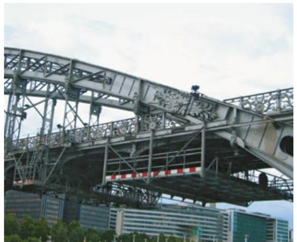
Passerelles mobiles sous le tablier d'un ouvrage métallique
