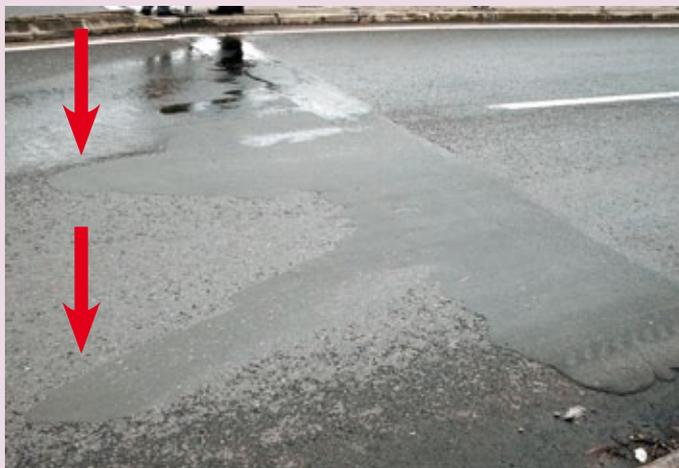
Fluage important avec « écoulement » en raison de la pente de l'ouvrage
