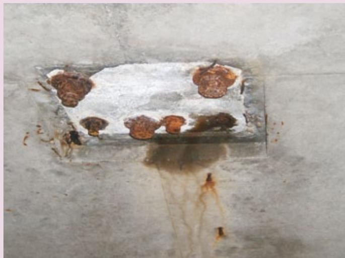
*Écoulement d'eau le long des tiges avec humidité en intrados et corrosion de la visserie de fixation*
