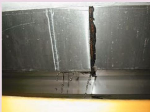
*Perte d'étanchéité entre éléments d'une corniche caniveau métallique*
