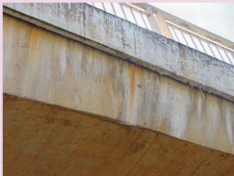
**Gravité :** peut être importante en raison du risque, à terme, d'une corrosion des armatures de liaison.
