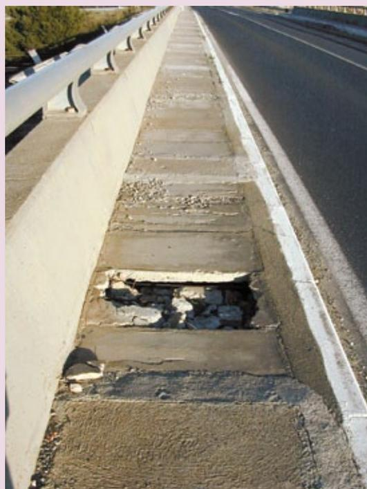
**Gravité :** variable, à apprécier en fonction de l'importance des dégradations et des risques vis-à-vis de la sécurité des piétons (landaus, fauteuils d'handicapés).
