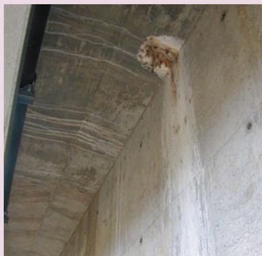
*Coulures de calcite et stalactites actives au droit de la fixation d'un lampadaire*
