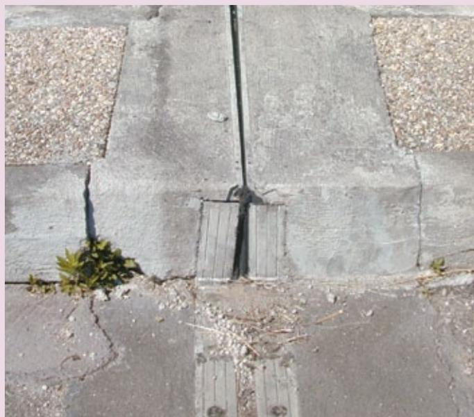
*Défaut de mise en œuvre des joints de trottoirs(et de la remontée)*
