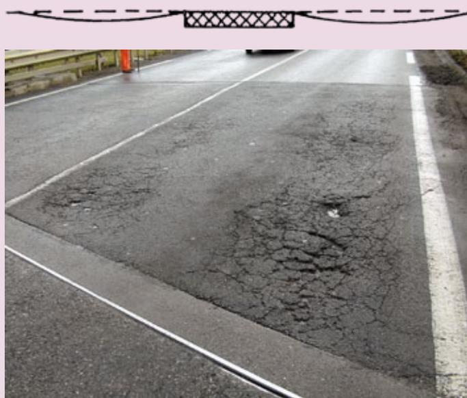
**Gravité :** variable selon l'importance des défauts. En effet, l'état du revêtement aux abords immédiats du joint est un point important pour la pérennité de la partie mécanique du joint de chaussée proprement dit.
