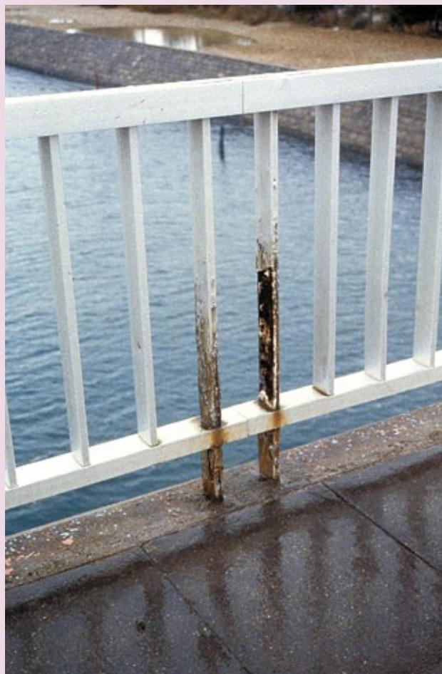
*Corrosion galvanique entre le montant en acier et le capotage en aluminium*
