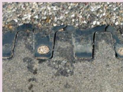
*Contact entre éléments en vis-à-vis du joint*
