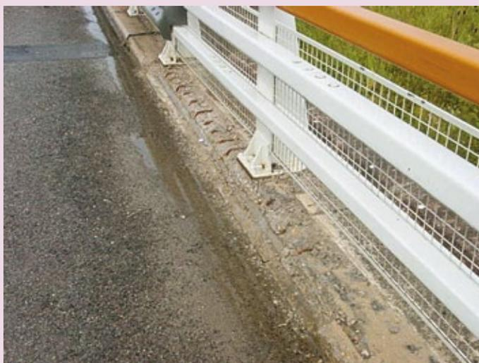
*Armatures de liaison apparentes et éclats de béton*
