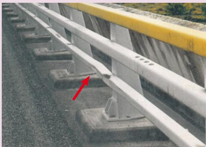
**Gravité :** variable suivant le choc, les parties détériorées (sur le dispositif de retenue et/ou le support) et éventuellement la mise en péril du support et des usagers.
