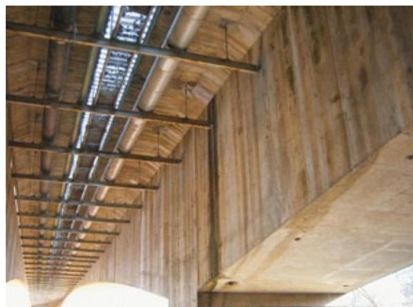
Figure 39 - Présence de canalisations sous les 2 encorbellements centraux
