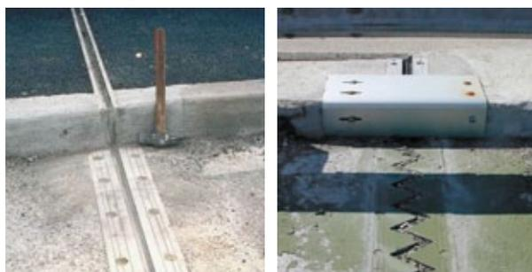
Retombée du joint de trottoir masquant la remontée du joint de chaussée
