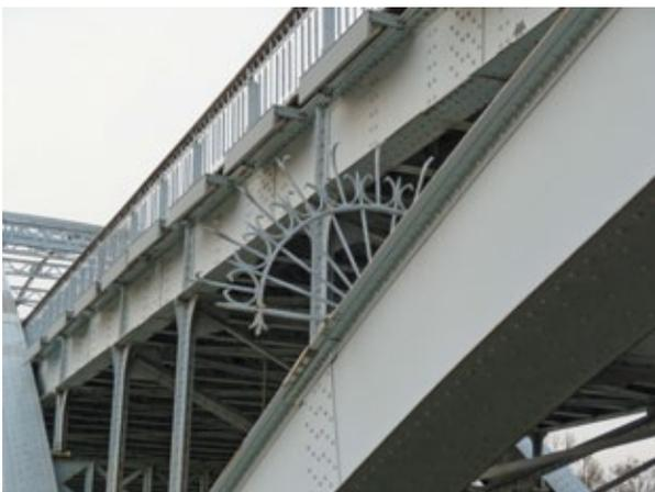
Figure 38 - Exemple d'équipement de protection contre les intrusions
