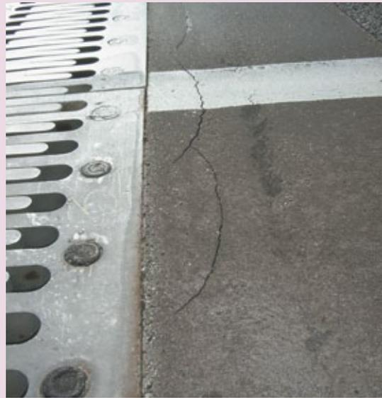
*Fissuration « circulaire » au droit d'ancrage « douteux »*
