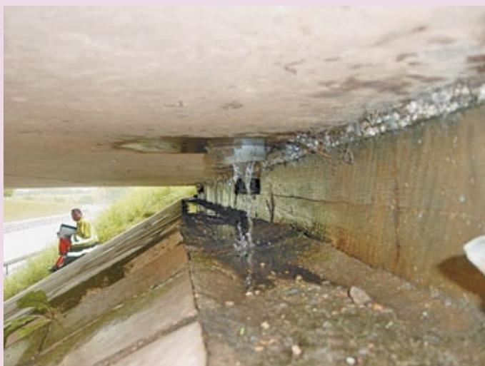
**Gravité :** faible à court terme (problème esthétique) mais risque d'évolution à moyen terme par altération de la partie d'ouvrage (béton d'enrobage, corrosion des armatures de BA et de précontrainte, éléments de structure métallique).
