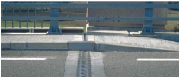
Figure 13 - Abaissement progressif du trottoir en about d'ouvrage
