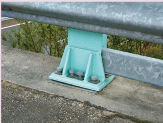
*Desserrage des boulons d'ancrage*
