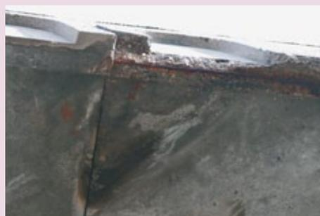
*Écoulements à travers un joint entre deux éléments*
