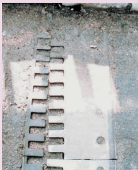
**Gravité :** fonction de l'importance du mouvement. Dans les cas extrême, risque de blocage, lors des dilatations du tablier lorsque les dents sont en vis-à-vis (voir photo ci-dessus), et risque de rupture de dents. Apprécier les risques pour les usagers, notamment pour les deux-roues.
