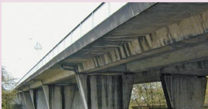
*Ruissellements sur pile en raison d'un défaut d'étanchéité des joints de chaussée – A noter également les venues d'eau sur l'intrados du tablier en provenance des liaisons encorbellements-corniche*
