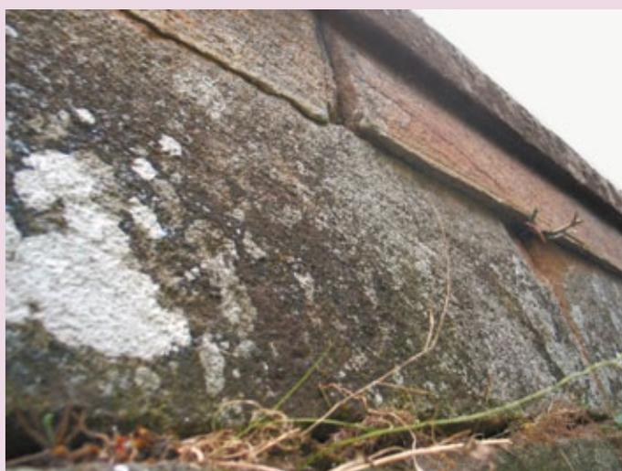
*Disjoints, cavités et descellement de pierres sur la face extérieure du parapet*
