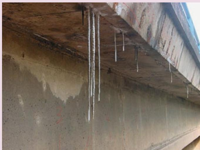
**Gravité :** Moyenne : en percolant à travers le béton l'eau peut également corroder les armatures ; désordre évolutif et donc à traiter à court terme.
