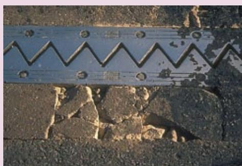
*Dégradation de la zone d'ancrage*
