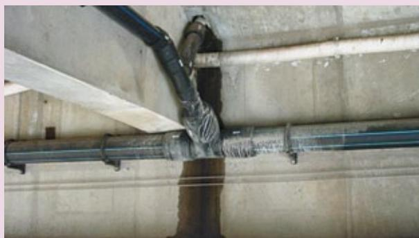
**Gravité :** faible à court terme (problème esthétique) mais risque d'évolution à moyen terme par altération de la partie d'ouvrage (béton d'enrobage, corrosion des armatures de BA et de précontrainte, éléments de structure métallique).
