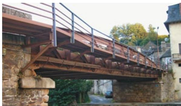
Figure 12 - Ajout d'un trottoir métallique fixé à la structure
