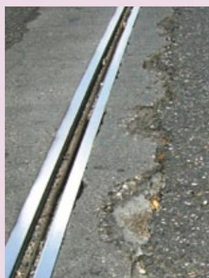
Épaufrures d'un solin béton
