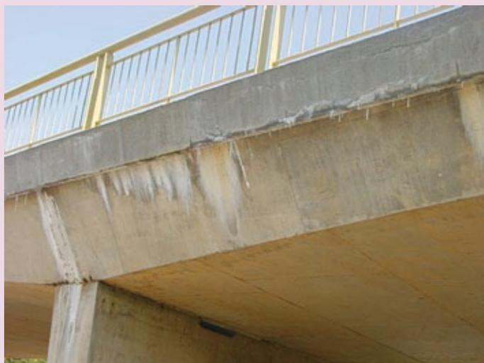
**Gravité :** importante en cas de coulures de rouille traduisant la corrosion des armatures de liaison.
