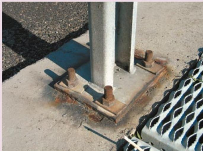
*Corrosion des parties visibles des ancrages*
