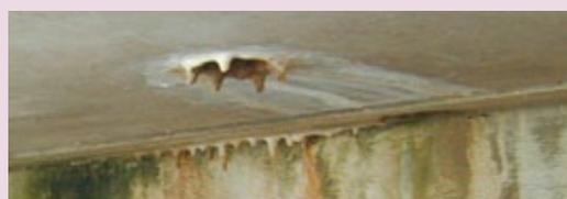
*Raccordement défectueux entre étanchéité et gargouille*
