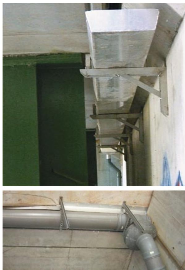
Figure 30 - Mise en place d'un dispositif de récupération des eaux sous le joint de chaussée et les joints de trottoirs
