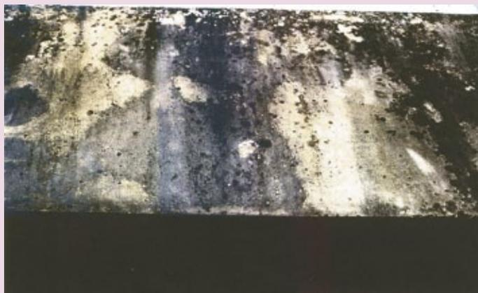
**Gravité :** faible à court terme ; assez importante à plus long terme car ces désordres peuvent être à l'origine d'une corrosion des armatures engendrant des éclats de béton.
