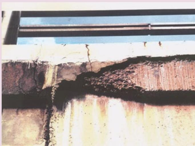
**Gravité :** à apprécier en fonction de l'origine du désordre ; peut être grave s'il y a un risque de chute d'élément de béton ou un risque de descellement du garde corps. Peut être le signe d'un comportement anormal de la structure.
