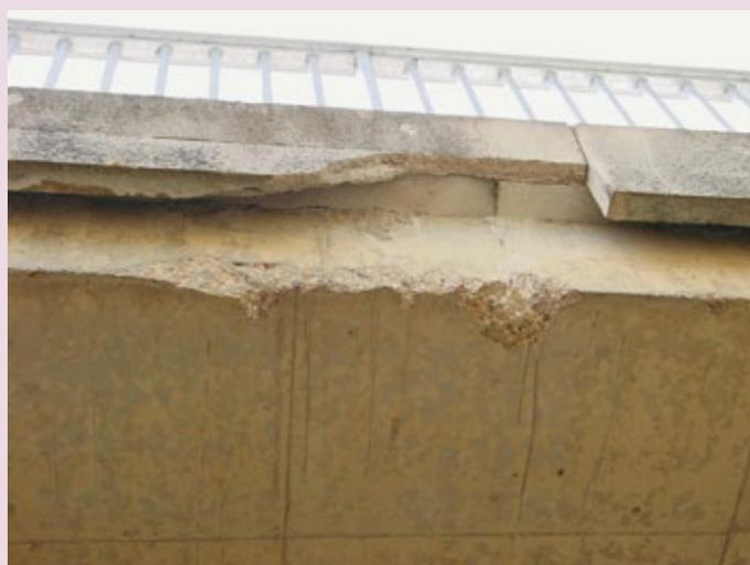
**Gravité :** faible à importante s'il y a un risque de chute d'élément de béton ou un risque de descellement du garde corps.
