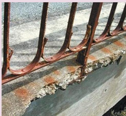
*Dégradation de la zone d'ancrage des montants*
