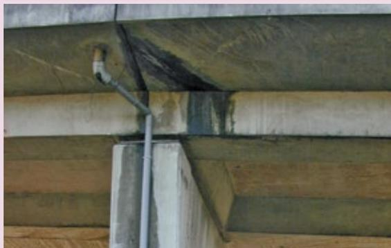
Ruissellements d'eau vers les zones d'appui (appareils d'appui d'une culée, sur le fut d'une pile)
