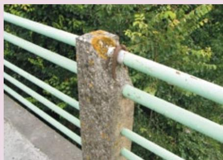
*Blocage de la dilatation entre les lisses et les poteaux*
