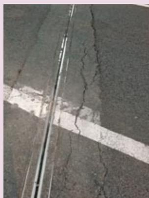
Fissuration d'un solin béton
