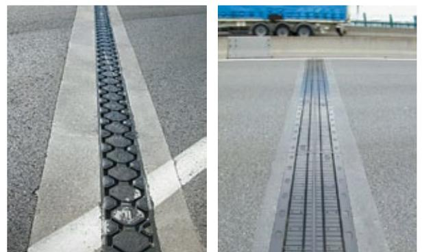
Figure 19 - Exemples de joints à bande : simple à gauche et multiple à droite
