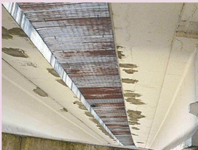
**Gravité :** variable si la corrosion est faible, peu grave, sinon la tenue de la pièce et donc la sécurité des personnes peut être mise en cause.
