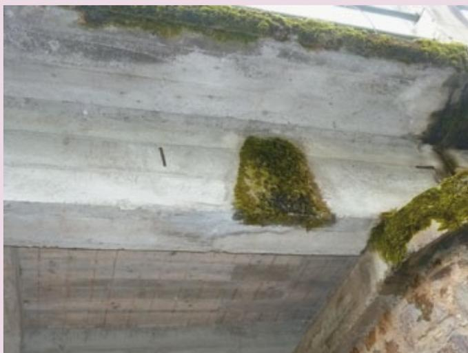
**Gravité :** de peu importante à très importante, en fonction du type de la structure sous-jacente (précontrainte) et des infiltrations d'eau générées.
