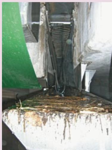
*Cunette de récupération des eaux sous le joint obturée, avec ruissellements importants sur l'about du tablier*
