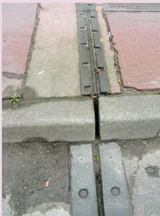
**Gravité :** variable selon l'importance du défaut d'étanchéité et des parties d'ouvrage affectées par les venues d'eau (zone d'ancrage de la précontrainte, appareils d'appui).
