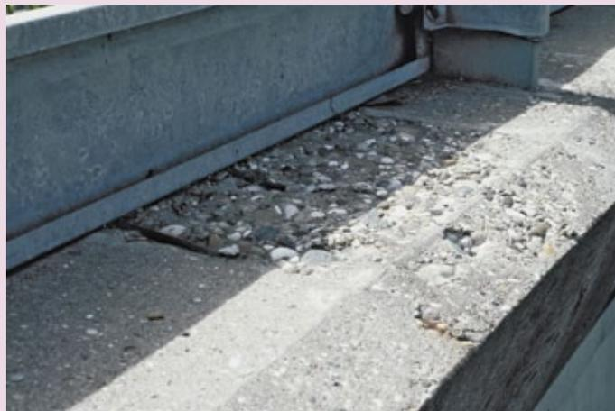
**Gravité :** Variable ; ce processus peut dénuder rapidement les armatures de béton armé et mettre en cause éventuellement la sécurité.
