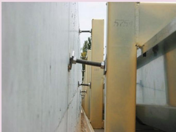
*Mauvaise implantation de rails Halfen® compensée par des chevilles, parfois déformées*
