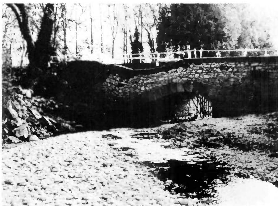
Fig. 11. — Déchaussement de la fondation d'un ouvrage en maçonnerie par des racines d'arbres.
