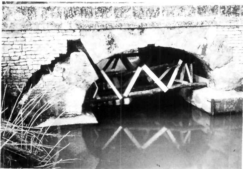
Fig. 7. — Affaissement d'un appui.
