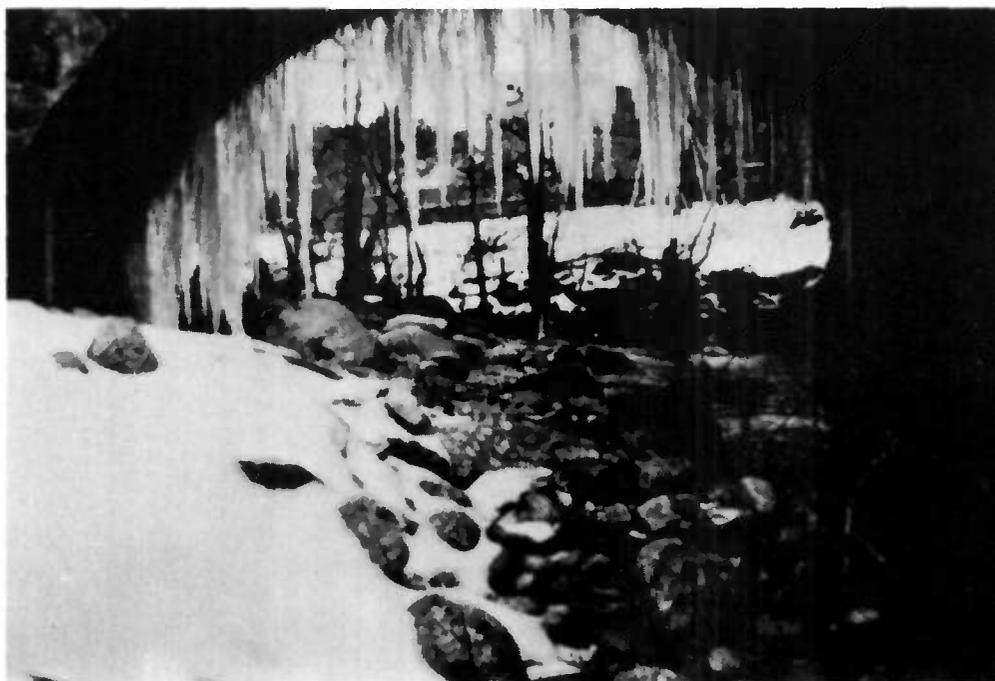
Fig. 8. — Infiltration d'eau et altération des joints sous l'effet du gel.
