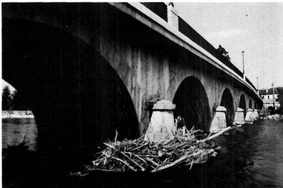
Fig. 15. — Obstacles solides formant écran et générateurs d'affouillement.
