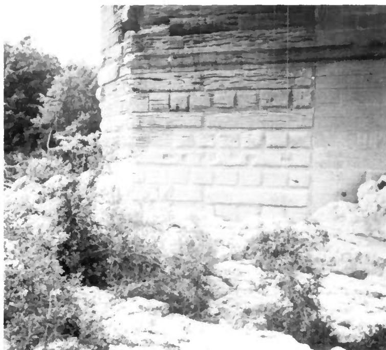
Fig. 10 — Erosion des pierres calcaires d'un parement de pile.
