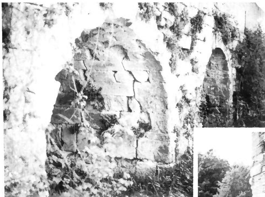
Fig. 9 — Altération des joints de maçonnerie et disparition de moellons d'une voûte.
