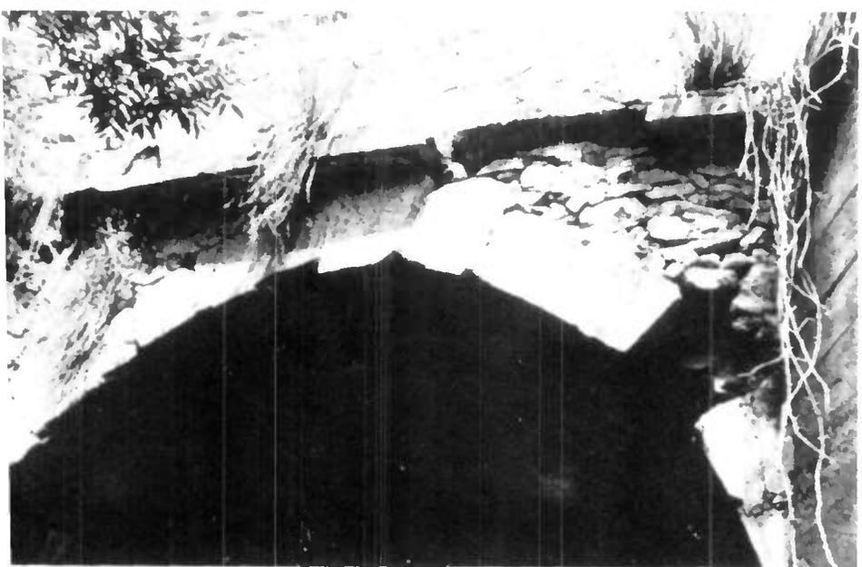
Fig. 4. — Décollement et chute d'un moellon du bandeau.
