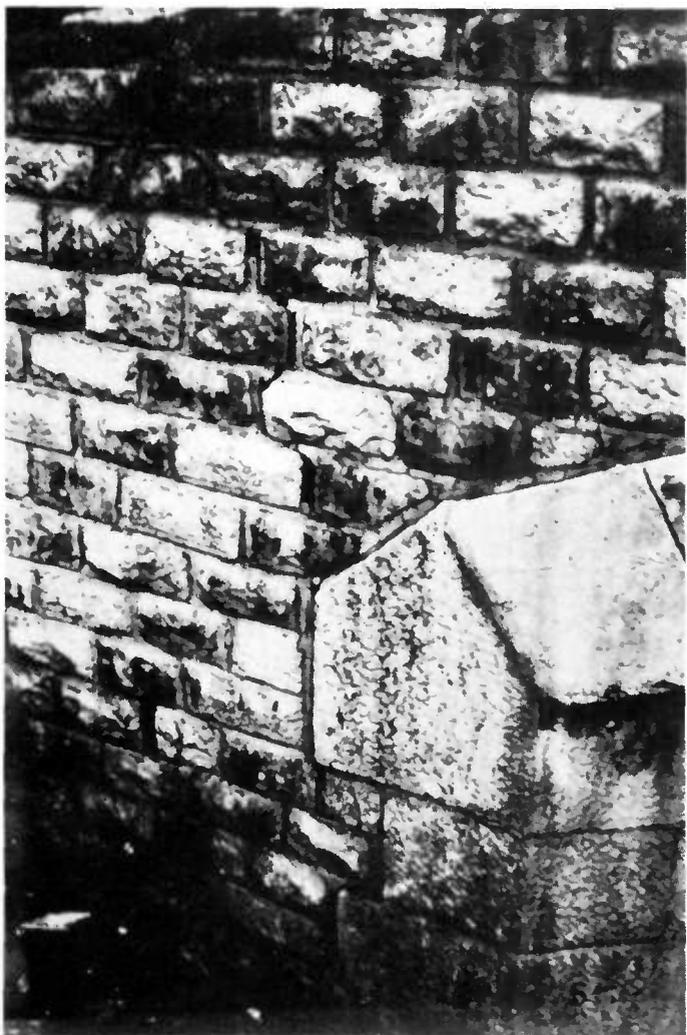
Fig. 5. — Fissure verticale du tympan au voisinage de la naissance d'une voûte.
