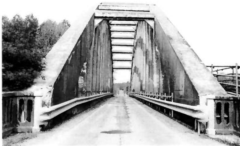
Fig. 28. — Encastrement des arcs et des tirants d'un bow-string (DREIF-DESRET).
