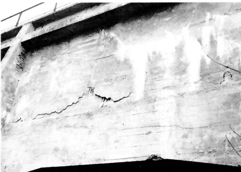
Le foisonnement de la rouille provoque à la périphérie des armatures des contraintes importantes, le béton d'enrobage se fissure puis se décolle laissant l'armature définitivement sans protection (fig. 45).
