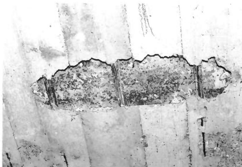
Fig. 53. — Pont à poutrelles enrobées : décollement du béton sous les poutrelles.
