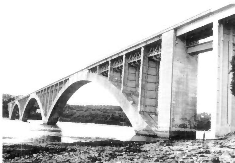
Fig. 18. — Pont en arc à tablier supérieur.
