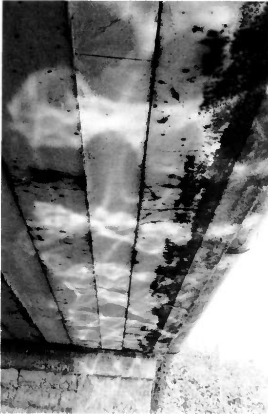
*b) Dans les tabliers plus modernes, les faces inférieures des poutrelles sont apparentes et sont, de ce fait, sensibles à la corrosion qui peut provenir de l'extérieur par condensation (fig. 54), ou de l'eau ayant cheminé à travers le béton, en cas de la défaillance de la chape d'étanchéité.*
