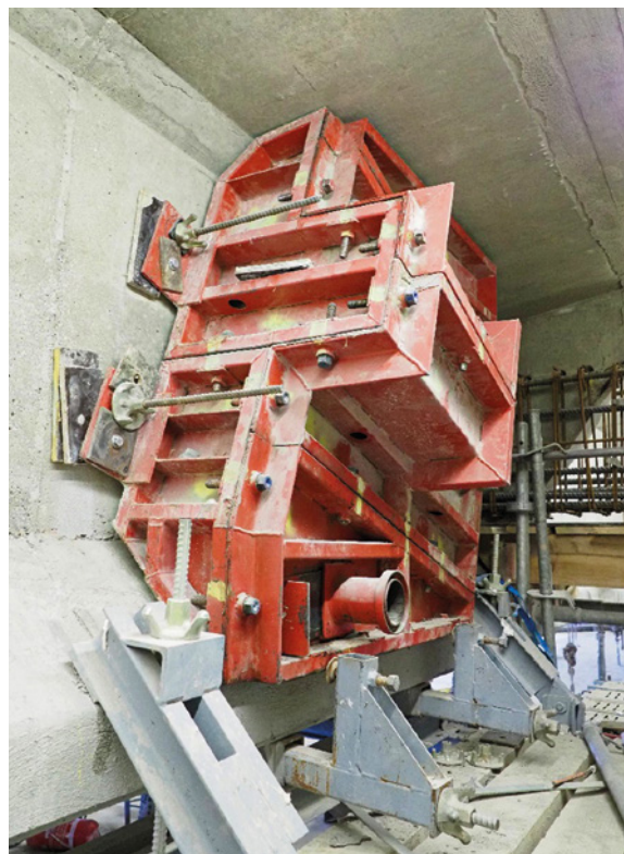
Photos 111a et 111b : Préparation de surface avant réalisation du bossage d'ancrage de la précontrainte additionnelle (pont du Château-Rouge MEL)
