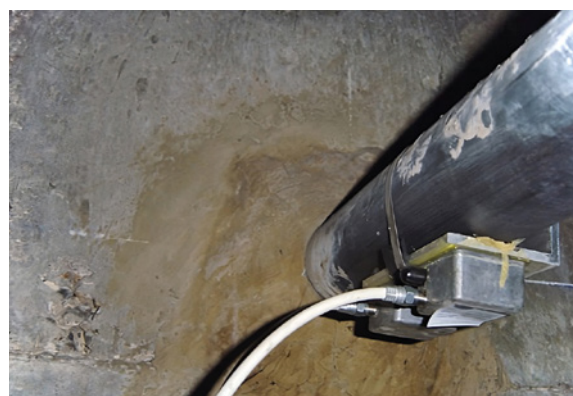
Photo 102 : Surveillance acoustique de câbles extérieurs
