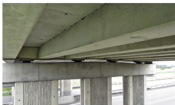
Photo 29 : Pont à poutres PRAD
