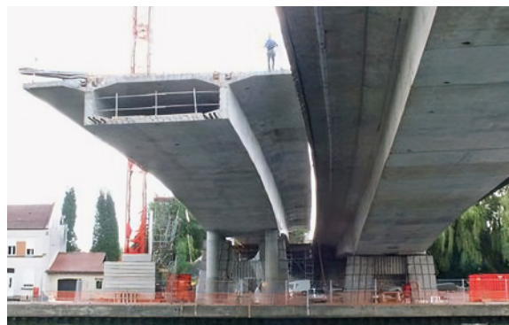
Photo 21 : Ouvrage construit par encorbellements successifs
