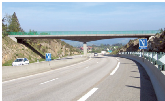
Photo 25 : PSDP à dalle nervurée de hauteur variable
