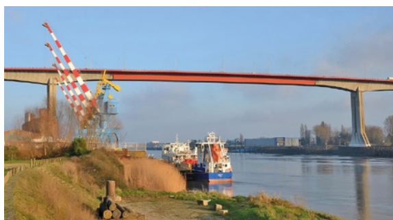
Photo 34 : Un grand ouvrage à travée cantilever métallique : consoles en béton précontraint, travée centrale métallique
