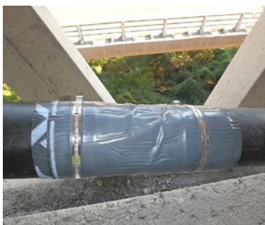
Photo 82 : Application de cire pétrolière et protection provisoire
