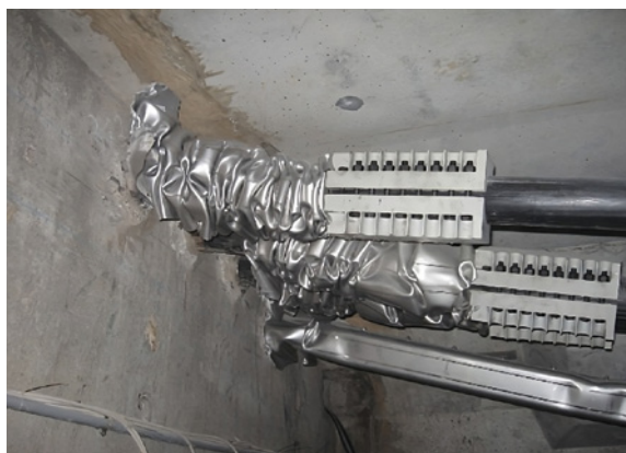
Photo 77 : Sanglage de câbles de précontrainte extérieure
