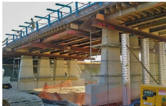
Photo 112 : PSDP construit sur cintre
