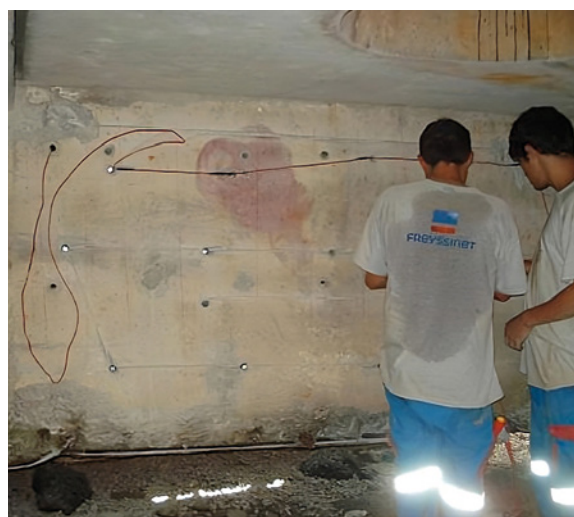
Photo 108 : Mise en œuvre d'anodes discrètes sur un ouvrage précontraint
