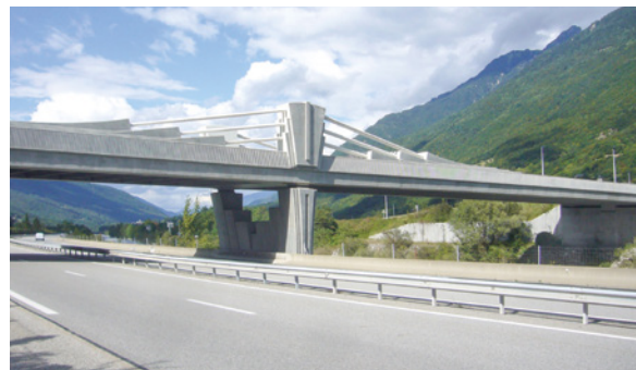
Photo 20 : Pont à précontrainte extradossée
