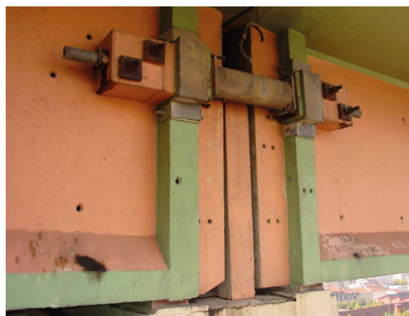
Photo 28 : Attelage de poutres de VIPP par butons-tirants (les bétons sont peints)
