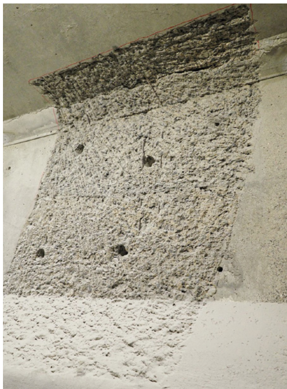
Photos 111a et 111b : Préparation de surface avant réalisation du bossage d'ancrage de la précontrainte additionnelle (pont du Château-Rouge MEL)
