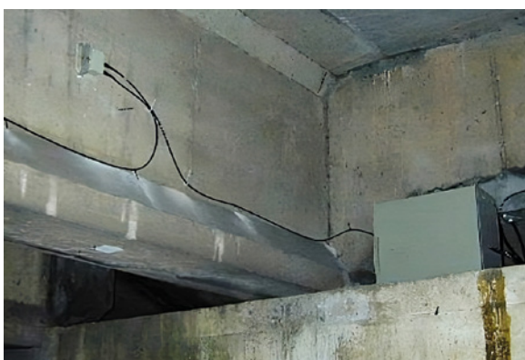
Photo 101 : Surveillance acoustique de câbles intérieurs
