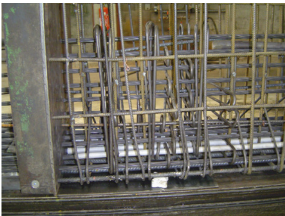
Photo 2 : Banc de préfabrication poutre PRAD (à gauche, on remarquera le gainage de torons près de l'appui)
