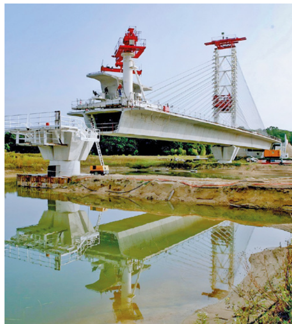
Photo 115 : Pont construit à l'avancement avec haubannage provisoire
