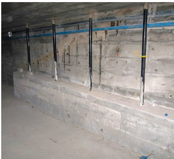
Photo 13 : Précontrainte transversale (verticale) additionnelle à l'intérieur de la structure
