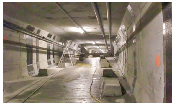
Photo 36 : Précontrainte longitudinale additionnelle complétée par collage de matériaux composites sur les âmes
