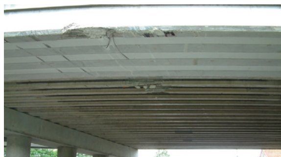
Photo 69 : Rebond sur une poutre intermédiaire
