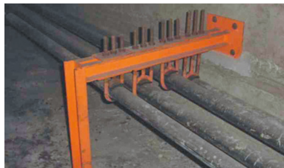
Photo 15 : Dispositif antivibratoire sur une précontrainte extérieure de poutre-caisson
