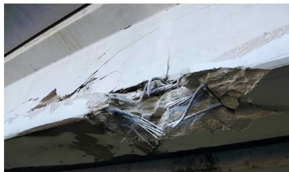
Photo 69 : Rebond sur une poutre intermédiaire
