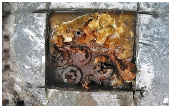
Photo 40 : Corrosion généralisée, sous une circulation d'eau sous gaine
