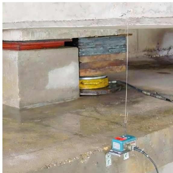
Photo 89 : Pour mémoire : Vérin plat de levage dit « vérin plat », levage à l'huile hydraulique, fossilisation au coulis de ciment, usage unique, non réversible et donc non étalonnable. Ce type de vérin est donc peu précis en mesure mais peut être utilisé en calage
