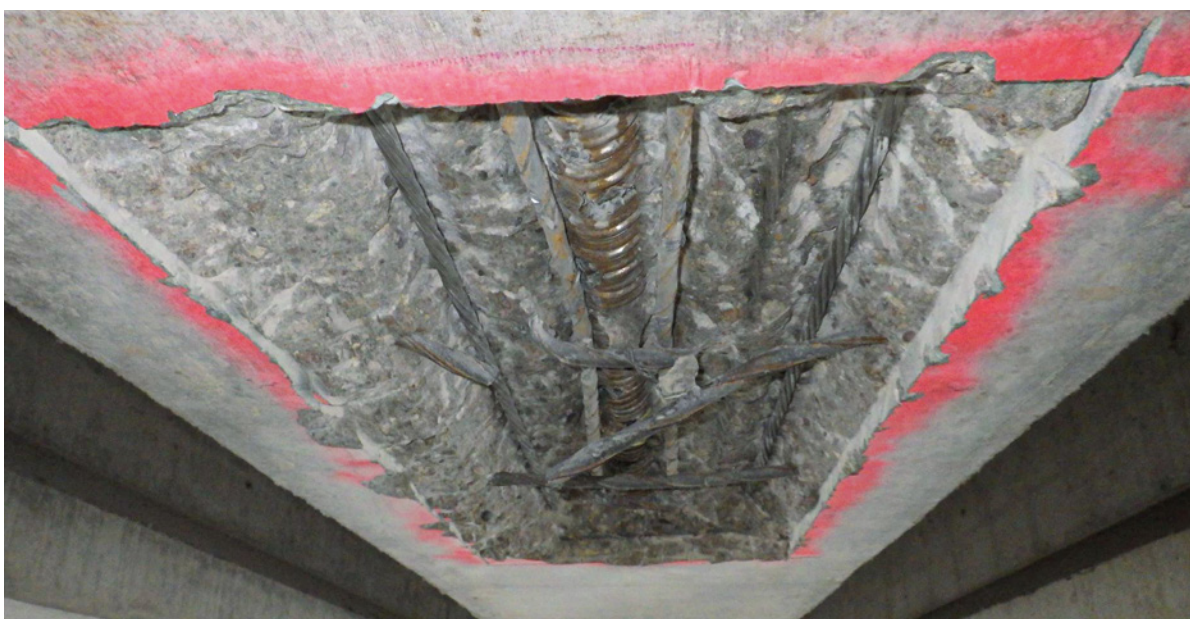
Photo 73 : Ouverture d'une fenêtre en intrados
