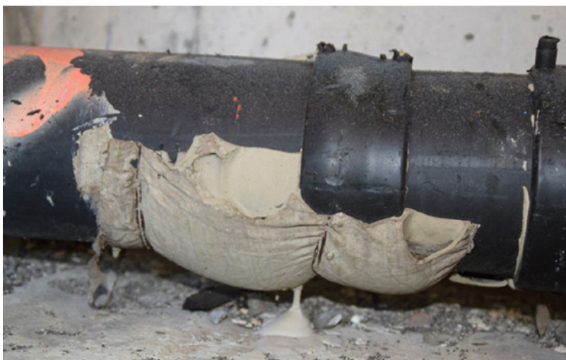
Photos 80a et 80b : Raccordements suspects. Ces manchons très courts sont particulièrement susceptibles de présenter des défauts d'étanchéité puis des coulures de ciment
