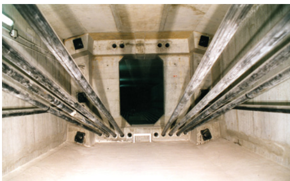
Photo 11 : Précontrainte extérieure longitudinale à l'intérieur de la structure
