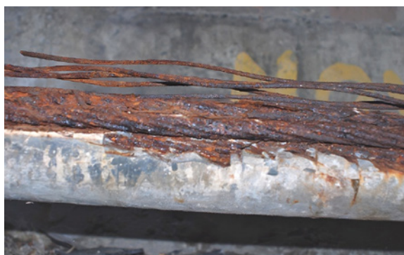
Photo 40 : Corrosion généralisée, sous une circulation d'eau sous gaine
