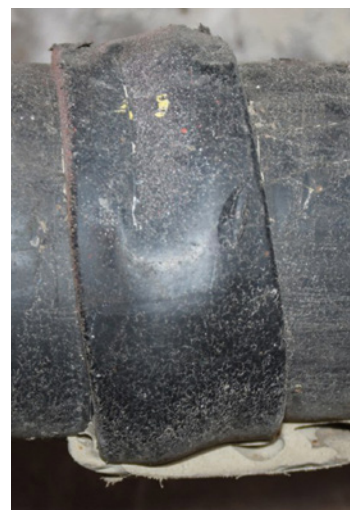
Photos 80a et 80b : Raccordements suspects. Ces manchons très courts sont particulièrement susceptibles de présenter des défauts d'étanchéité puis des coulures de ciment
