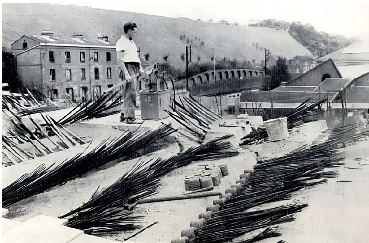
Photo 4 : Le pont de Paris à Beauvais construit en 1952. Illustration des dispositions technologiques de l'époque : grand nombre de câbles, sorties de câbles 12 \varnothing 5 en extrados
