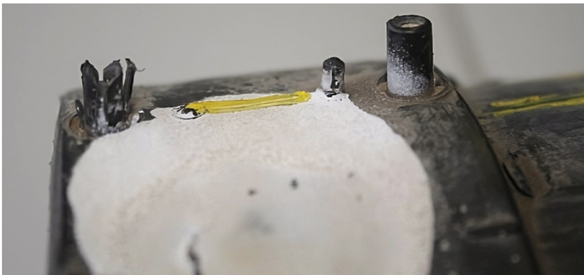
Photos 80a et 80b : Raccordements suspects. Ces manchons très courts sont particulièrement susceptibles de présenter des défauts d'étanchéité puis des coulures de ciment
