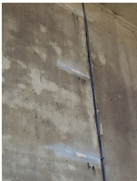
Photo 86 : Une « verticale » de jauges électriques sur l'âme d'un caisson
