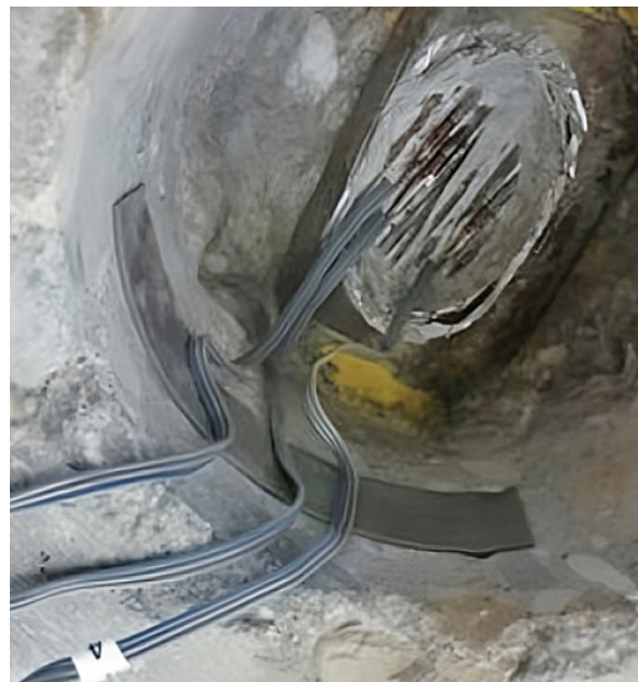
Photo 105 : Jauges de déformation sur des torons
