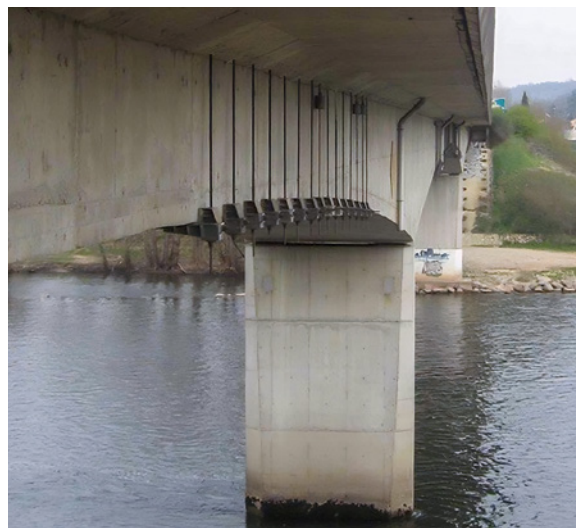
Photo 14 : Précontrainte transversale (verticale et horizontale) additionnelle à l'extérieur de la structure
