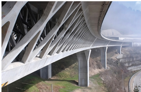
Photo 33 : Caisson à diagonales précontraintes et précontrainte longitudinale extérieure
