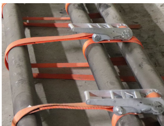
Photo 77 : Sanglage de câbles de précontrainte extérieure
