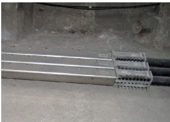
Photo 76a : Amortisseur (brevet LCPC) avant rupture
