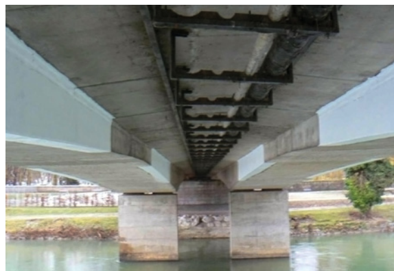
Photo 109 : Ouvrage en caisson précontraint réparé vis-à-vis de l'effort tranchant
