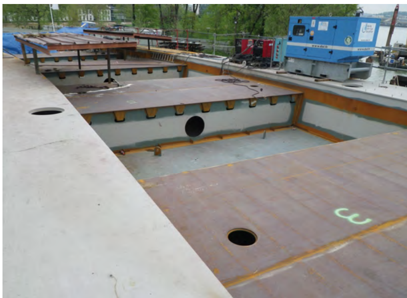
Illustration 50 : Dalle orthotrope en cours de montage
