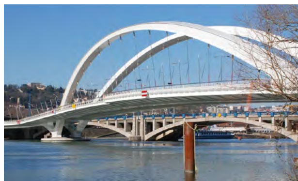
Illustration 55 : Pont Raymond Barre à Lyon Arc à tablier inférieur
