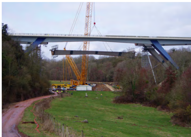
Illustration 68 : Pont à béquilles
