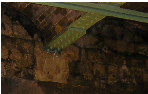
Illustration 166 : Renforcement de poutre en fer – Gare de Luxembourg
