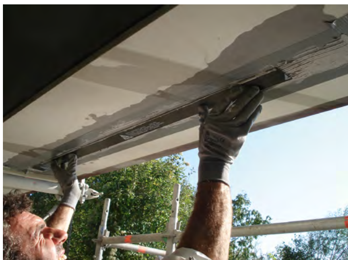
Illustration 158 : Mise en œuvre d'une lamelle de composite en sous face d'une poutre
