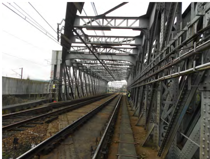
Illustration 60 : Pont cage
