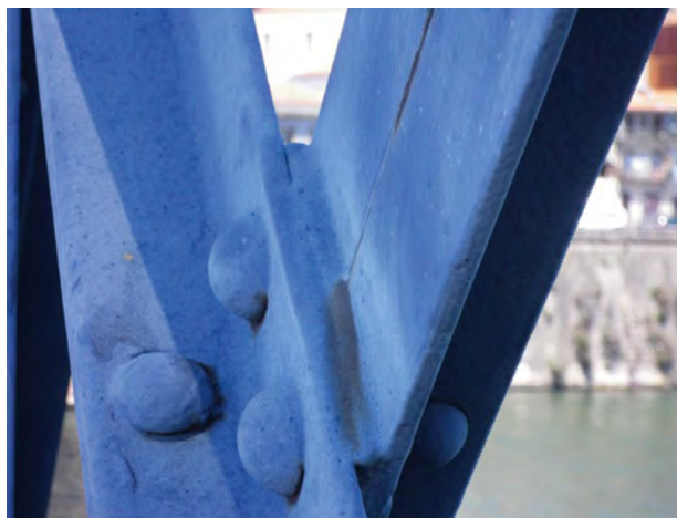
Illustration 34 : Exemple de fourrure
