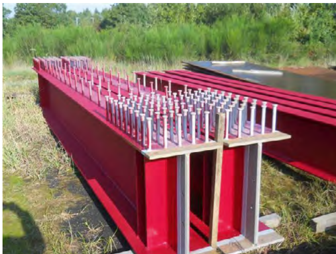
Illustration 39 : Pièces de pont avec goudjons connecteurs
