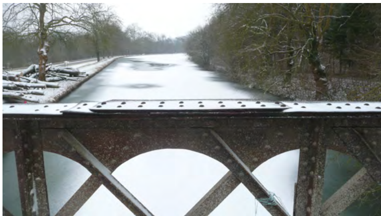
Illustration 22 : Couver-joint de semelle
