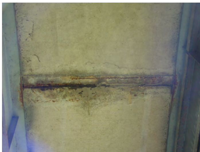
Illustration 117 : Pont de Frouard (ouvrage construit en 1967-1968)
