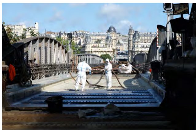
Illustration 133 : Mise en œuvre d'une étanchéité liquide projetée à chaud à base de résines en polyuréthane
