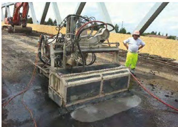
Illustration 130 : Vue du décapage robotisé d'une dalle orthotrope à l'eau sous ultra haute pression (UHP)
