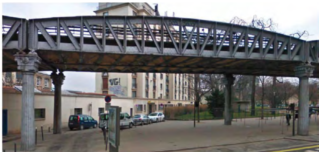
Illustration 61 : Pont RATP à poutres latérales de type Pratt
