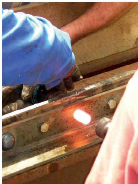
Illustration 18 : Pose d'un rivet à chaud
