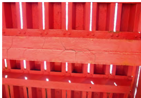
Illustration 16 : Viaduc de Garabit : platelage en fer Zorès
