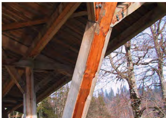
Illustration 115 : Exemple de grisonnement du bois exposé à l'air libre
