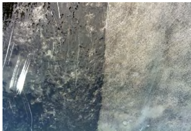
Illustration 131 : Détail du décapage par UHP (avant, à gauche et après, à droite passage du robot)
