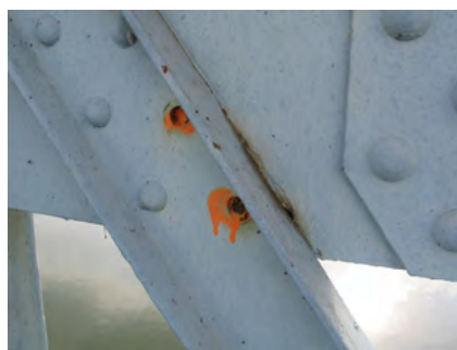
Illustration 122 : Rivets manquants sur diagonale
