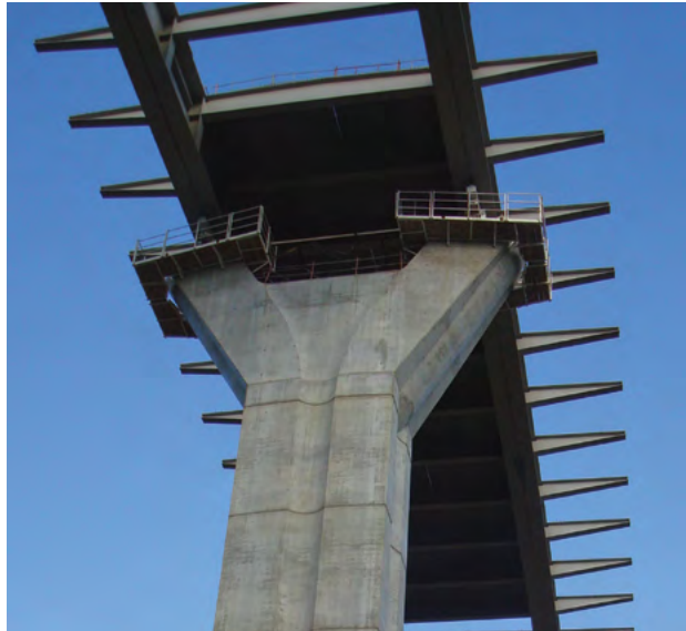
Illustration 63 : Pont à pièces de pont et consoles
