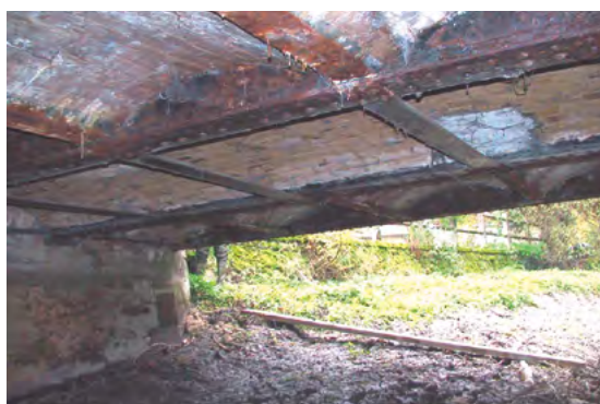
Illustration 116 : Étanchéité défaillante
