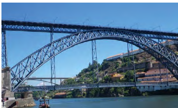
Illustration 54 : Pont sur le Douro (Portugal) Arc à tabliers supérieur et inférieur
