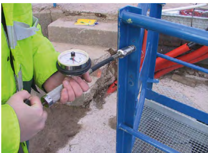
Illustration 144 : Essai d'adhérence sur peinture de garde-corps suivant la norme ISO 4624
