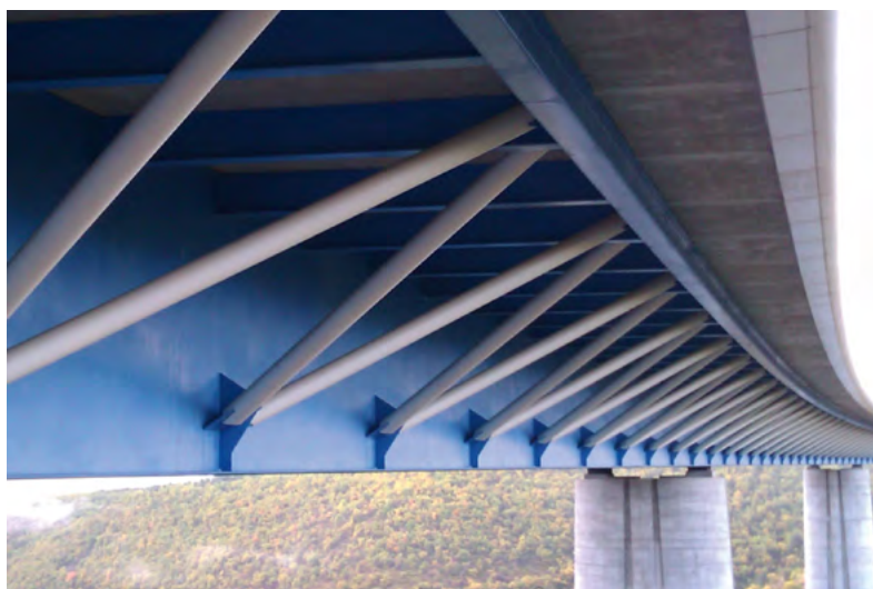
Illustration 66 : Encorbellement avec des bracons
