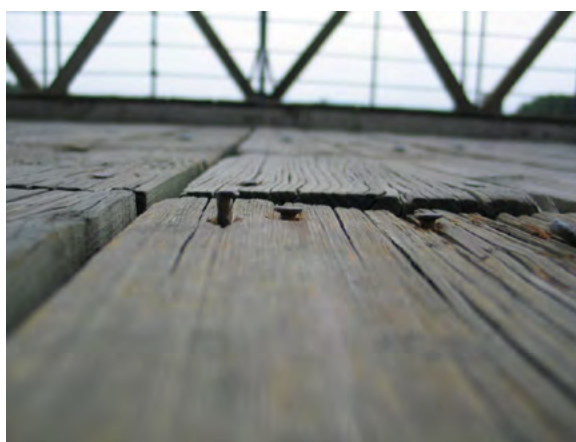
Illustration 113 : Exemple de battement de lattes
