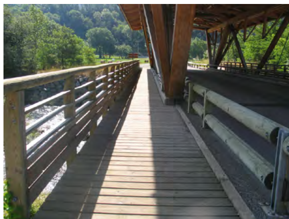
Illustration 111 : Exemple d'un platelage en bois
