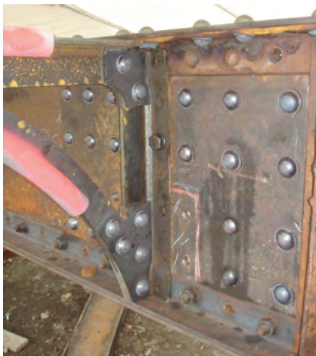
Illustration 149 : Réfection d'un assemblage riveté
