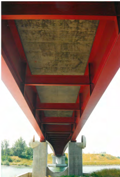
Illustration 62 : Ouvrage de type bipoutre à entretoises
