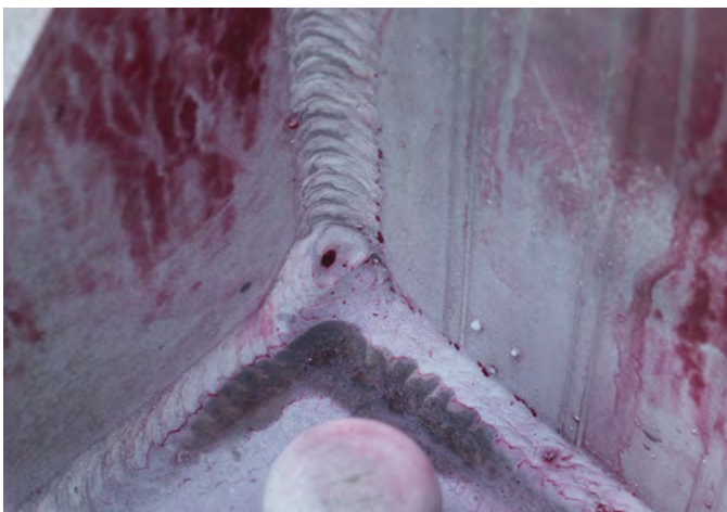
Illustration 138 : Contrôle d'un assemblage soudé par ressuage
