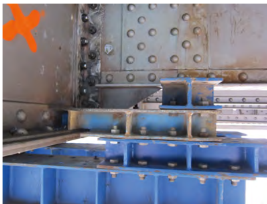
Illustration 151 : Calage d'un ouvrage pendant travaux
