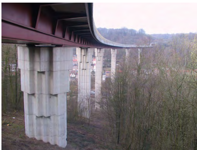
Illustration 67 : Pont caisson
