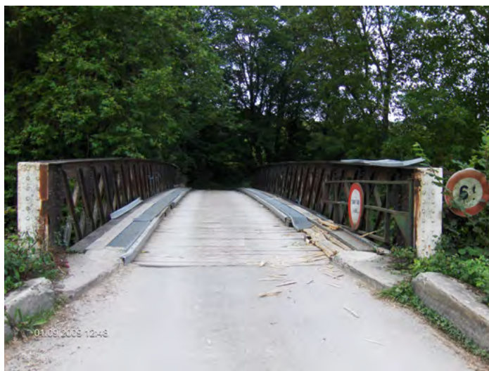
Illustration 40 : Pont à platelage en bois
