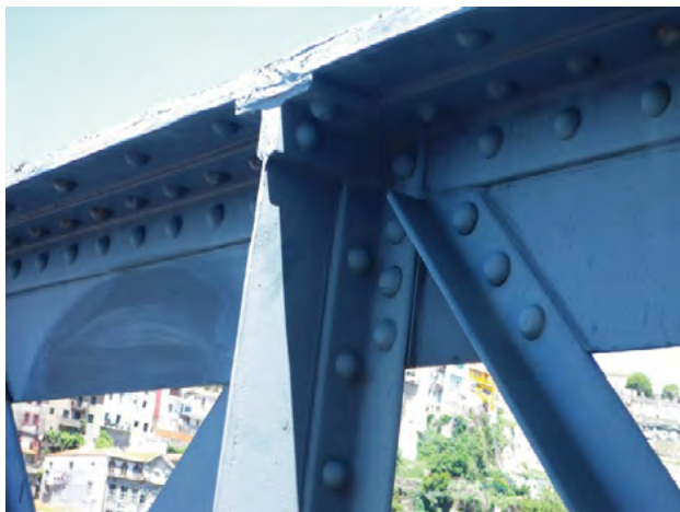
Illustration 33 : Exemple d'assemblage au niveau d'un montant
