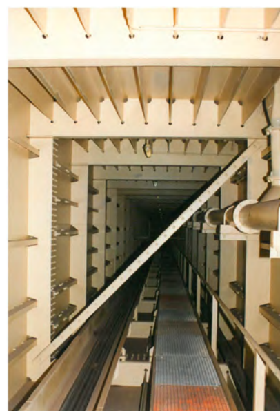
Illustration 51 : Dalle orthotrope sur caisson
