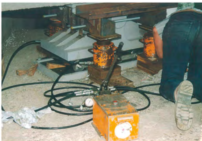
Illustration 136 : Réfection d'appareil d'appui métallique avec changement des rouleaux
