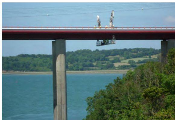
Illustration 1 : Inspection d'un ouvrage
