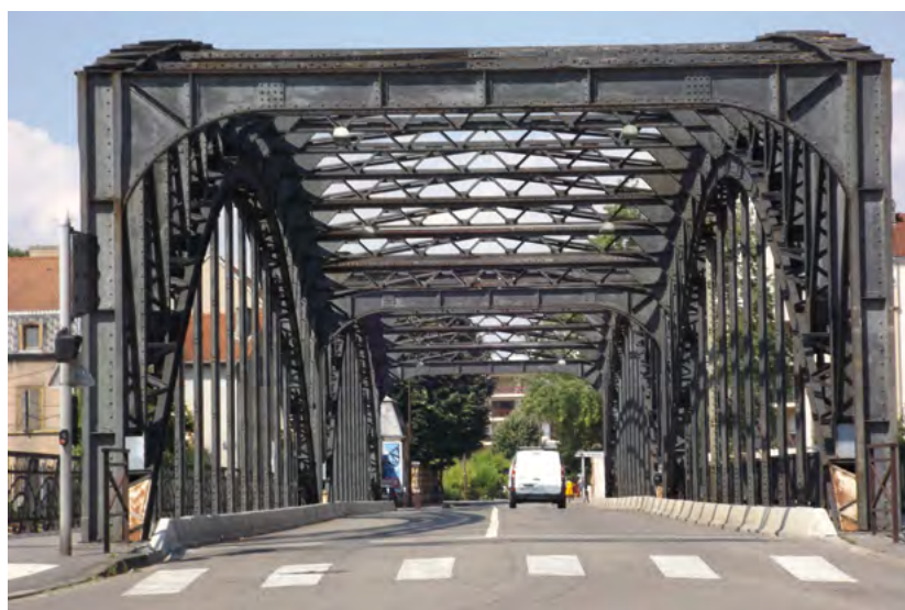
Illustration 36 : Pont cage
