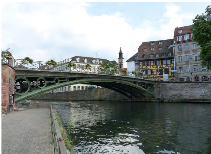
Illustration 2 : Le pont St Thomas à Strasbourg (arc en fonte)
