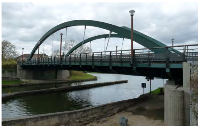
Illustration 71 : Ouvrage de type bow-string
