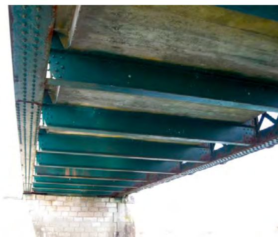
Illustration 46 : Dalle sur pièces de pont
