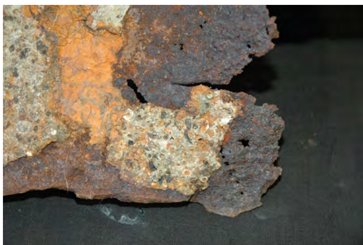
Illustration 93 : Exemple de biocorrosion sur pieu métallique (Photo. C. Dagbert)
