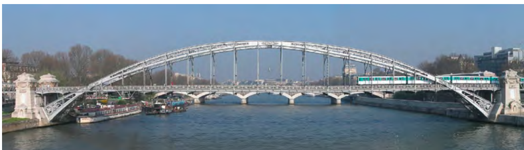
Illustration 53 : Pont d'Austerlitz à Paris. Arc à tablier intermédiaire
