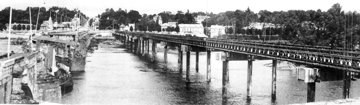
Fig. 1 - Pont provisoire franchissant la Loire à Tours, mis en place à la suite de la ruine partielle du Pont Wilson le 9 avril 1978.
