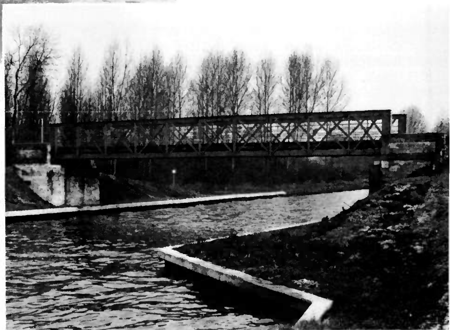
Fig. 3 - Pont à treillis métalliques d'origine non déterminée.
