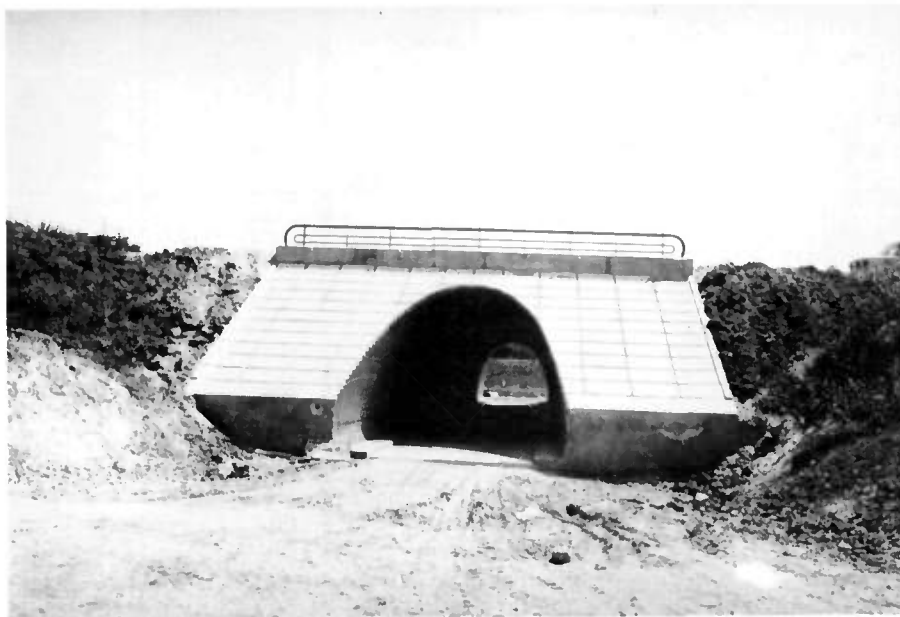
Fig. 3 - Passage inférieur routier en buse métallique avec un important ouvrage d'extrémité.
