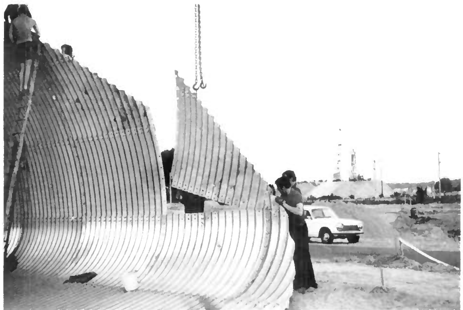
Fig. 2 - Montage d'une plaque d'extrémité coupée en biseau sifflet suivant le plan du futur talus.
