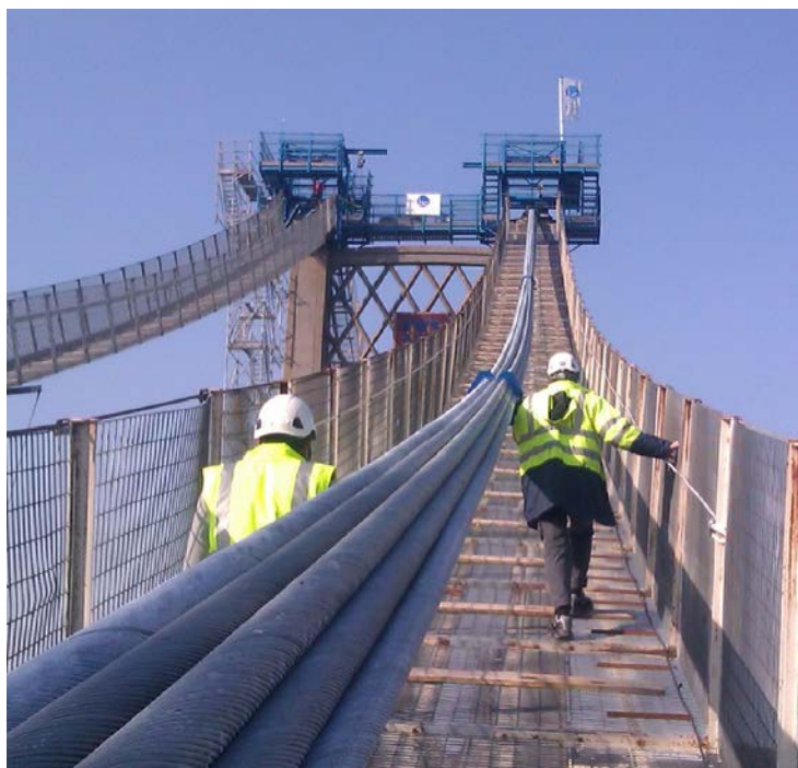
Figure 7 : Conduire un chantier en sécurité se prépare...
