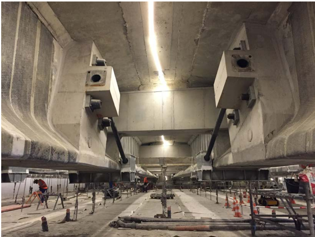
Figure 2 : Réparation d'un VIPP par précontrainte additionnelle, entretoises additionnelles et fibre de carbone collée sur un platelage général suspendu (ouvrage MEL)
