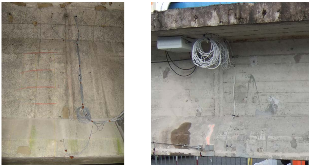
Figure 13a 13b : Mesures de gradients thermiques sur ouvrage afin d'affiner les hypothèses de calcul
