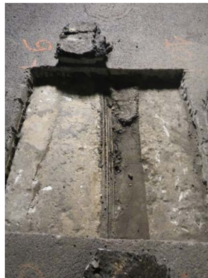
Figure 6 : Ouverture de fenêtre en chaussée pour reconnaissance
