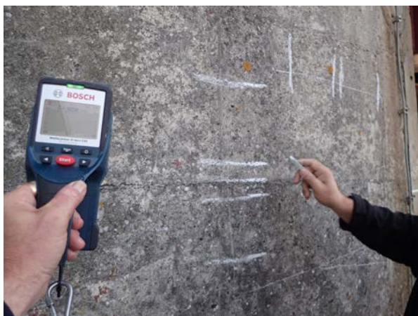
Figure 16a : Repérage d'armatures
