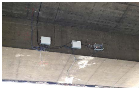
Figure 18b : Suivi de tension dans les câbles de précontrainte : évaluation des surtensions subies.
