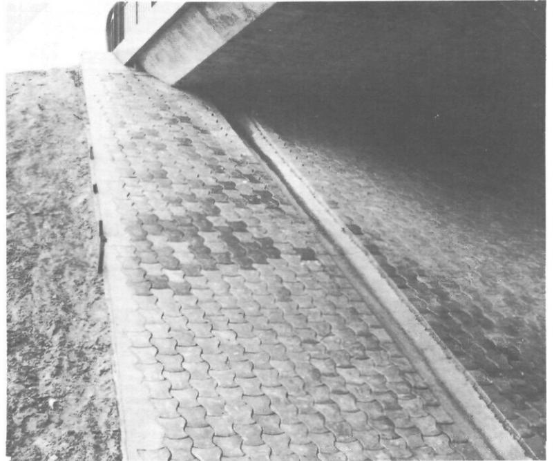
fig. 3 Pavés préfabriqués type TRIEF avec descente d'eau intégrée et bordure coulée.
