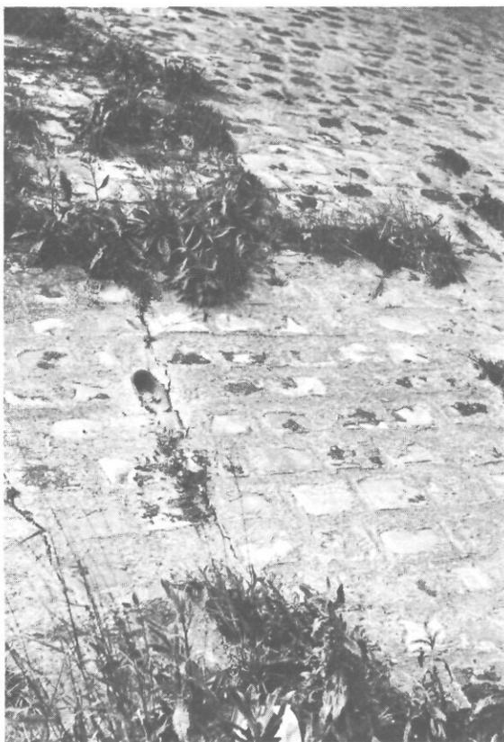
fig. 7 La végétation a pu reprendre malgré la maçonnerie qu'elle va disloquer: perré probablement inutile.
