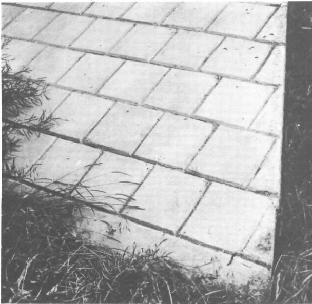
fig. 2 Pavés préfabriqués carrés avec bordure coulée.
