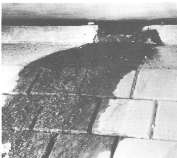
fig. 9 Absence de descente d'eau: souillures du perré.
