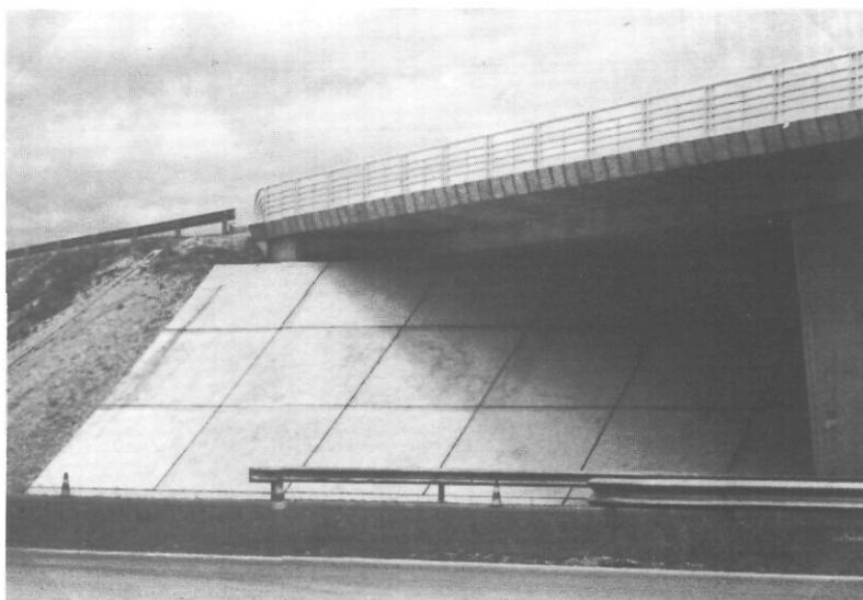
fig. 10 Esthétique très discutée des dalles coulées en place, surface équipée surabondante, dispositions en plan non adaptées à un ouvrage biais.
