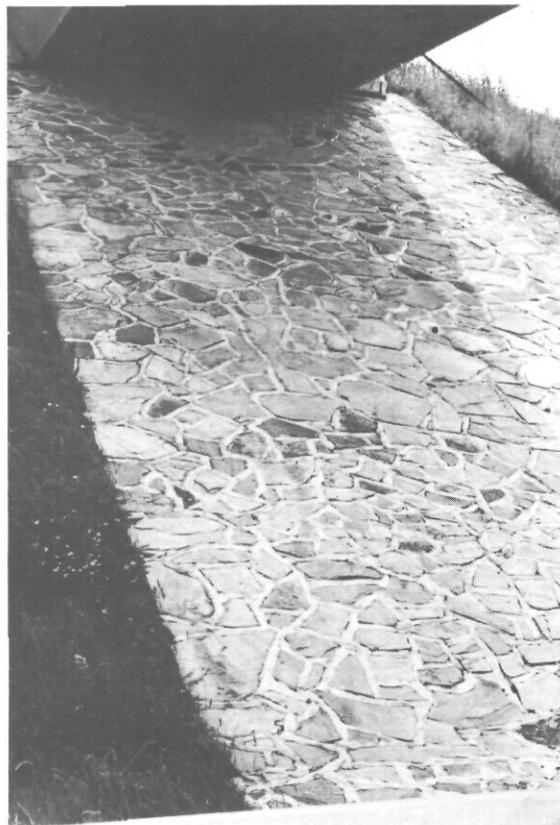
fig. 8 Pont haut et étroit: perré probablement inutile.
