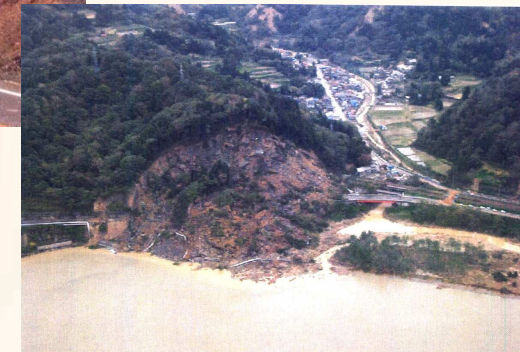
Glissements de terrain
