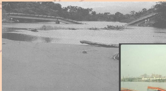
Liquéfaction du sol porteur
