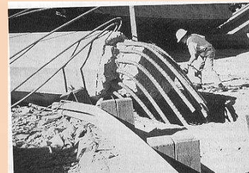
Dispositions d'ancrage des armatures longitudinales
