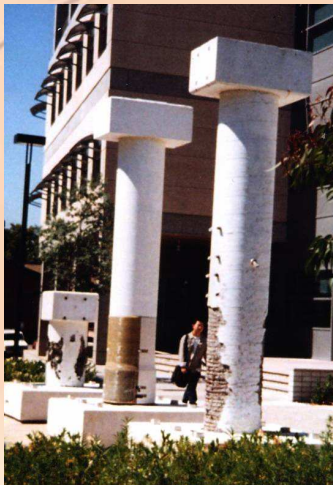
Cas des piles de ponts
