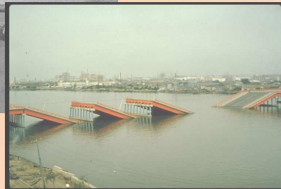
Liquéfaction du sol porteur
