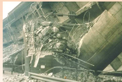
Densité importante d'armatures d'efforts tranchants
