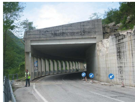
Couverture pare-blocs (SS80)
