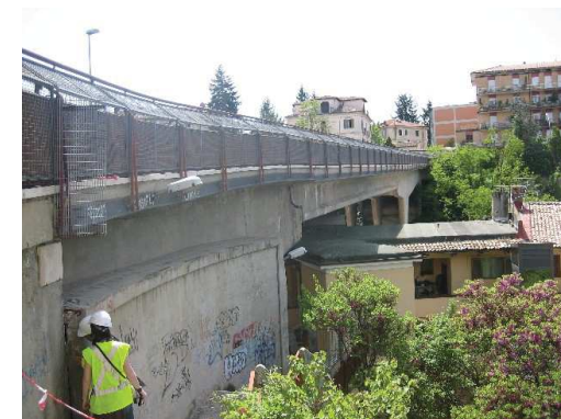
Pont cantilever (centre de l'Aquila)
