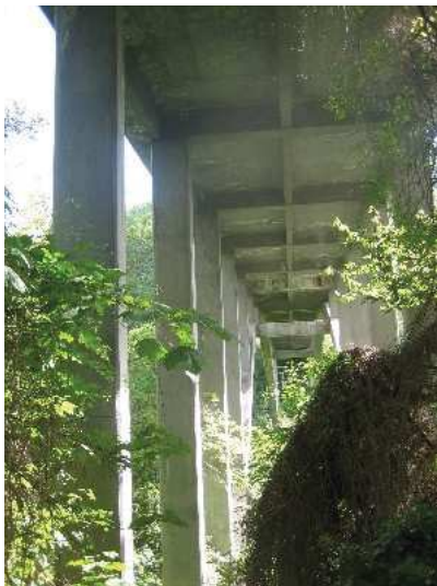
Arc béton (SS80)
