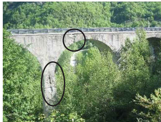
Voûte béton (SS80)
