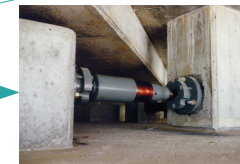
Connecteurs dynamiques prévus sur la ligne TGV Perpignan-Figueras
