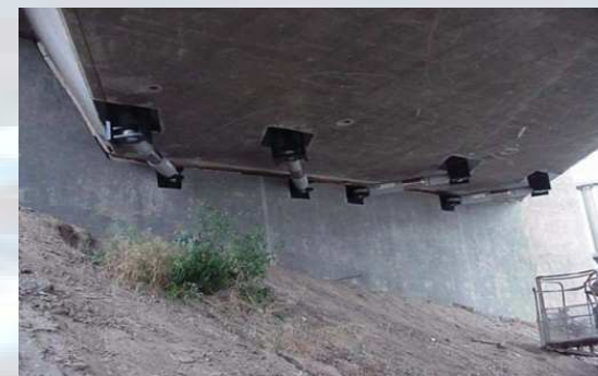
Photo 25 : Disposition « en biais » permettant d'amortir simultanément dans les deux directions
