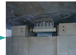
Amortisseurs élasto-plastiques équipant le pont Vasco de Gama (Portugal)
