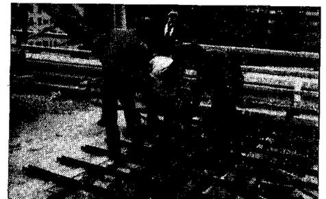
f) Serrage ou mise en tension des ancrages. Mise en oeuvre du solin de raccordement du joint au trait de scie quand il ne s'agit pas de la technique "so-lin béton".
