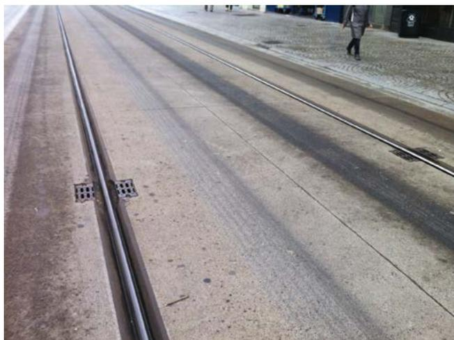
Figure A3-7 : Rail de guidage pour tramway à pneu
