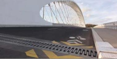
La mise en œuvre de la couche de roulement de la chaussée est ensuite réalisée y compris au droit du joint.
