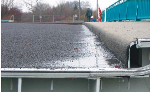
Figure 4-29 : Joints mécaniques fixés sur une tôle supportée par des raidisseurs soudés sur l'âme de l'entretoise d'extrémité
