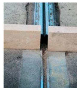
Figure 2-30 : Joints de dilatation sur voiries séparées (joint de chaussée et joint de plateforme)
