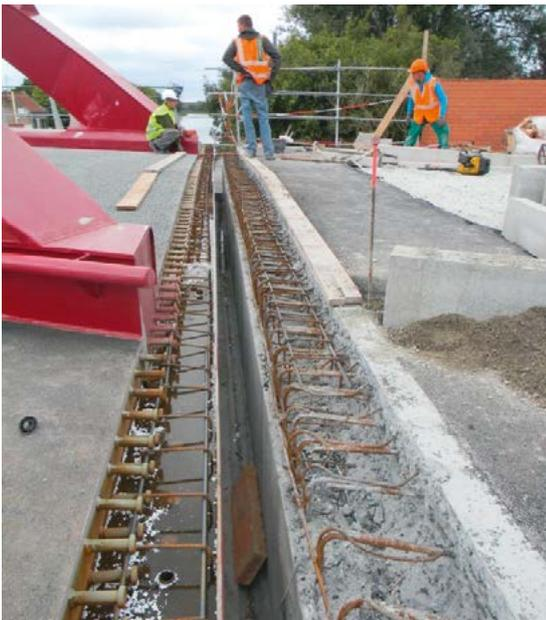
À gauche réservation en tôle en forme de U avec goujons et ferrailage de la longrine de scellement
