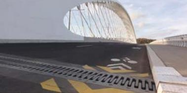
Dans le cas de joint non étanche, le système de récupération des eaux dans le vide du joint tiendra compte d'un apport éventuel d'eau de ruissellement qu'une gargouille située en amont du joint n'aurait pu recueillir en totalité. Toutefois, il est anormal de considérer le joint de chaussée comme un dispositif à part entière d'évacuation des eaux de surface équipant l'about de l'ouvrage ainsi que le montre les photos des figures 2-14 et 2-16.
