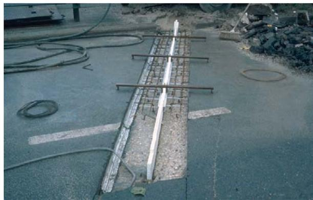
Figure 4-28 : Mise en œuvre d'une longrine en mortier avec scellement d'aciers passifs
