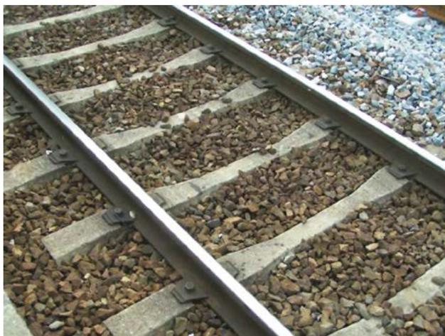
Figure A3-2 : Voie ballastée avec traverse monobloc préfabriquée
