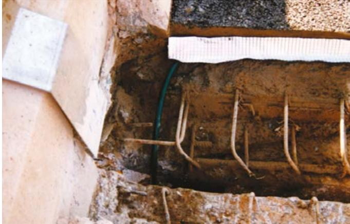
Figure 2-3 : Les difficultés de raccord du drain avec l'évacuation générale des eaux, du relevé du joint et du relevé d'étanchéité dans la zone de la bordure de trottoir
