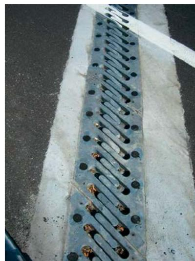
Figure 1-13 : Exemple de joints cantilever : peigne classique à gauche et peigne pour pont très biais à droite
