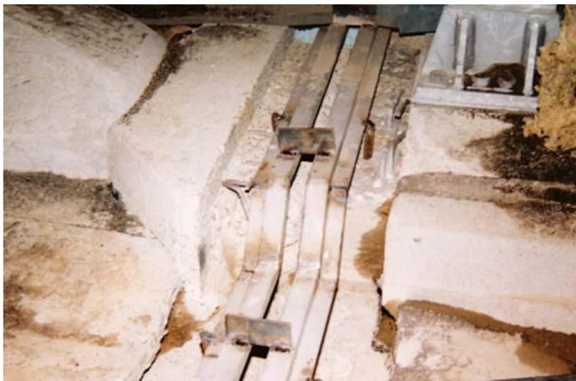
Figure 2-15 : Exemple d'un raccordement about de joint de chaussée/trottoir
