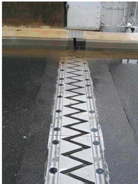
Figure 2-14 : Exemple d'une disposition à éviter : le vide du joint de trottoir sert d'avaloir (absence d'élément de remontée du joint au droit du trottoir, le joint sert de gargouille)
