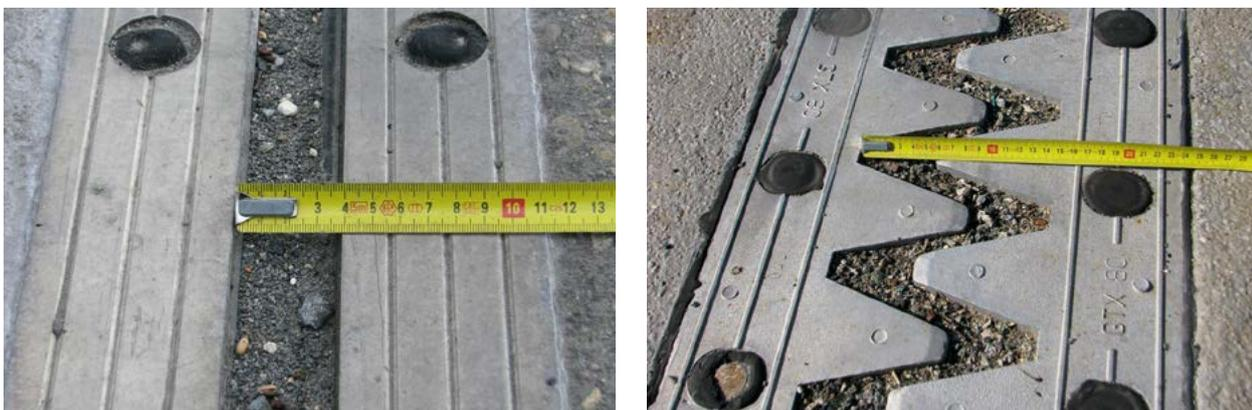
Figure 4-1 : Mesures d'ouverture d'un joint à lèvre (à gauche) et d'un joint cantilever (à droite)
