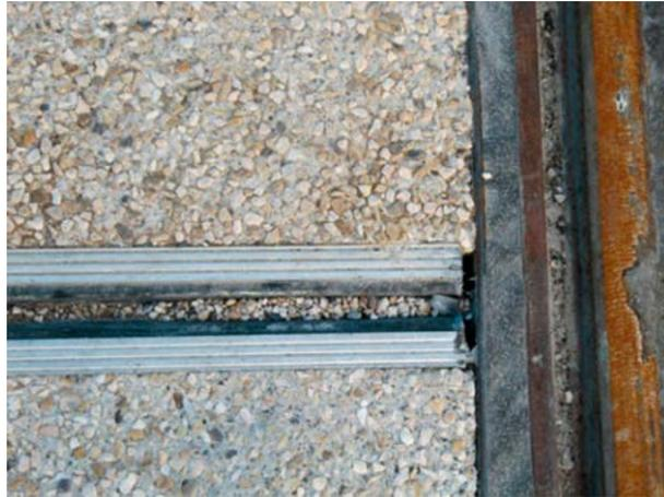
Figure 2-31 : Joint d'étanchéité entre le joint de plateforme et le rail
