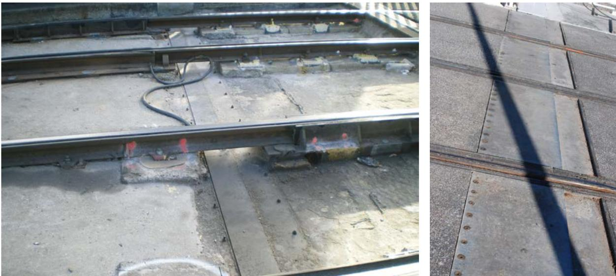
Figure 2-28 : Détail du joint de chaussée au droit du rail
