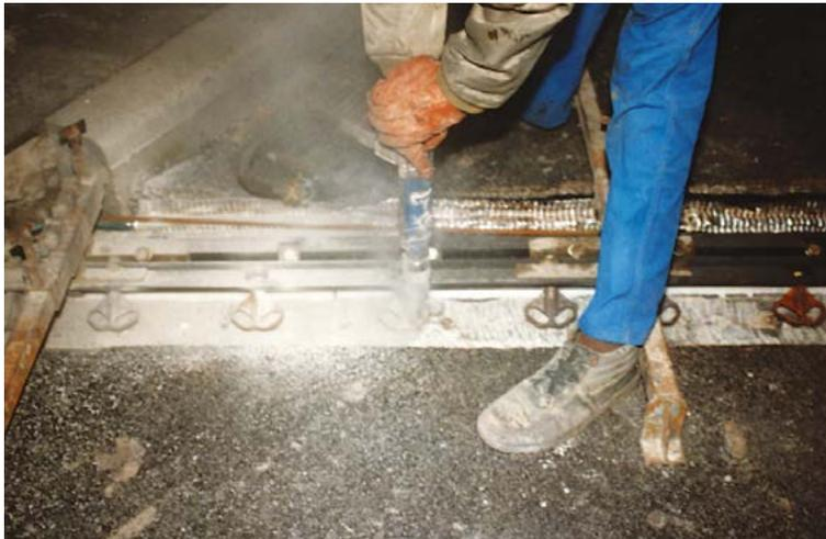
Figure 4-26 : Exécution d'un forage (photo) Préparation de la réservation : percement pour scellement des armatures d'ancrage du joint
