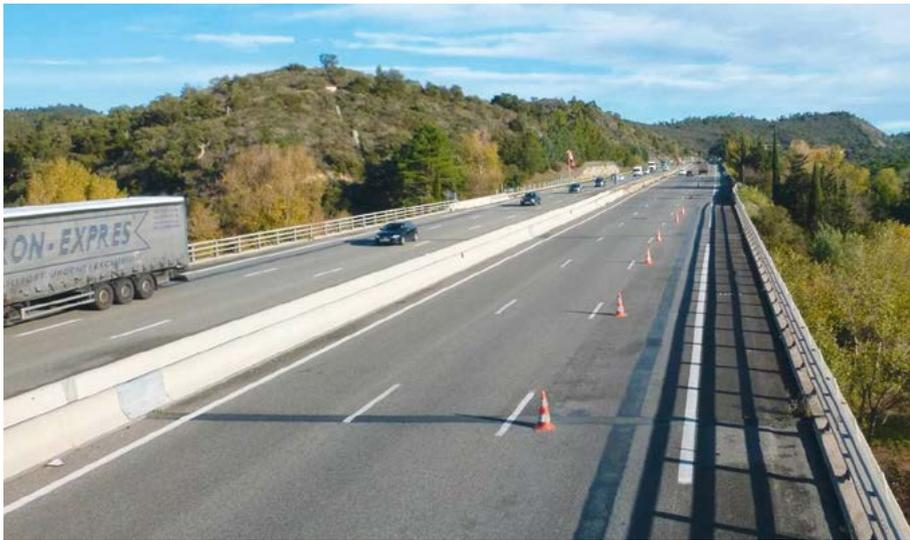
Figure 2-42 : Cas d'un joint longitudinal à revêtement amélioré suite à l'élargissement d'un ouvrage autoroutier
