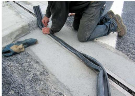
Figure 4-19 : Les étapes de mise en œuvre d'un joint de chaussée mécanique posé en feuillure
