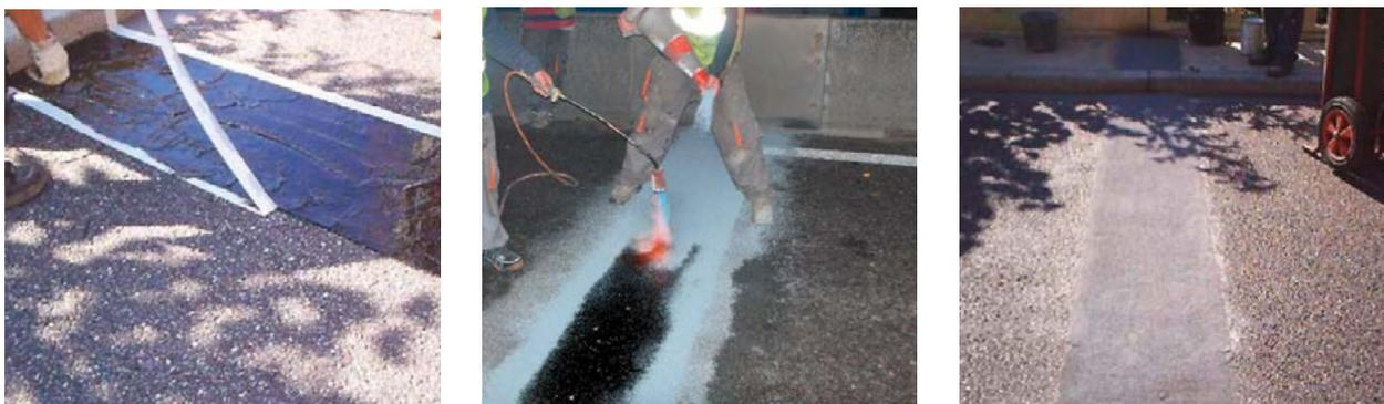
Figure 4-12 : Réalisation de la couche de finition d'un joint à revêtement amélioré
