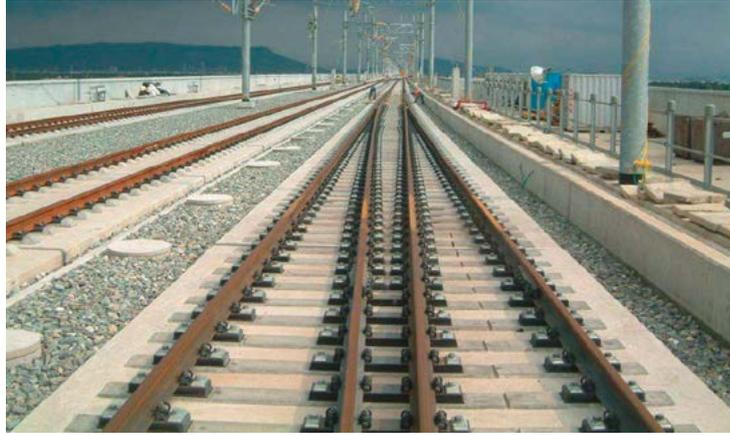
Figure A3-3 : Voie sur dalle béton - Rheda
