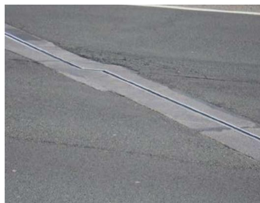
Figure 2-46 : Discontinuité déconseillée entre les joints transversaux
