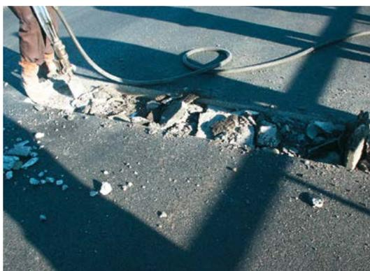
Figure 4-8 : Dépose du revêtement au droit du futur joint de chaussée
