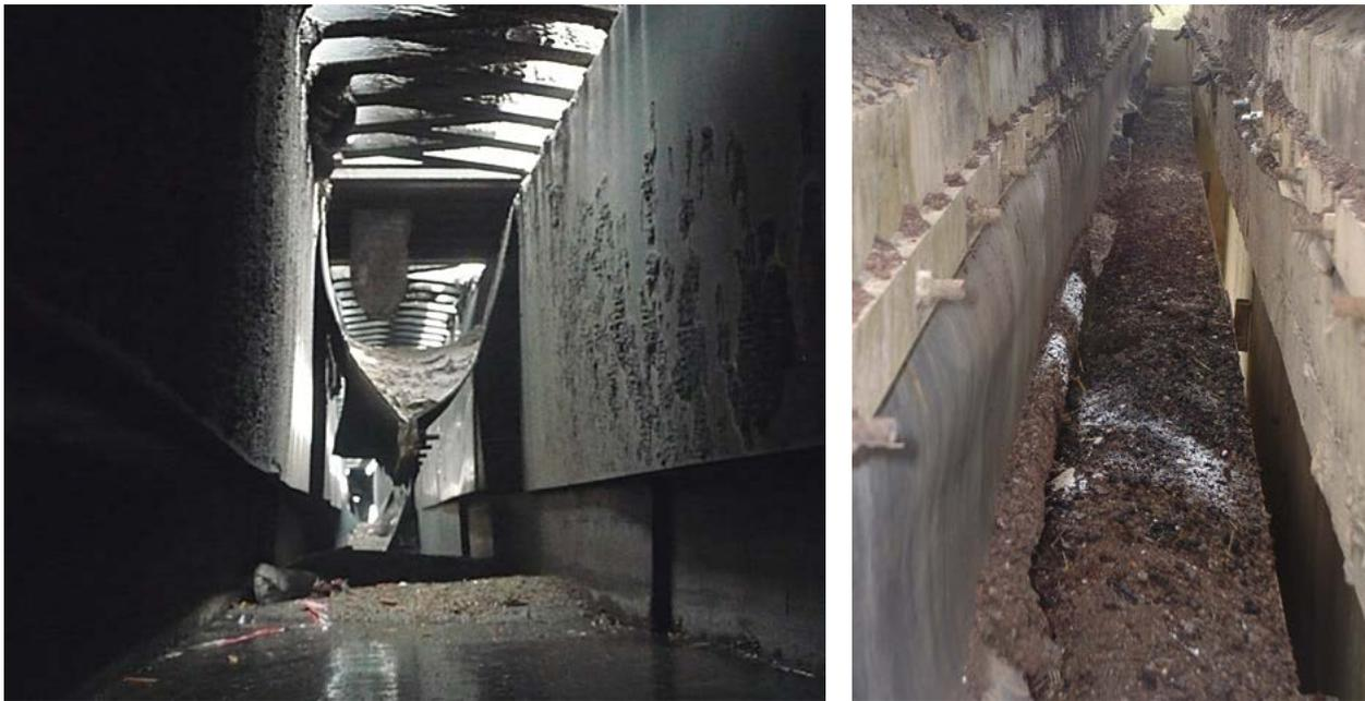
Figure 2-11 : Encrassement d'une bavette (à gauche) et d'une goulotte (à droite)
