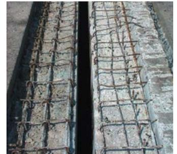
d) Mise en place du coffrage (par polystyrène expansé ou contreplaqué) et du ferrailage complémentaire
