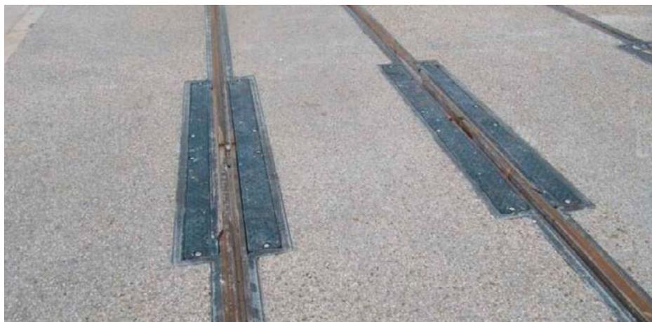
Figure A3-8 : Appareils de dilatation pour rail à gorge (voies de tramway)
