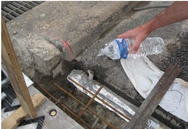
Figure 4-22 : Test du bon fonctionnement du drain
