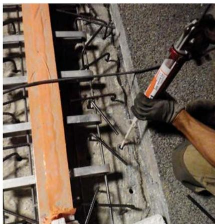
Figure 4-27 : Injection de produit de scellement dans les trous d'ancrage
