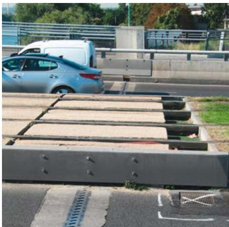
Figure 2-33 : Joints de dilatation sur voiries séparées (joint de plateforme avec caillebotis)
