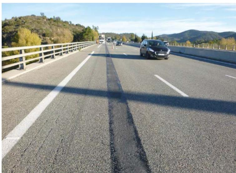
Figure 2-44 : Illustration d'une position n° 4 - Joint à revêtement amélioré longitudinal situé en dehors des bandes de roulement
