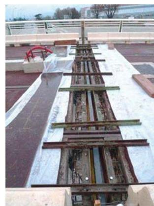
Figure 2-38 : Pose du joint de dilatation
