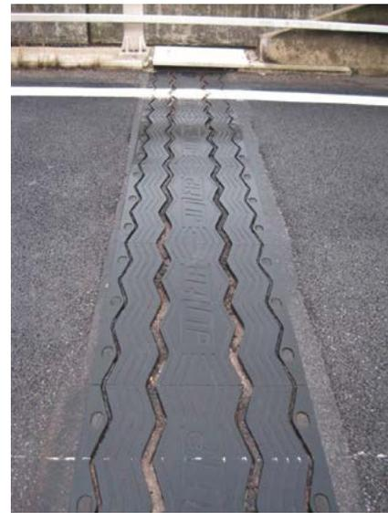
Figure 1-9 : Exemples de joints à bande ou à matelas (simple à gauche et multiple à droite)
