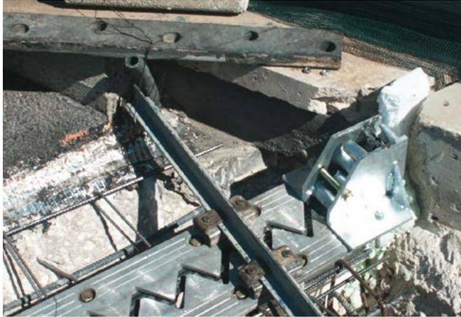
Figure 4-21 : Fermeture de l'étanchéité et mise en place de l'évacuation du drain derrière la bordure
