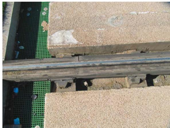
Figure 2-34 : Joint de dilatation décalé sur plateforme avec selles de fixation du rail
