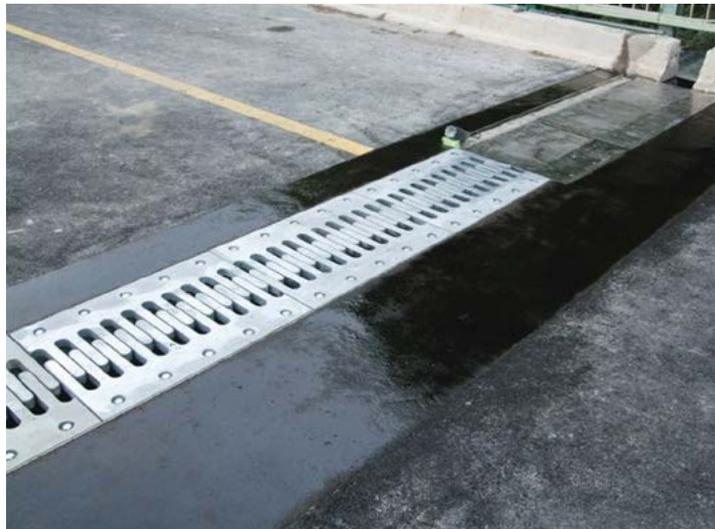
Figure 3-13 : Exemple d'un joint à pont en bandes équipé de bandes rugueuses à gauche et d'un joint à peigne équipé d'une plaque métallique au droit d'une zone cyclable à droite
