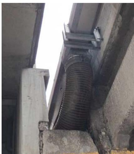
Figure 2-41 : Dispositif de dilatation de réseaux
