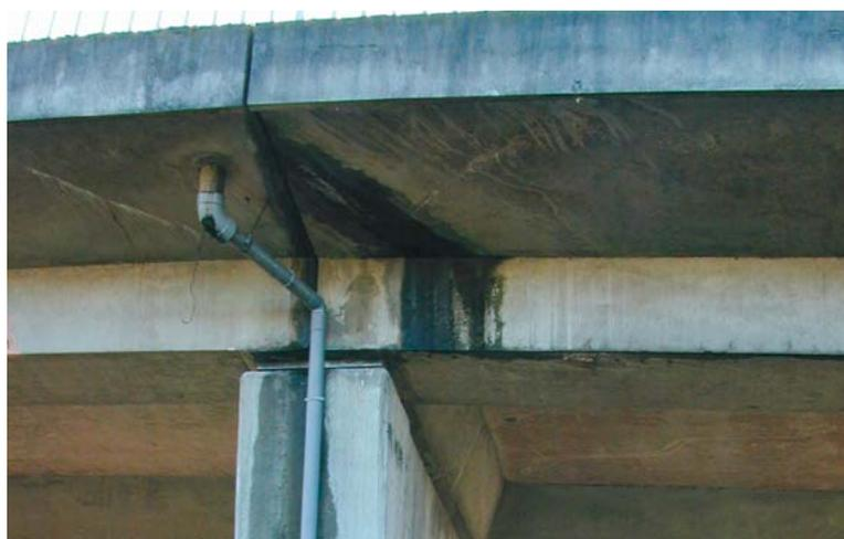
Figure 2-17 : Exemple d'une défaillance de l'étanchéité au droit du joint de trottoir
