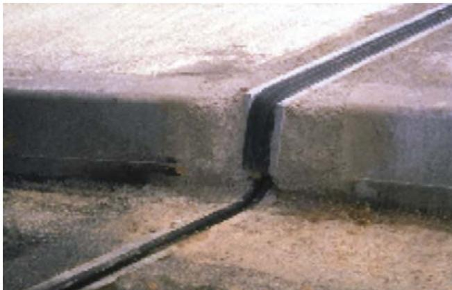
Figure 2-22 : Relevé de joint de chaussée, recouvert en tuile par la retombée de joint de trottoir
