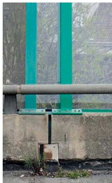
Figures 2-40 : Dispositif de dilatation d'écrans antibruit
