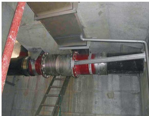
Figure 2-39 : Dispositif de dilatation d'une conduite d'évacuation
