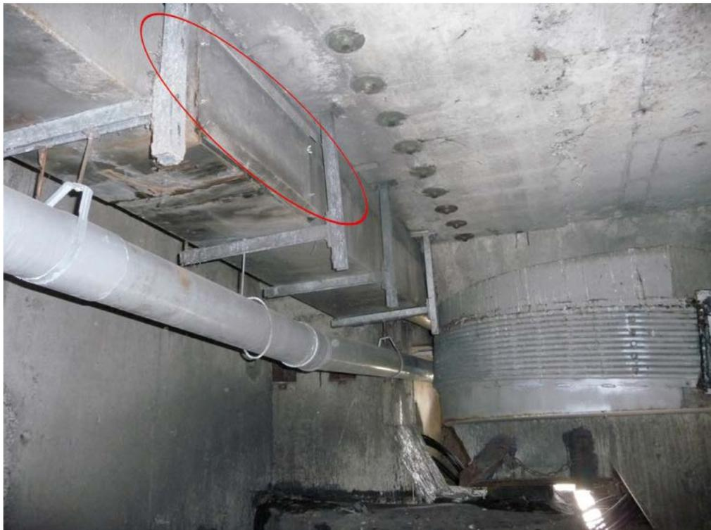
Figure 2-8 : Trappe de visite et d'entretien d'un chéneau de récupération
