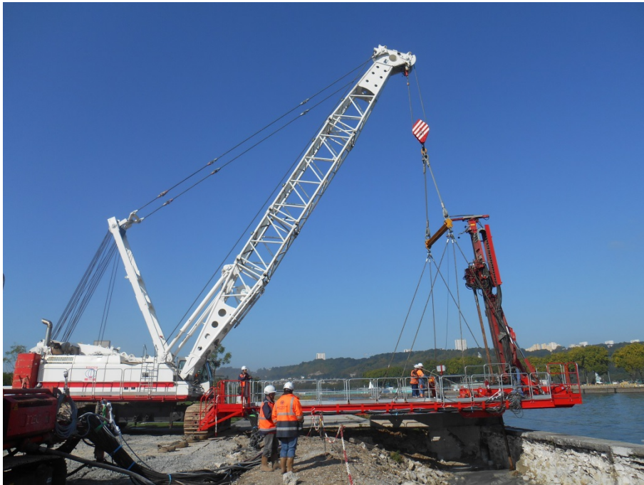
Foreuse type « hi-drill » portée sur plateforme minimise les vibrations sur l'ouvrage
