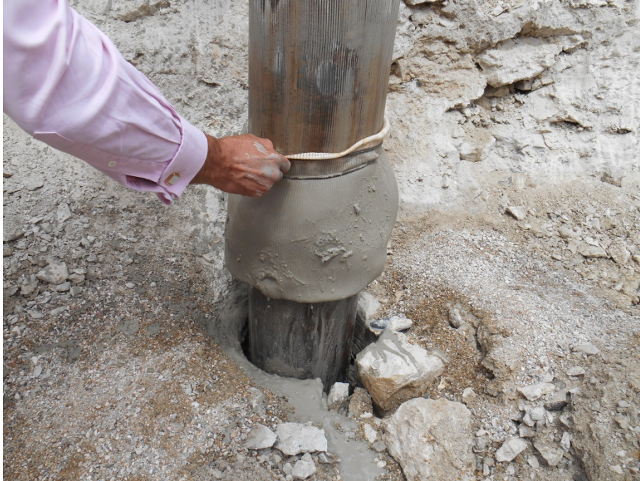
Chaussette géotextile remplie de coulis
