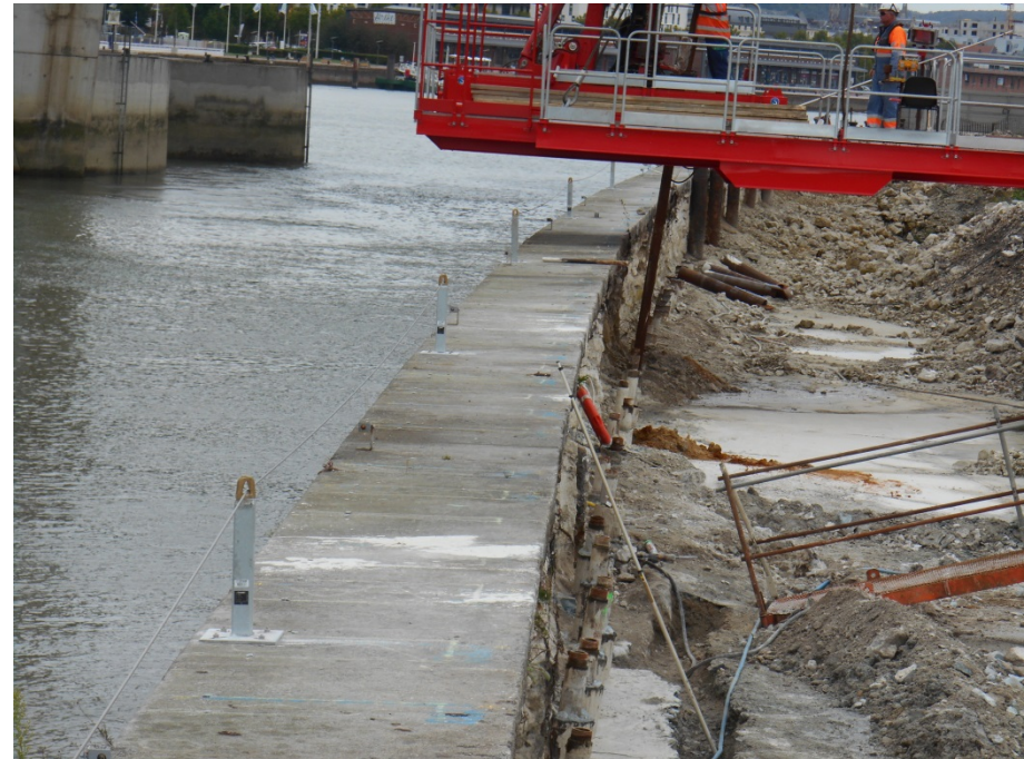
Micropieux dans les pré-tubes
