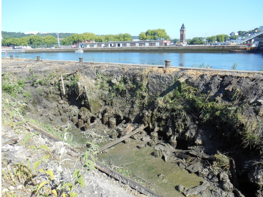
Quai sur pieux bois avec tirants métalliques
