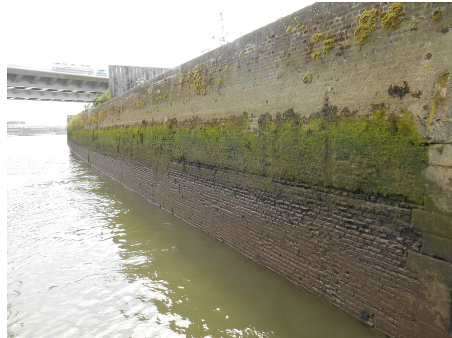
Mur de quai vu de l'aval marée basse
