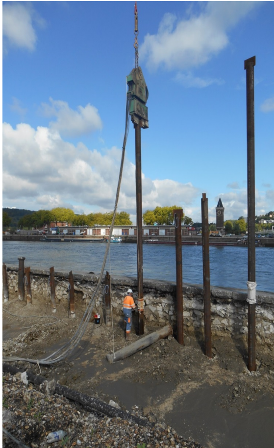
Mise en place des pré-tubes par vibrofonçage
