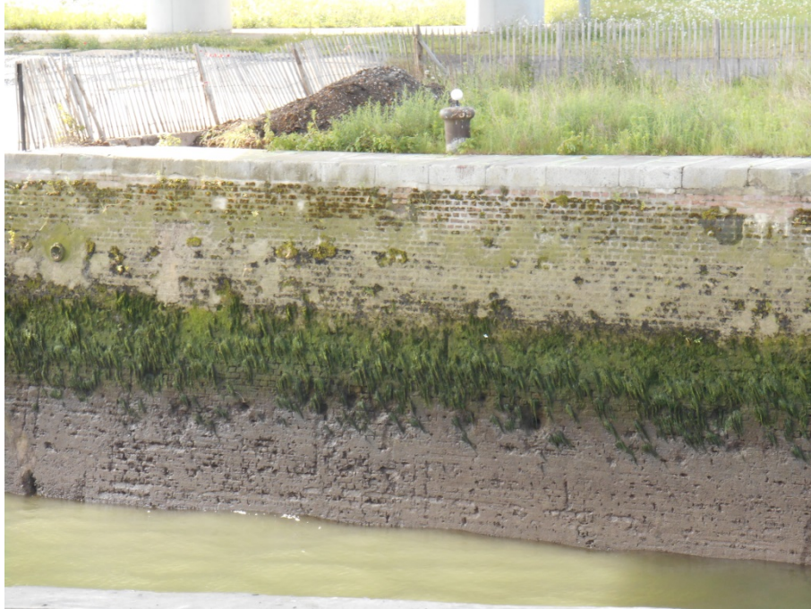
Mur de quai amont marée basse
