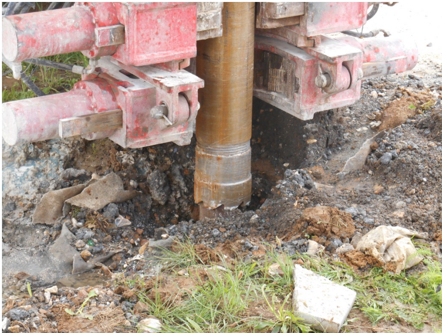
forage autour du micropieu
