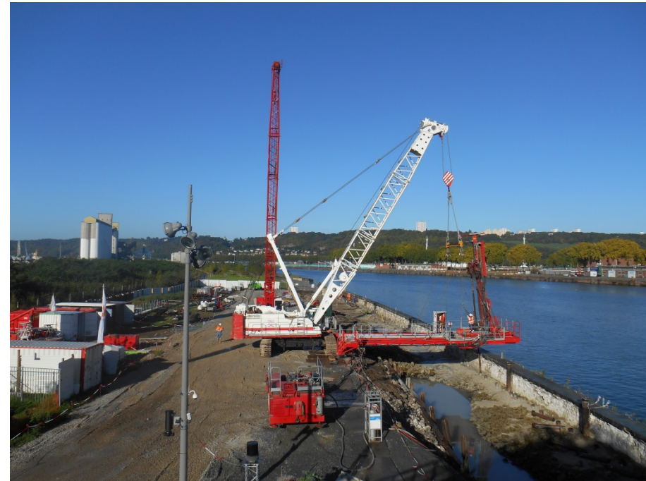
Vue d'ensemble du chantier
