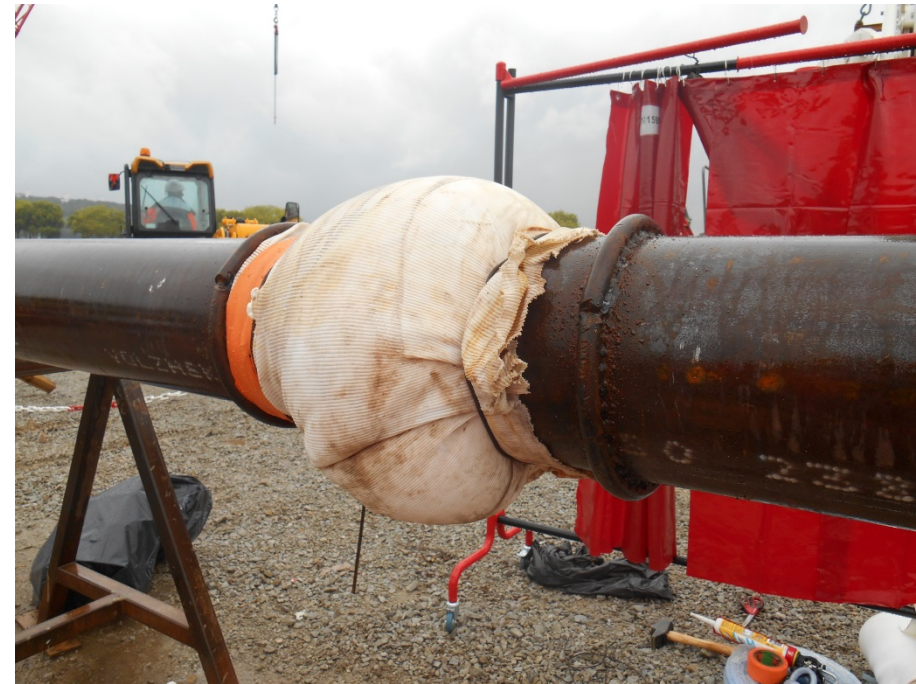
Chaussette géotextile remplie de résine expansive
