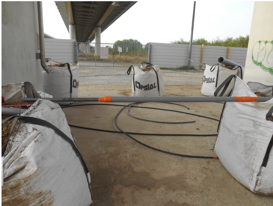
Préparation du scellement sur 1m de hauteur
