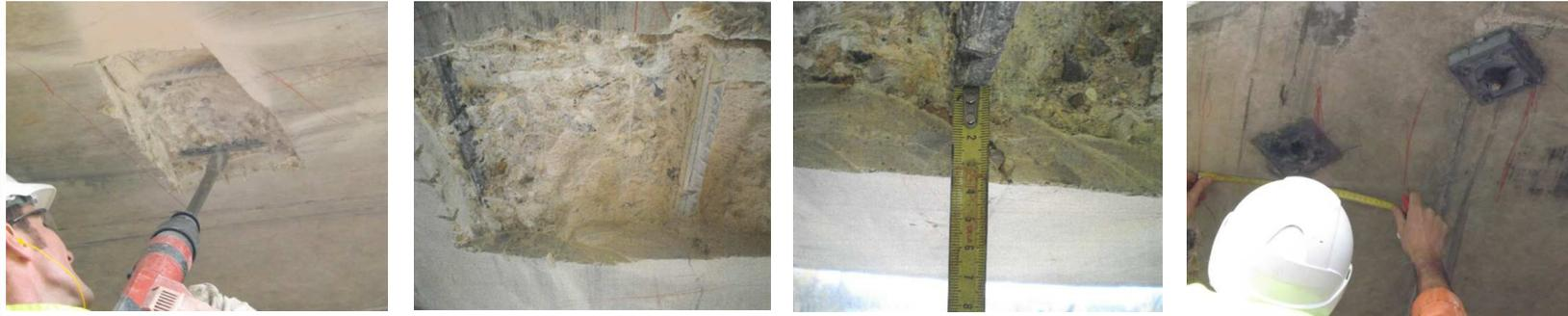
Ouverture d'une fenêtre pour calibrer l'appareil de mesure utilisé (Ferroscan Hilti)
