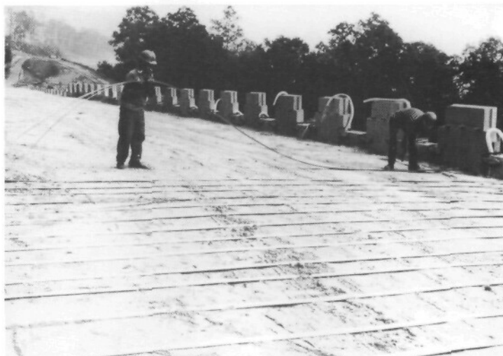
Fig. 1-3 : Pose d'un lit d'armatures
