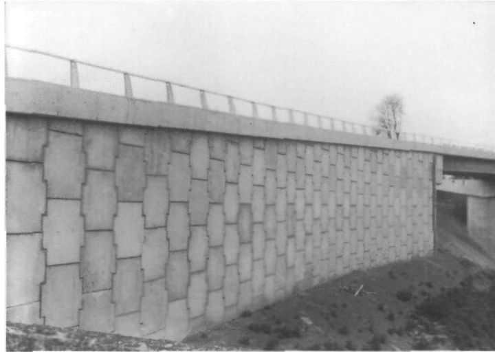
Fig. 1-6 : Ouvrage à parement en écaille de béton
