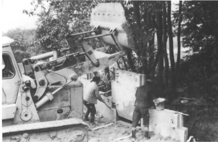
Fig. 1-1 : Mise en place d'une rangée d'écaillles
