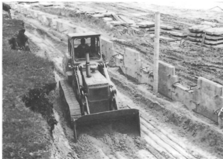
Fig. 1-2 : Mise en place d'une couche de remblai
