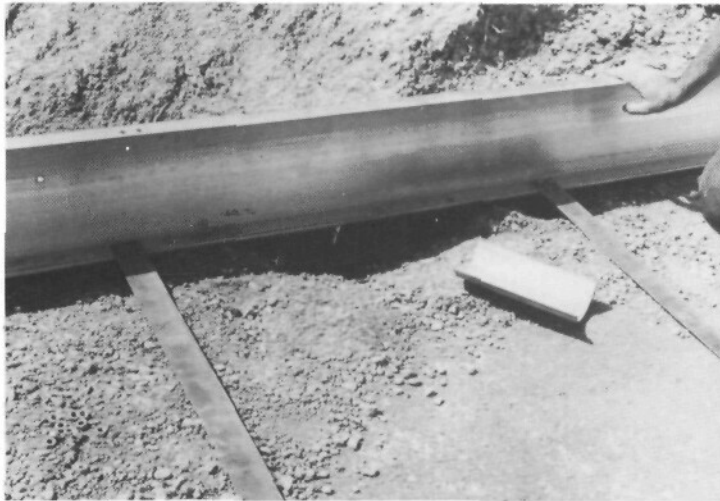
Fig. 1-8 : Élément de parement métallique et armatures lisses
