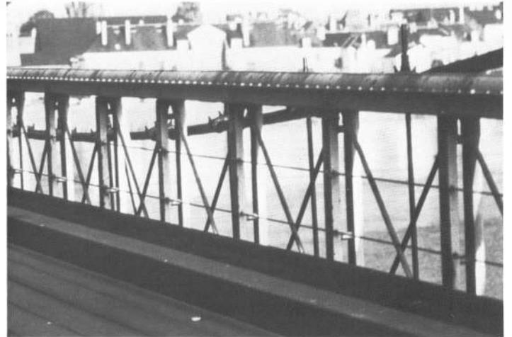
Poutres de rigidité. Déformation localisée de la membrure supérieure.
