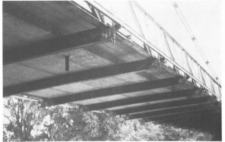
Poutre à treillis reposant sur les pièces de pont (avec contrefiches).
