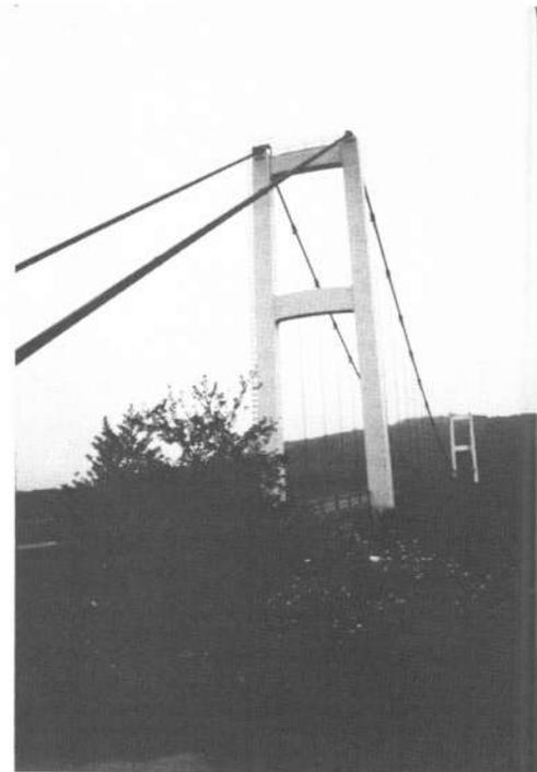
Pylônes flexibles en béton armé.
