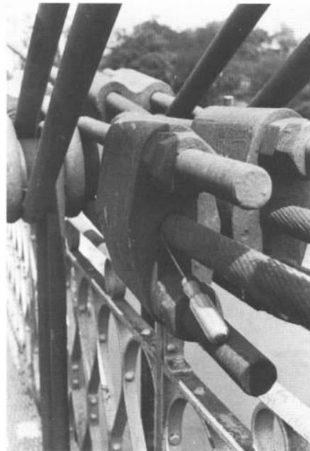
Mauvais remplissage de culot.
