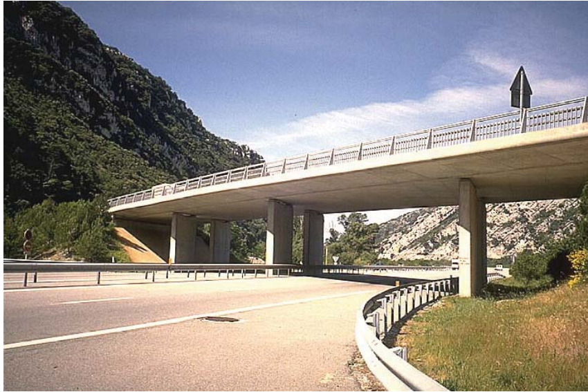
Passage supérieur en dalle précontrainte
