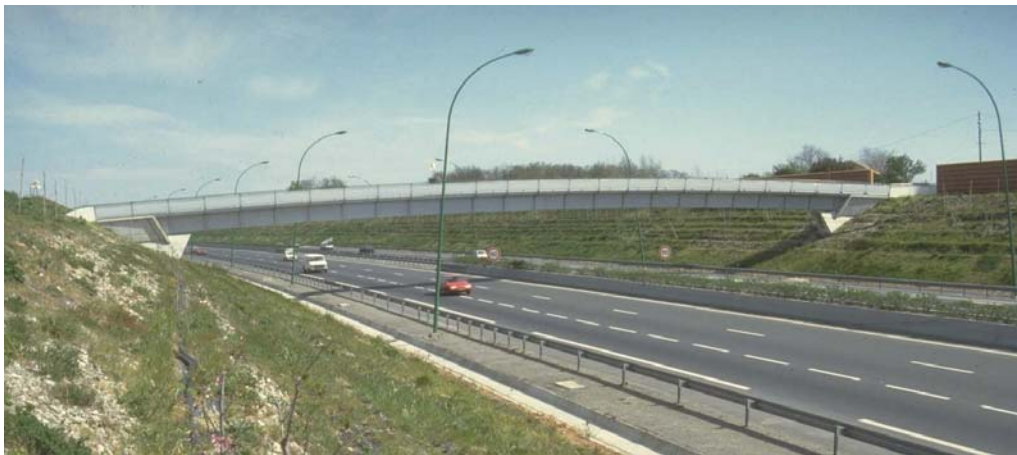
Passerelle en métal pour piétons
