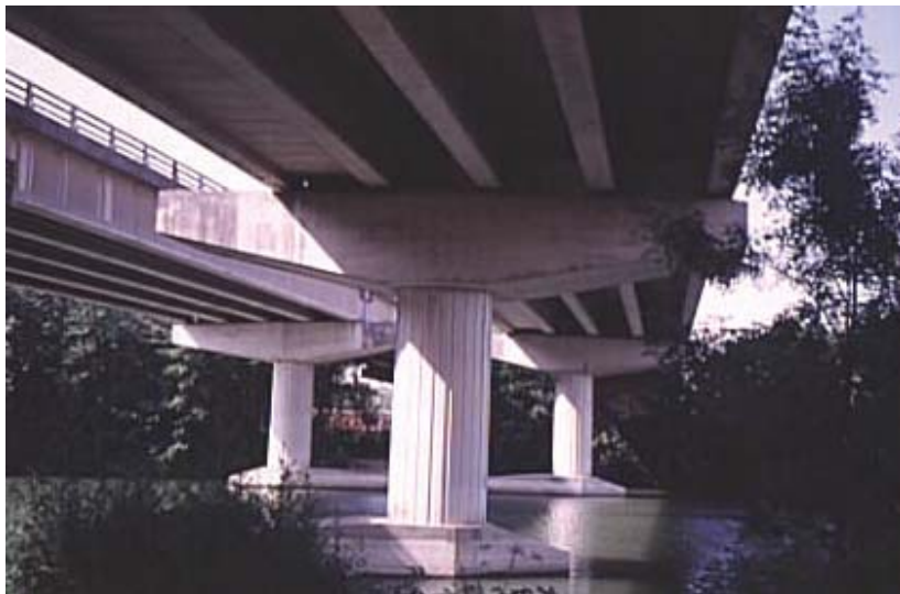
Viaduc indépendant à poutres précontraintes
