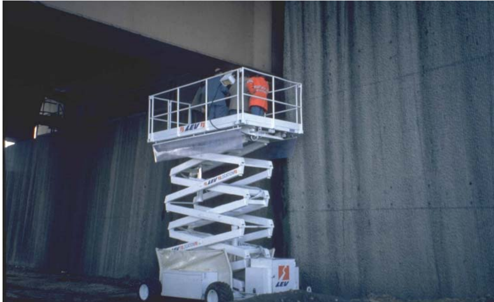
Inspection d'un appui de culée
