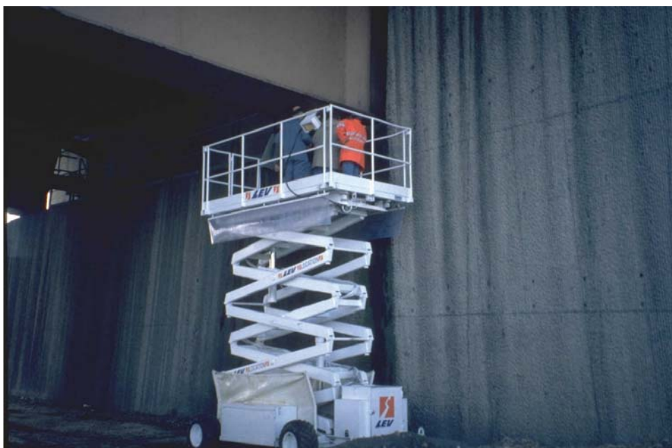
Inspection des appuis d'une culée de pont
