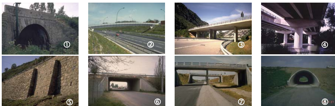
① Pont en maçonnerie, ② Passerelle piétons en métal, ③ Passage supérieur en dalle précontrainte, ④ Viaduc, Setra/Seine-et-Marne ⑤ Mur de soutènement, ⑥ Passage inférieur en portique ouvert, ⑦ Portique ouvert double, ⑧ Buse.
