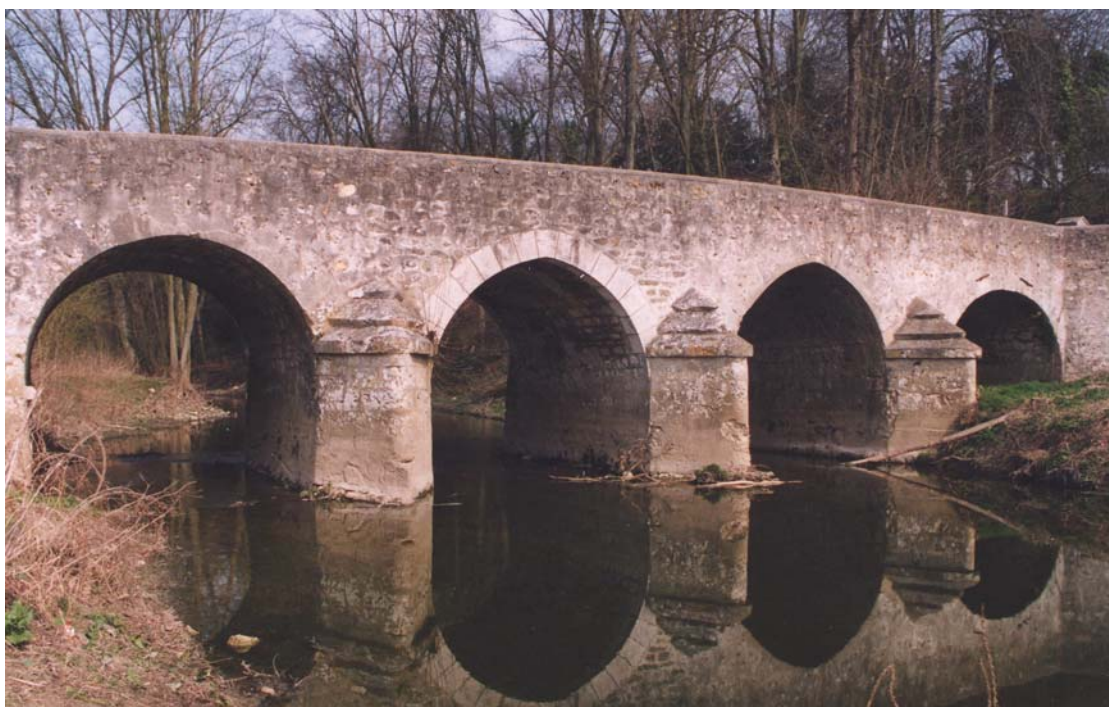
Pont en maçonnerie
