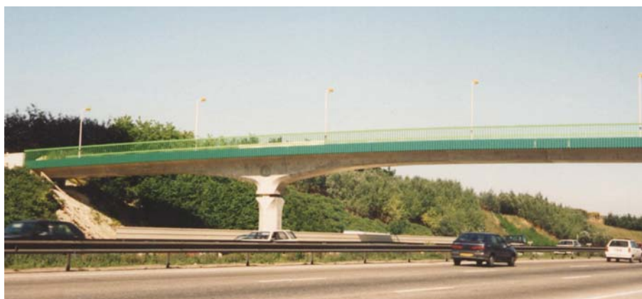
Passerelle au-dessus de l'autoroute
