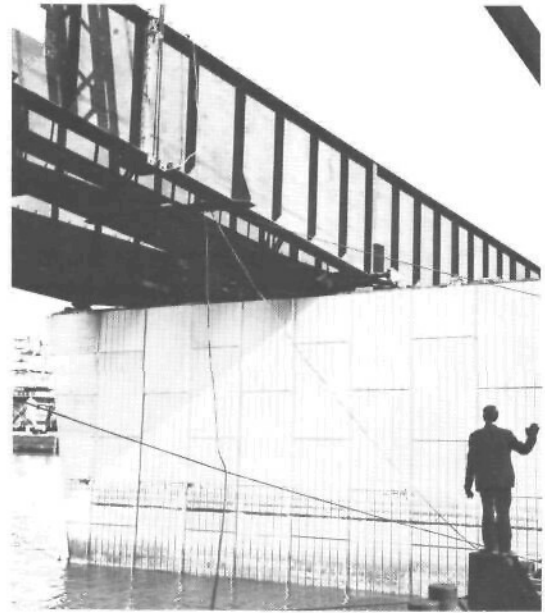
Photo 45 : Sur la poutre extérieure, le montant provisoire est visible entre les semelles inférieure et supérieure. Le câble qui entoure la poutre passe sous la semelle inférieure qui est protégée par un berceau.
