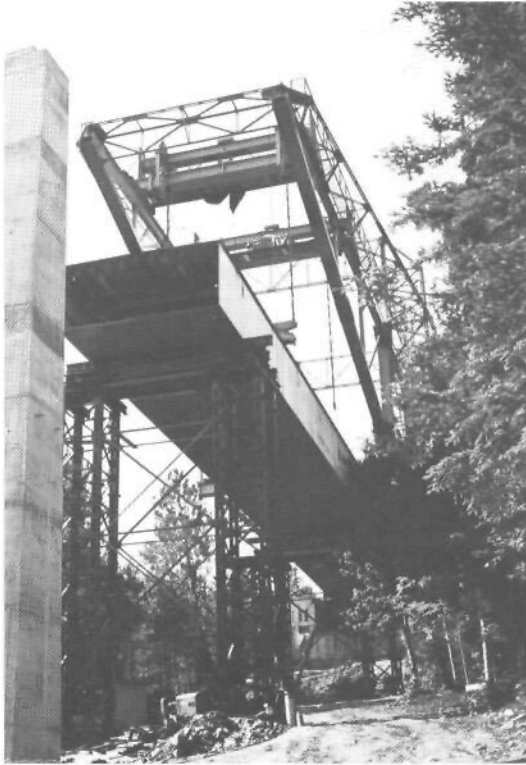
Photo 88 : Contreventement réalisé entre les deux fûts de palée.
