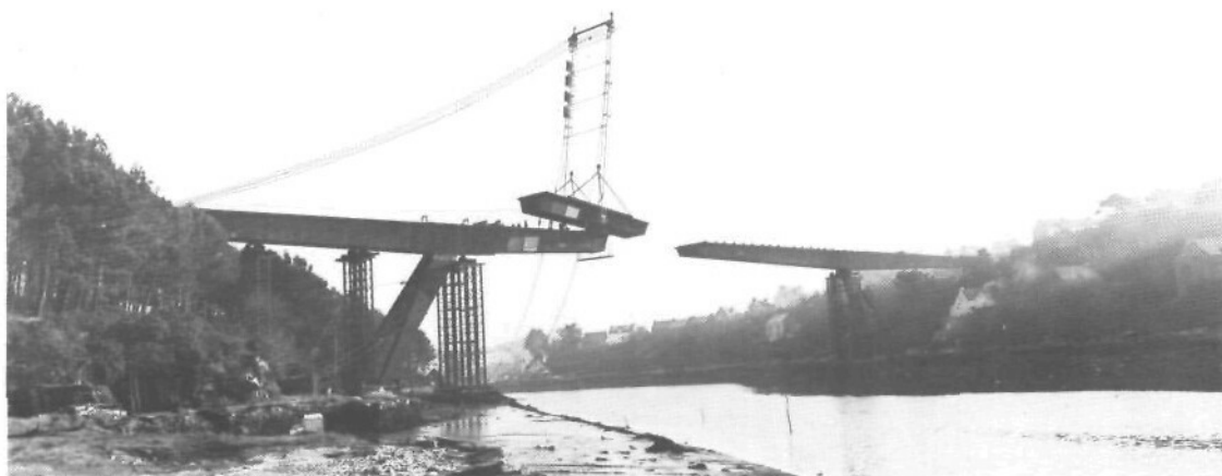
Photo 25 : Mise en place du tronçon de clavage, d'un poids de 40 tonnes environ et de 18 mètres de longueur.
