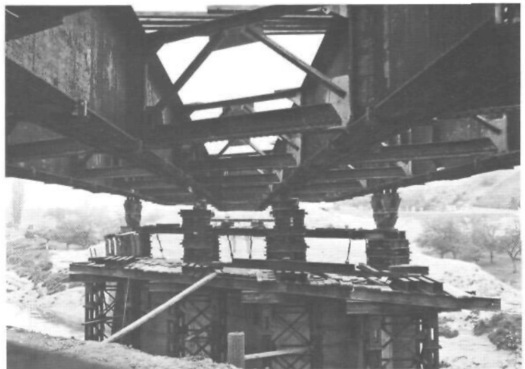
Photo 2 : Chaises à 4 galets pour 3 balanciers. Les membrures inférieures des poutres sont munies d'un profilé en U amovible, pour le guidage.
