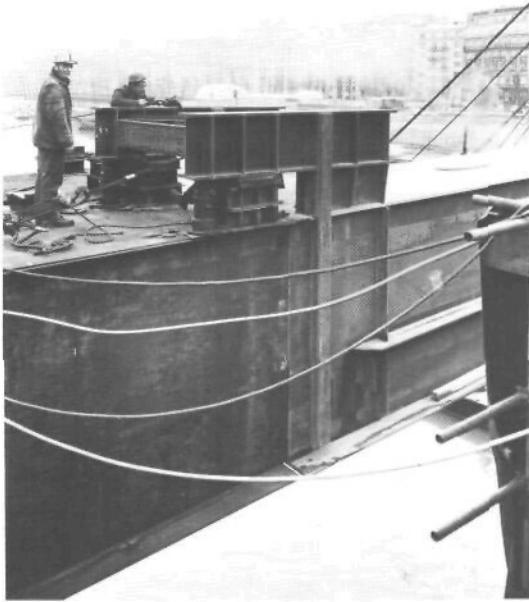
Photo 44 : Le tronçon de droite équipé de son corbeau vient reposer sur le tronçon de gauche, déjà mis en place. Après réalisation de l'assemblage, les corbeaux seront éliminés.
