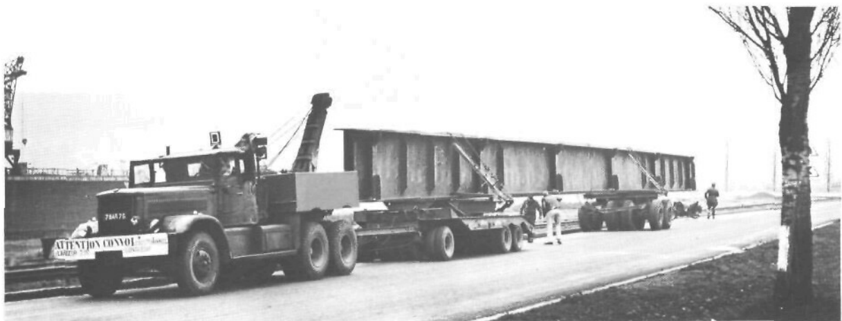
Photo 75 : Poutre en I équipée d'étais.
