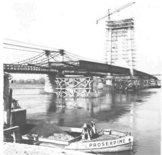
Photo 50 : Lancement du tablier sur palées intermédiaires. Le tablier est équipé d'un avant-bec.
