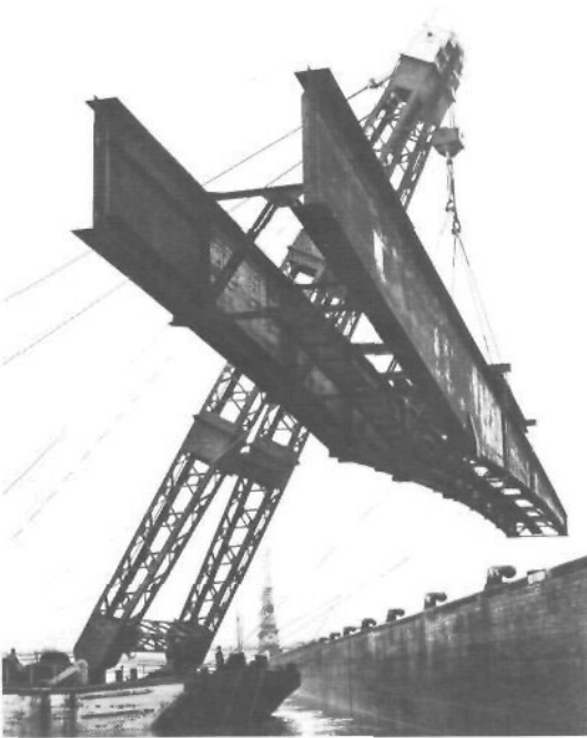
Photo 40 : L'entretoisement de deux poutres en I résoud les difficultés de stabilité des poutres. Il impose par l'encombrement du tronçon, l'emploi d'une bigue de fort tonnage (150 tonnes).
