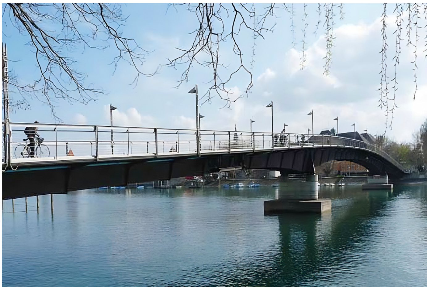
Passerelle sur le Rhin à Constance en Allemagne (Source : J.-M. Morel)
