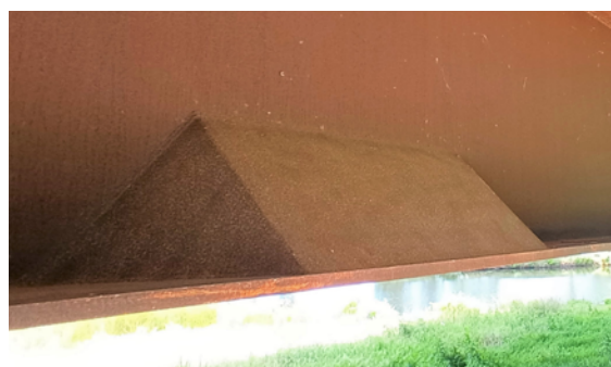
e : Tôle inclinée soudée sur la semelle inférieure de la poutre
