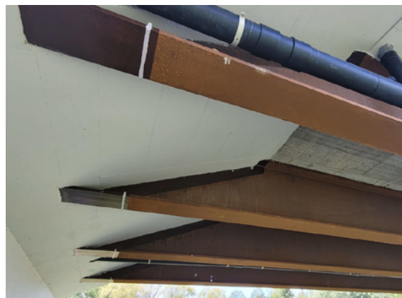
Figure 7 : Exemples de détail de l'about des poutres d'un ouvrage de type semi-intégral à Wirkowice en Pologne et sur un pont intégral sur la route DP-2510R à Jasło en Pologne (Source : ArcelorMittal)
