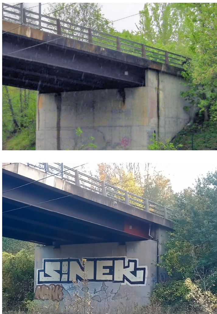
Figure 1 : Suppression des murets caches sur les culées et mise en peinture des extrémités de poutres sur un ouvrage à Conches sur Ouche (Source : Univ. Eiffel)
