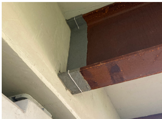
Figure 7 : Exemples de détail de l'about des poutres d'un ouvrage de type semi-intégral à Wirkowice en Pologne et sur un pont intégral sur la route DP-2510R à Jasło en Pologne (Source : ArcelorMittal)
