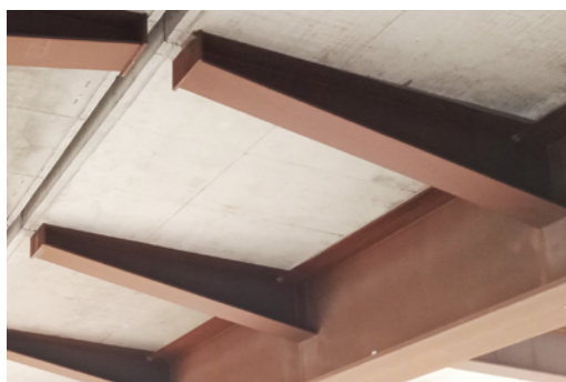
b : Platines d'extrémité de console
