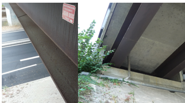
c : Cordons de soudure anti-ruissellement
