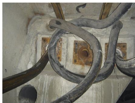
*Déformation de câbles 19T15 lors d'un démontage*
