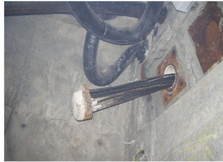
*Expulsion de l'extrémité d'un câble 19T15 lors d'un démontage*
