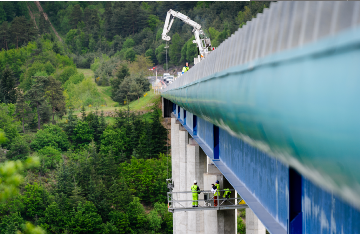
Inspection des piles du viaduc du Lignon
