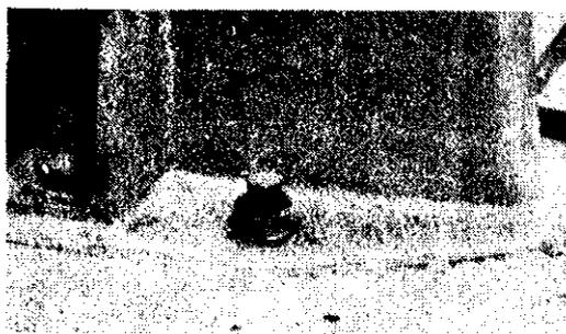
Mise en place de la rondelle COMPRIGUM, de la rondelle et de la vis.
