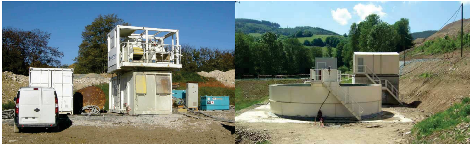
Illustrations 27 et 28 - Exemple de traitement proposé. Stations de traitement des eaux de chantier, pour éliminer les MES par système de floculation-décantation.
