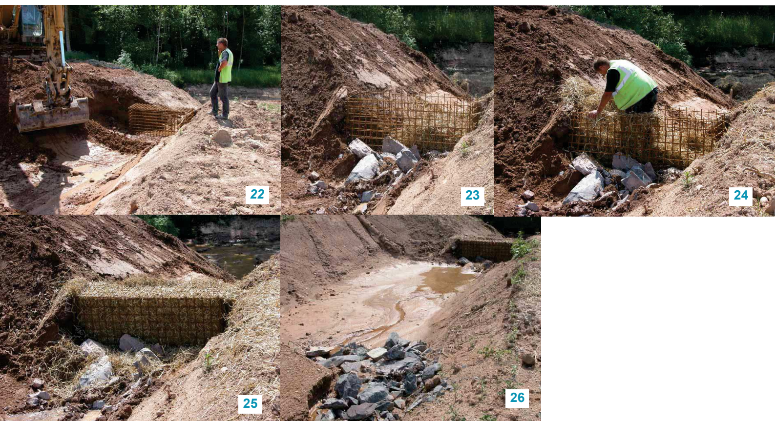
22 - Réalisation d'une « cage » ouvrable en treillis soudé, ouverture sur le dessus, et creusement du bassin en amont
