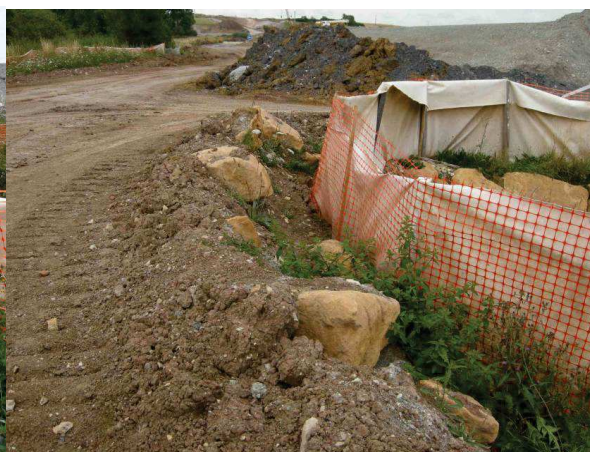
Illustration 8 - Merlons de protection des milieux aquatiques contre les eaux de ruissellement.
