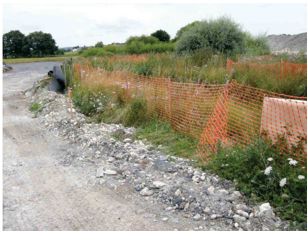
Illustration 8 - Merlons de protection des milieux aquatiques contre les eaux de ruissellement.
