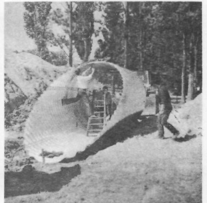
Vues du montage d'une buse ARVAL, de 2,50 m de diamètre, montrant les différentes phases.
