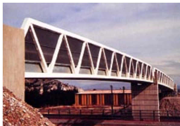
Photo A.4.1 : passerelle de Cavaillon – Source : Michel Leber (Matière TP)
