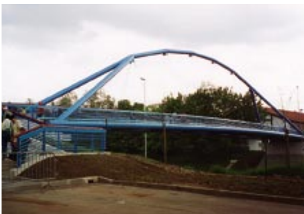
Photo A.4.4 : passerelle de Montigny-lès-Cormeilles Source : Gérard Forquet (Sétra)
