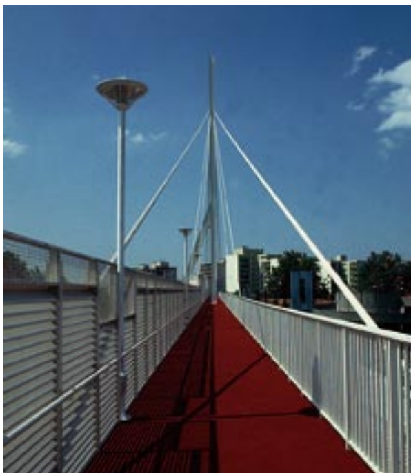
Photo A.4.7 : passerelle du Pas du Lac – Source : architecte Alain Spielmann
