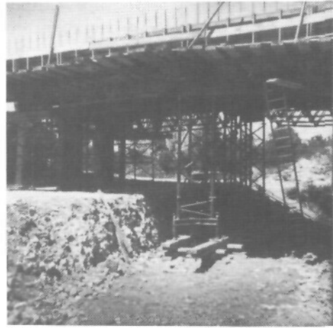
étaielement horizontal (à poutres)
