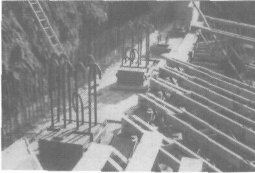
Appareil mis en place
